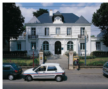
Façade sud de la mairie annexe actuellement hôtel des impôts. Phot. Denis Pillet IVR52_19984402377XA
