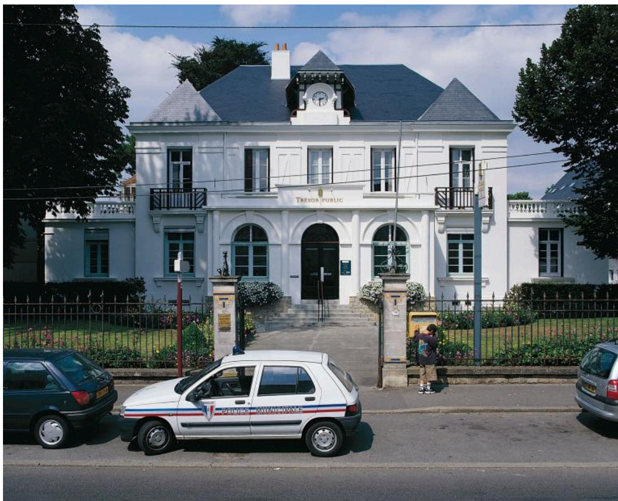
Façade sud de la mairie annexe actuellement hôtel des impôts.
