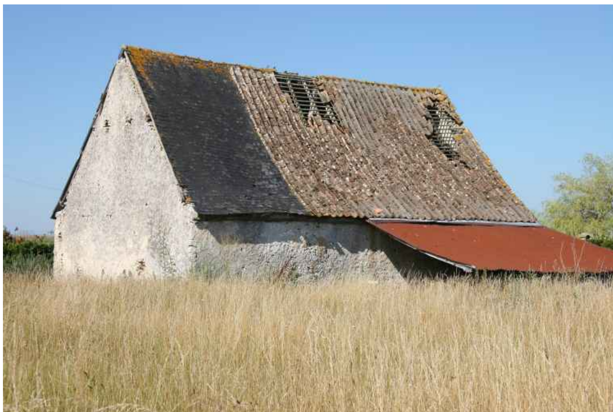
La grange : couverture de tuiles courbes.
