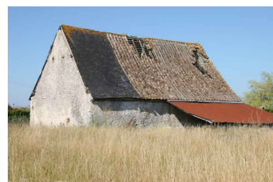
La grange : couverture de tuiles courbes. Phot. Jean-Baptiste Darrasse
