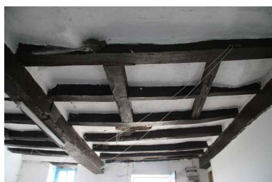
Salle gauche : plafond. Phot. Jean-Baptiste Darrasse IVR52_20067206555NUCA
