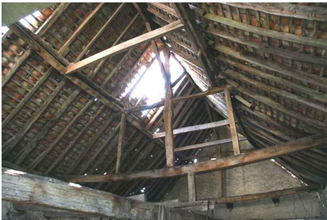
Charpente de la grange étable.
