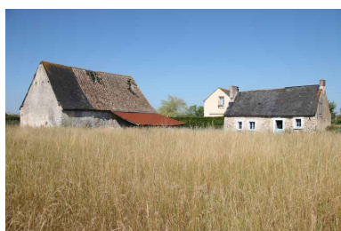
Vue de volume de la maison et de la grange. Phot. Jean-Baptiste Darrasse IVR52_20067206548NUCA
