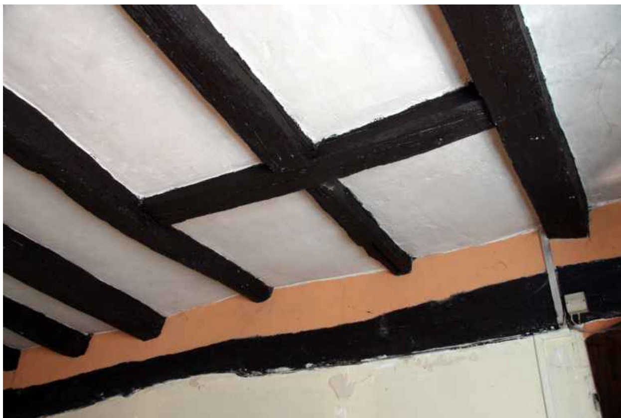
Salle gauche : plafond.
