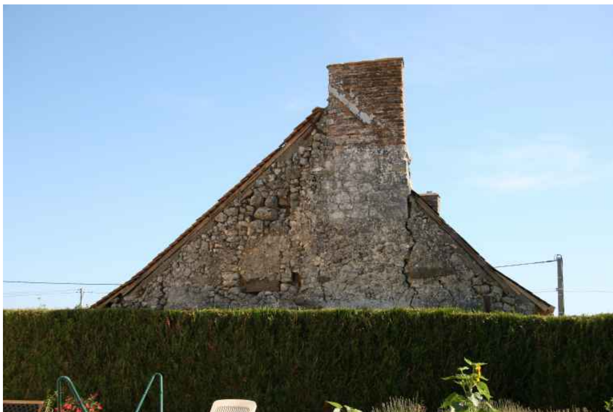
Pignon gauche : souche de cheminée en pierre puis chantignolles.
