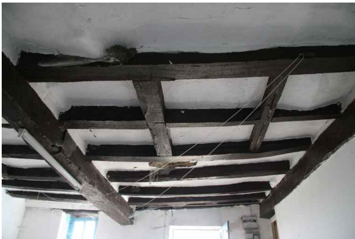
Salle gauche : plafond.
