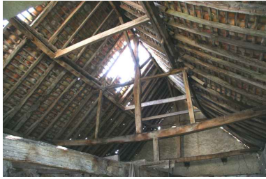
Charpente de la grange étable. Phot. Jean-Baptiste Darrasse IVR52_20067206552NUCA
