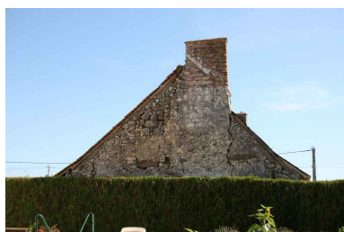
Pignon gauche : souche de cheminée en pierre puis chantignolles. Phot. Jean-Baptiste Darrasse IVR52_20067206557NUCA
