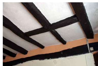
Salle gauche : plafond. Phot. Jean-Baptiste Darrasse IVR52_20067206554NUCA
