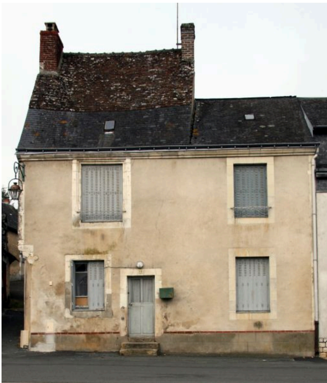
Façade antérieure sur rue.
