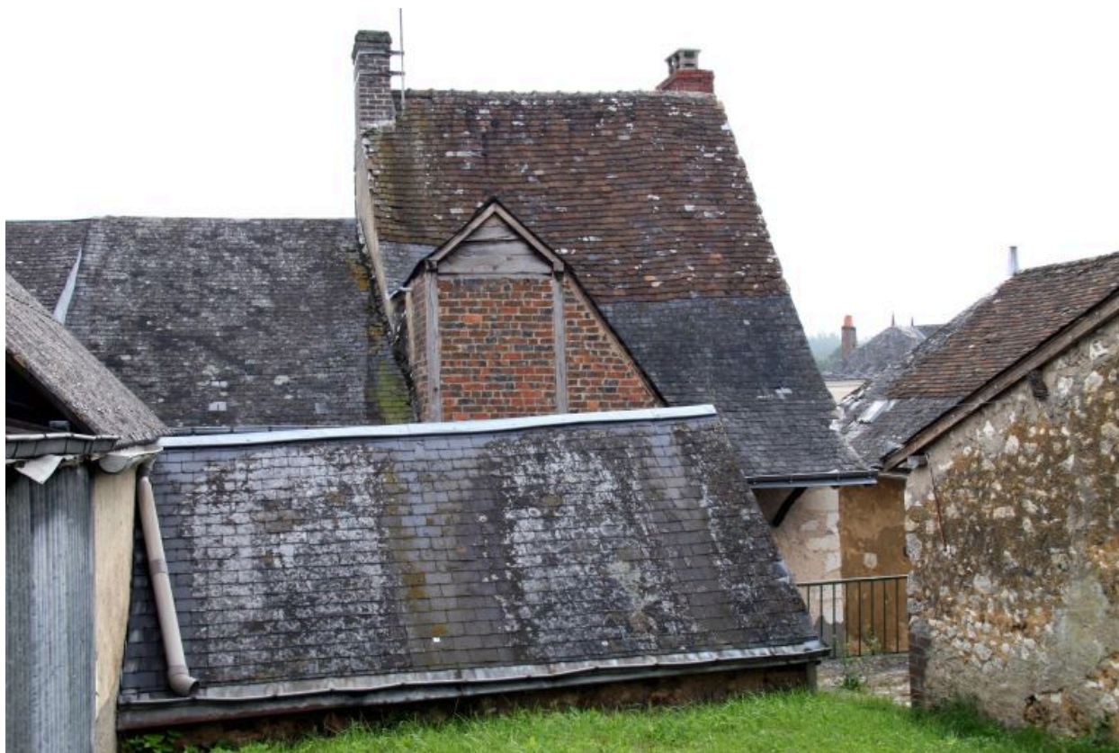
Façade postérieure prise de la terrasse.
