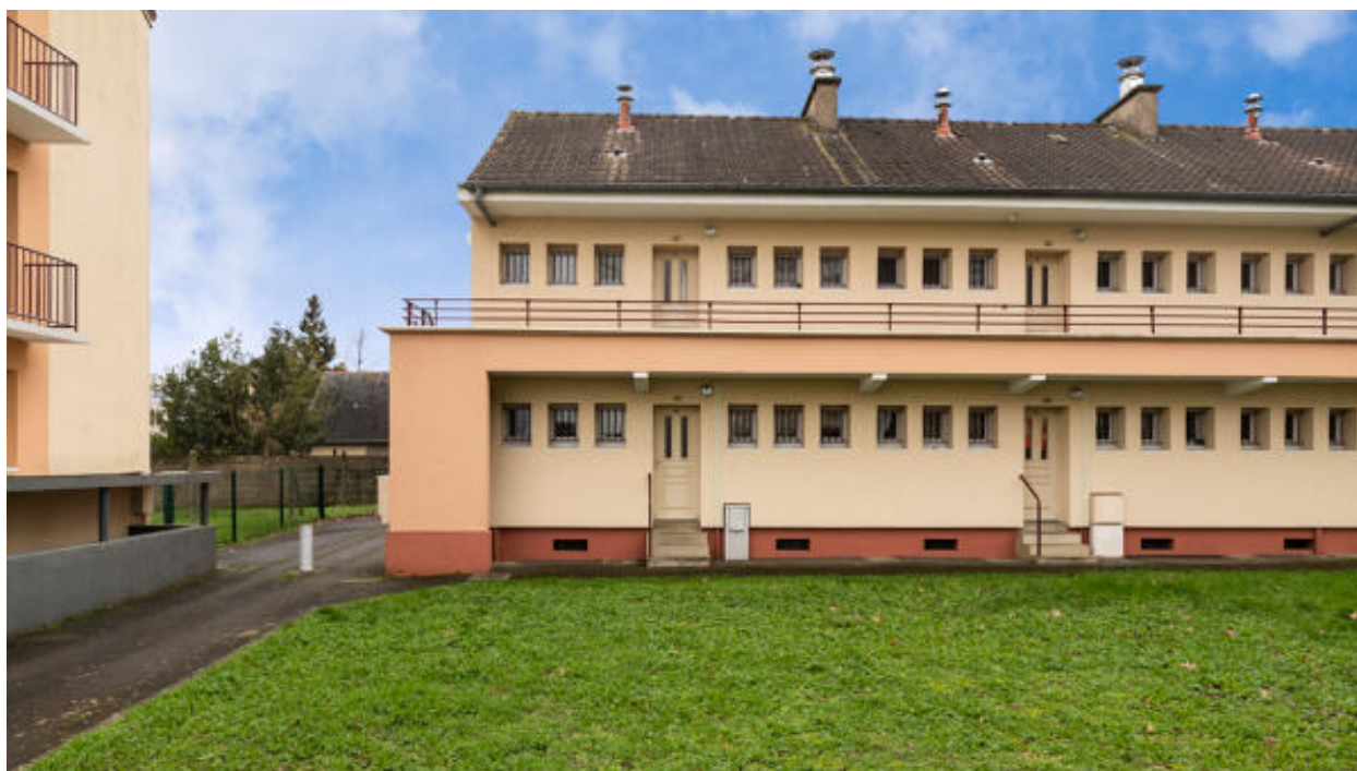
Vue d'un immeuble de type A de la cité Joly.
