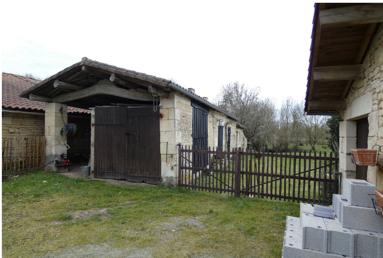
Les dépendances au sud de l'ensemble vues depuis le nord.
