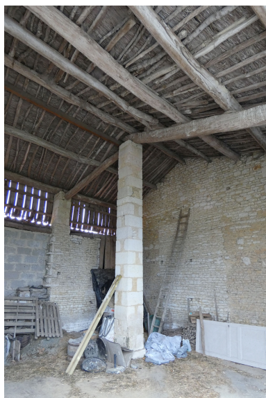
Le pilier en pierre soutenant la charpente et le toit du hangar. Phot. Yannis Suire IVR52_20238500822NUCA
