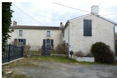
Le logis vu depuis l'ouest. Phot. Yannis Suire IVR52_20238500811NUCA
