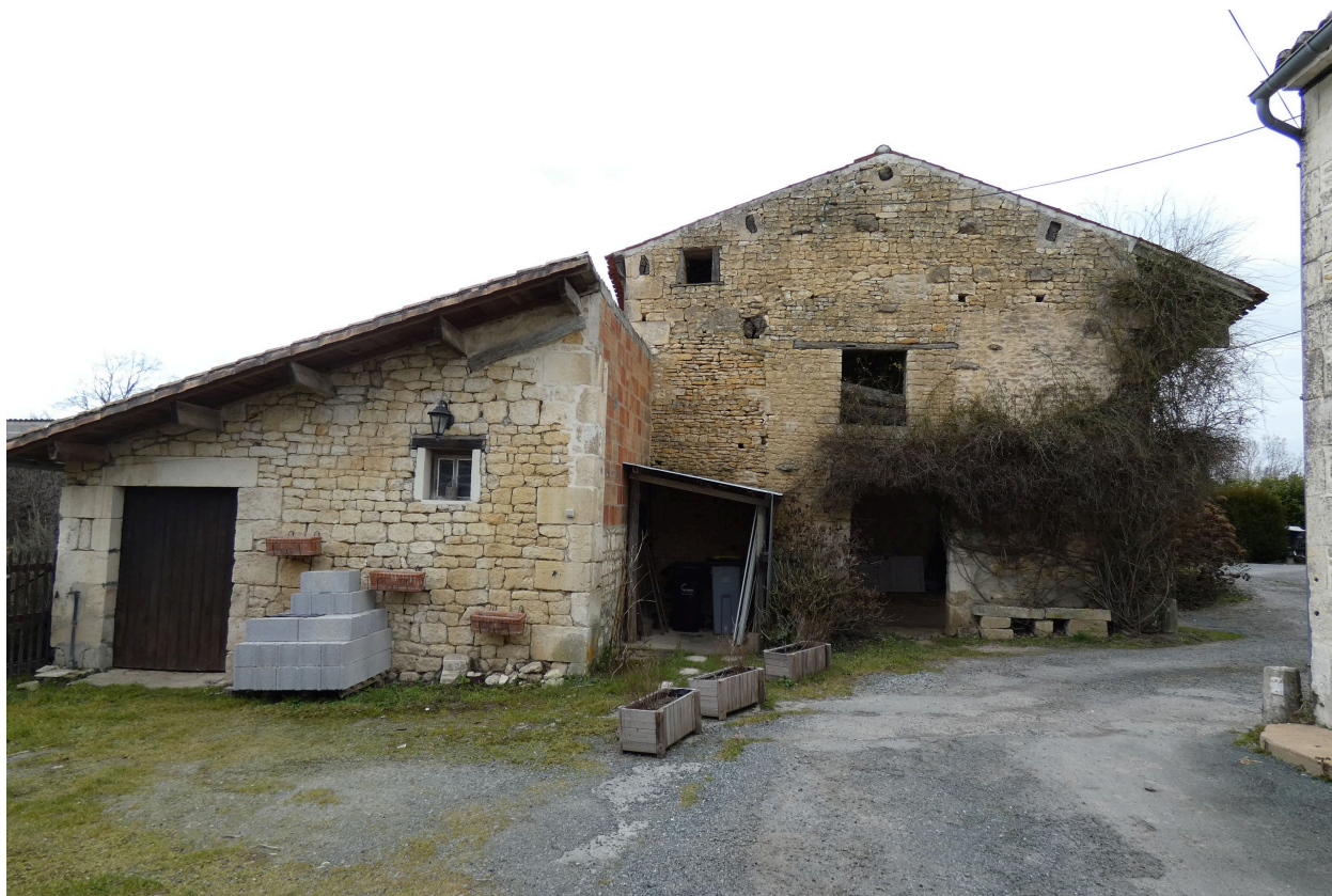
Les dépendances à l'ouest de l'ensemble, dont le hangar en pierre, vus depuis l'est.
