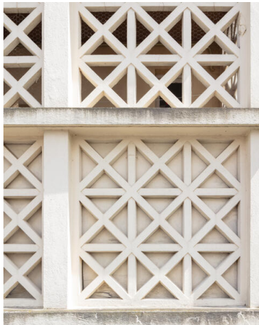
Détail du béton moucharabieh de la travée centrale du bâtiment A. Phot. Paul Hamelin IVR52_20227200609NUCA
