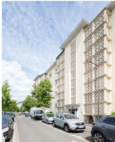
Vue de la façade principale du bâtiment A. Phot. Paul Hamelin IVR52_20227200607NUCA
