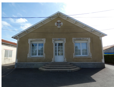
La façade, placée sur le mur pignon et structurée symétriquement. Phot. Yannis Suire IVR52_20228500209NUCA
