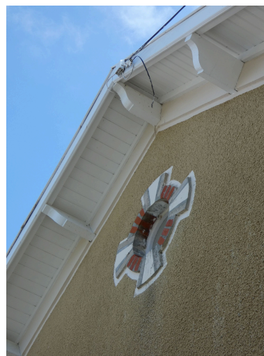
Le débordement de toit et l'oculus. Phot. Yannis Suire IVR52_20228500210NUCA
