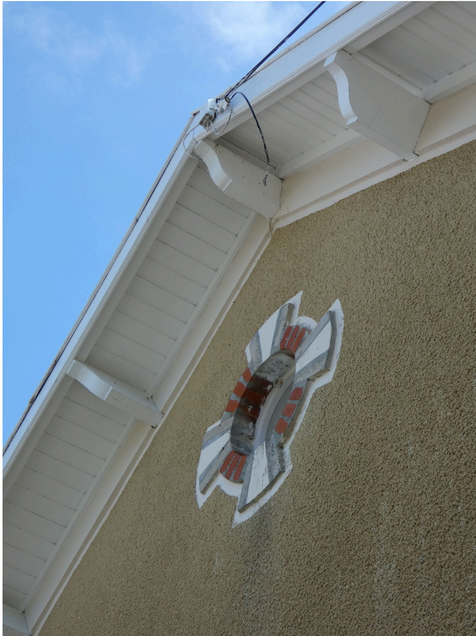
Le débordement de toit et l'oculus.
