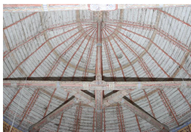
Le lambris de couverture au-dessus du chœur. Phot. Patrice Giraud IVR52_20037200096NUCA
