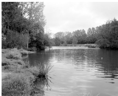
Le barrage et le pertuis des Communes vus de la rive droite de la Mayenne en aval. Phot. François Lasa IVR52_20015300554X
