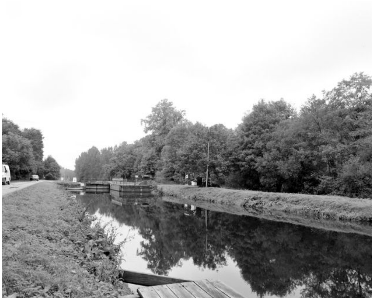
Le canal, l'écluse, la centrale hydroélectrique, le transformateur et la digue vus du nord.
