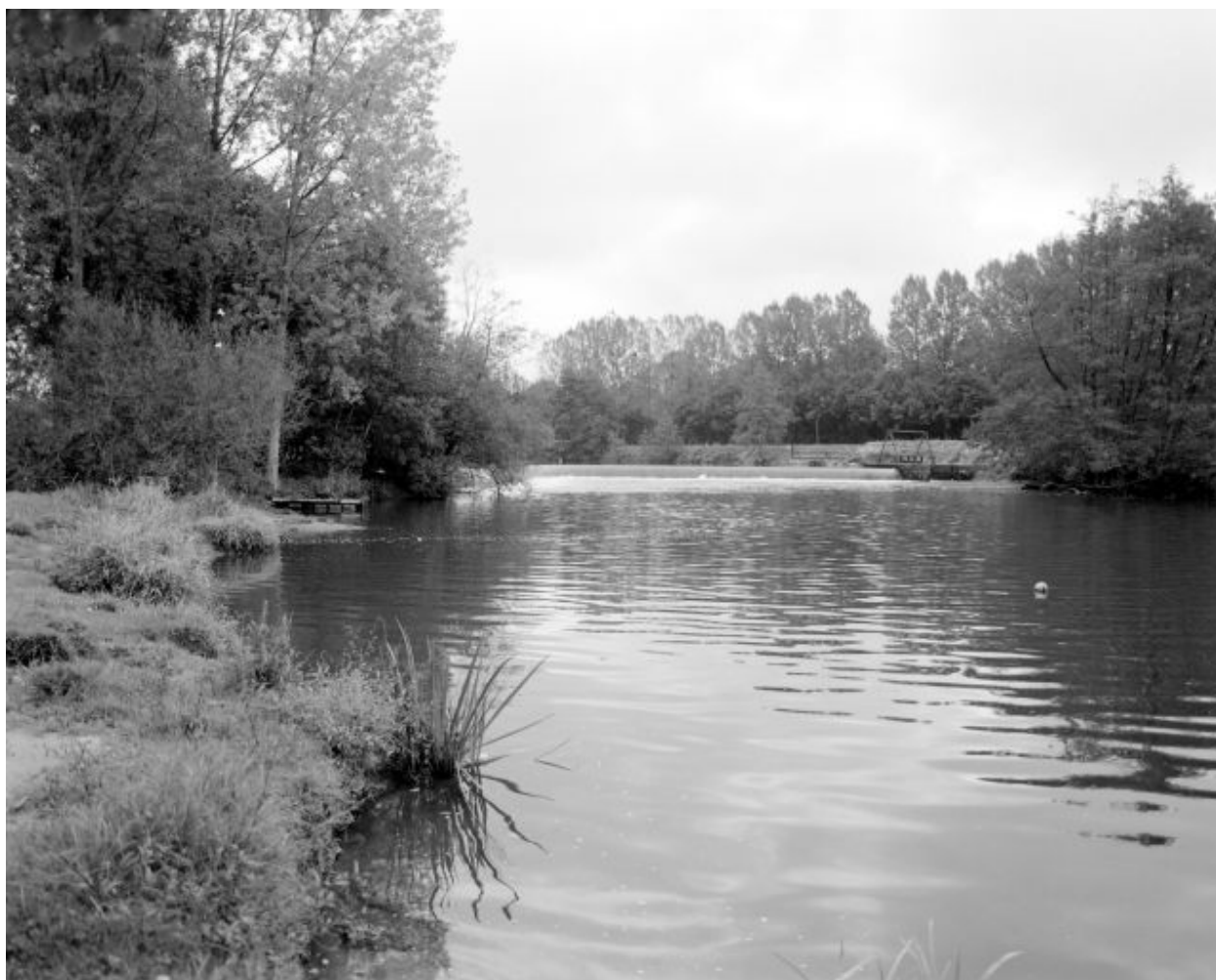
Le barrage et le pertuis des Communes vus de la rive droite de la Mayenne en aval.
