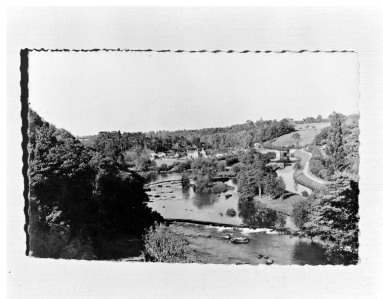
Vue aérienne de l'ensemble du site. Au premier plan, l'ancien barrage des Communes. Au second, l'ancien barrage de Morand. Au fond, le village et le pont de Montgiroux. A droite, le canal. Phot. François (reproduction) Lasa IVR52_20025300796XB
