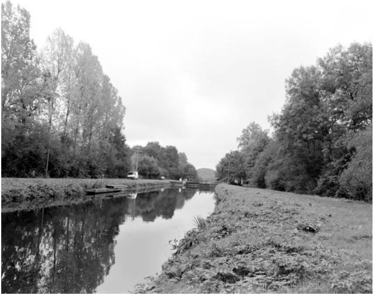
Le canal, l'écluse et la digue vus du nord.
