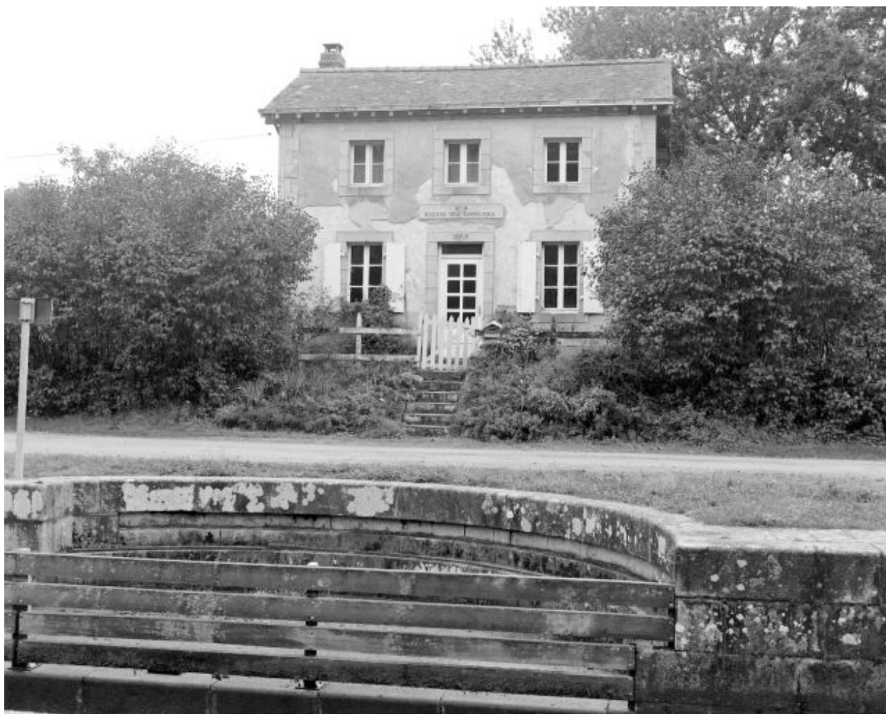
La maison éclusière et l'emplacement du pont-tournant.
