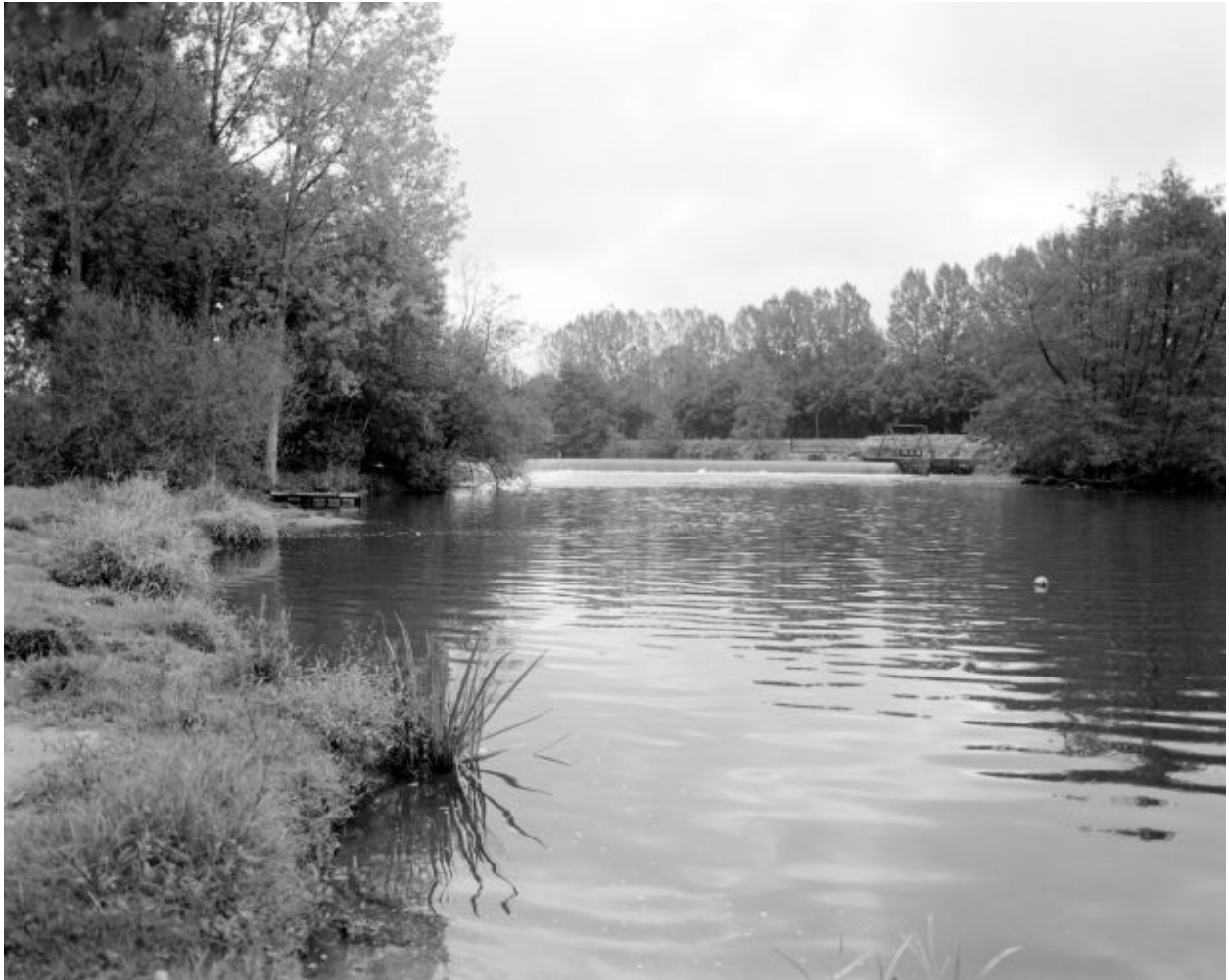
Le barrage et le pertuis des Communes vus de la rive droite de la Mayenne en aval.
