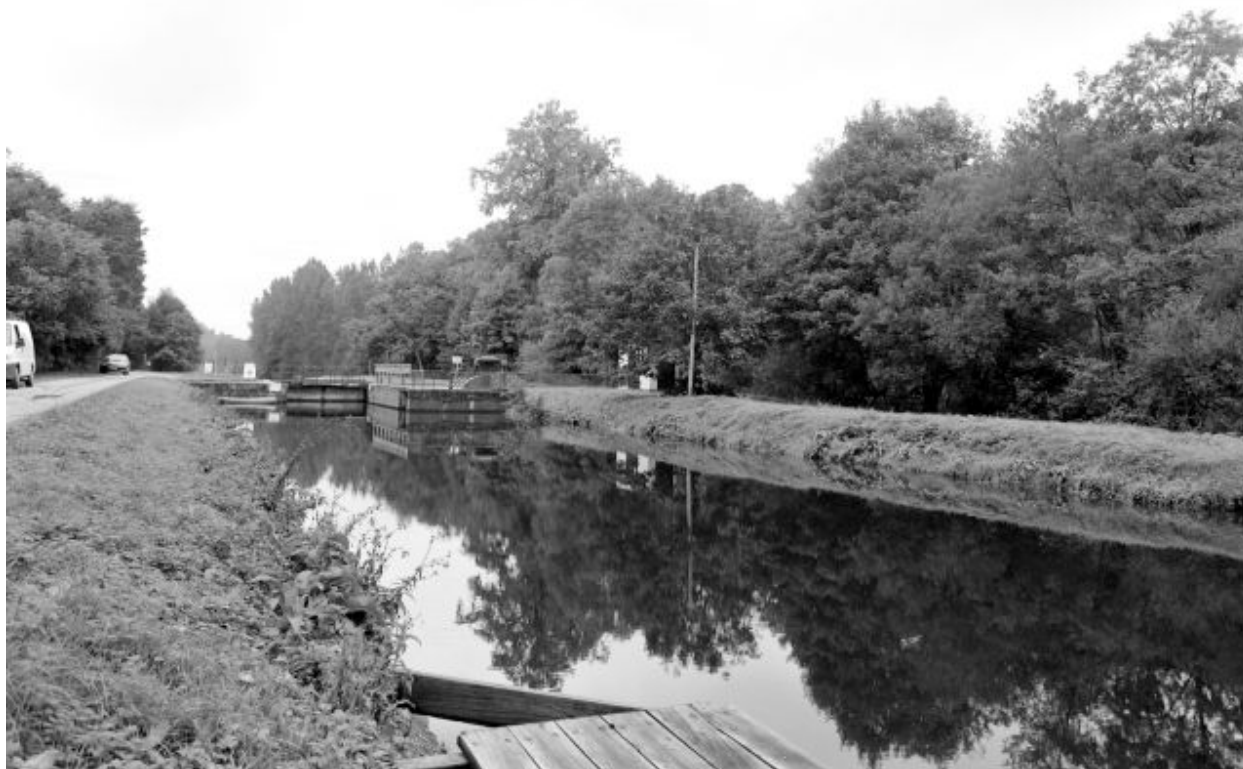
Le canal, l'écluse, la centrale hydroélectrique, le transformateur et la digue vus du nord.
