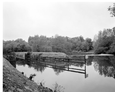
L'entrée d'amont du canal vu de la rive gauche. Phot. François Lasa IVR52_20015300547X
