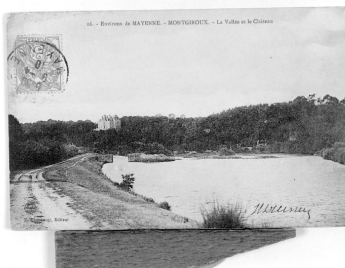
Vue d'ensemble du site depuis l'amont : chemin de halage, entrée du canal, digue, barrage. Au fond, le château de Montgiroux. Autr. E. Chouasnet, Repro. François Lasa IVR52_20015300387X
