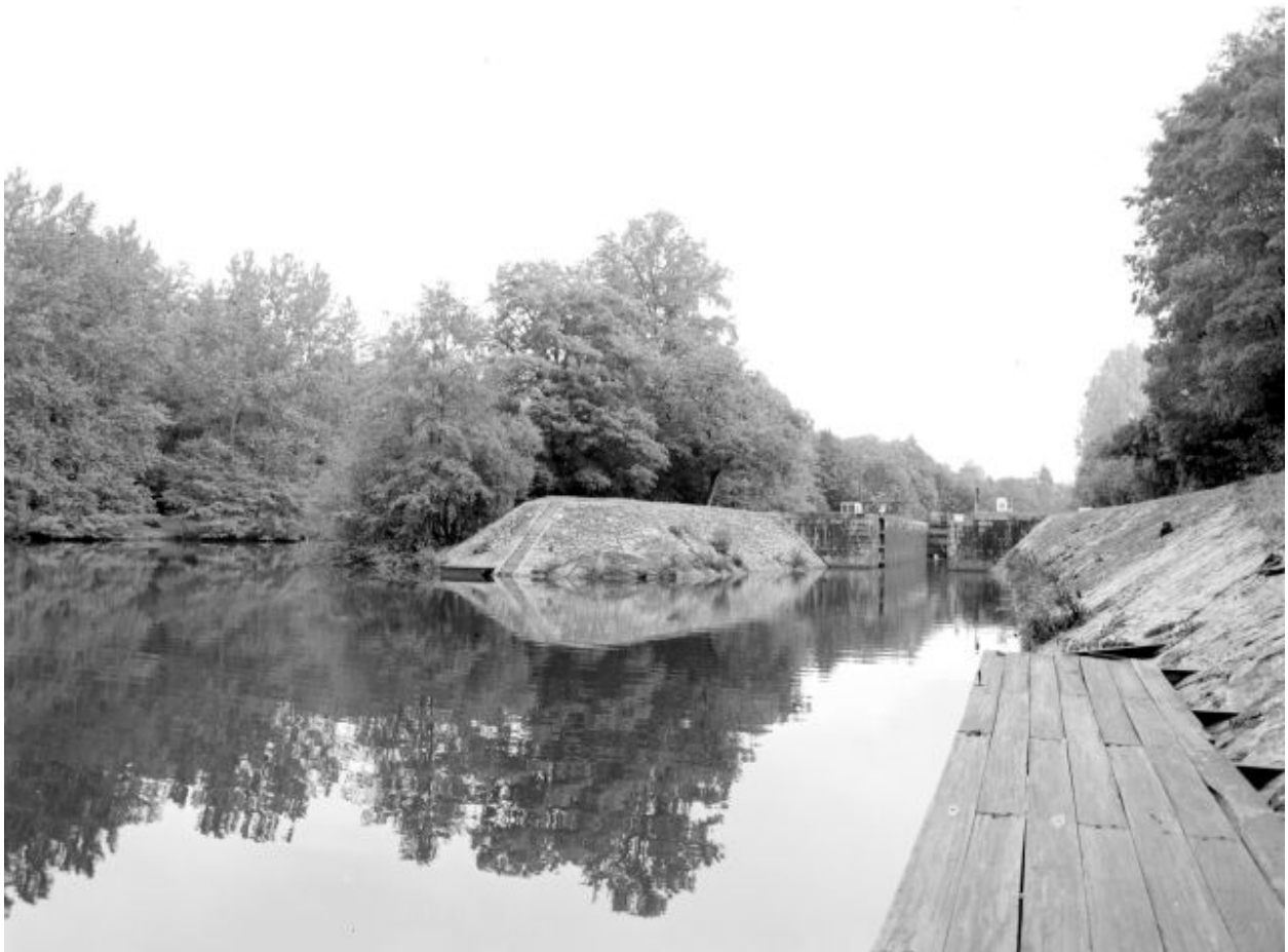
Vue d'ensemble du site à l'entrée d'aval du canal : rivière, digue, écluse.
