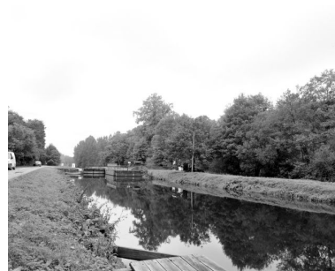
Le canal, l'écluse, la centrale hydroélectrique, le transformateur et la digue vus du nord. Phot. François Lasa IVR52_20015300546X
