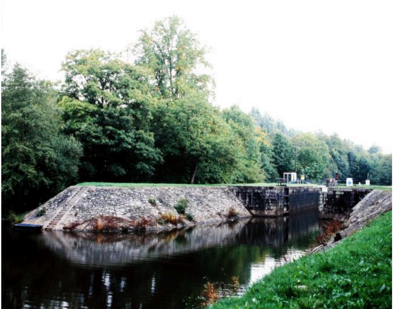
L'entrée d'aval du canal : la digue, l'écluse.
