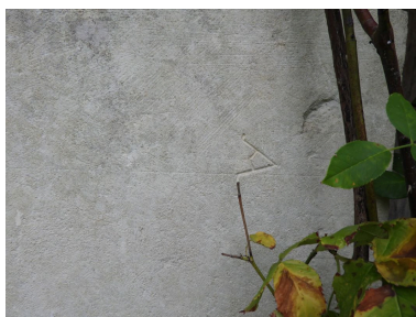
Marque de tailleur de pierre près de la porte de l'ancien logement. Phot. Yannis Suire IVR52_20198503319NUCA
