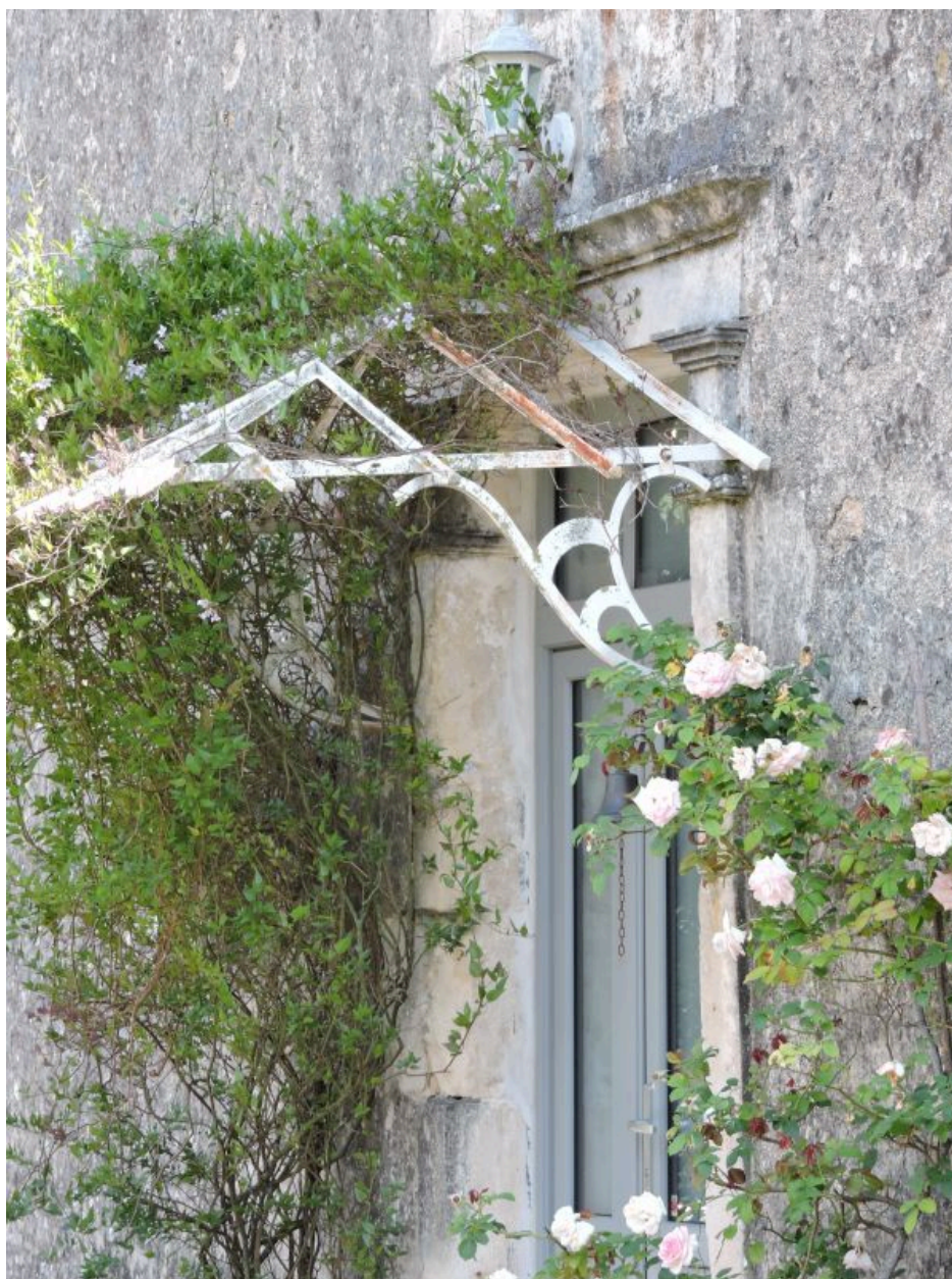
Détail de la porte : marquise, encadrement mouluré, corniche.
