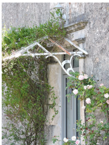
Détail de la porte : marquise, encadrement mouluré, corniche. Phot. Yannis Suire IVR52_20198503005NUCA
