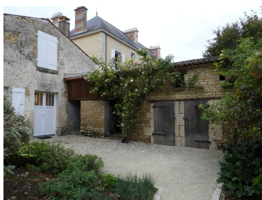
Dépendances à l'arrière du logis : Toits et latrines. Phot. Yannis Suire IVR52_20198503321NUCA
