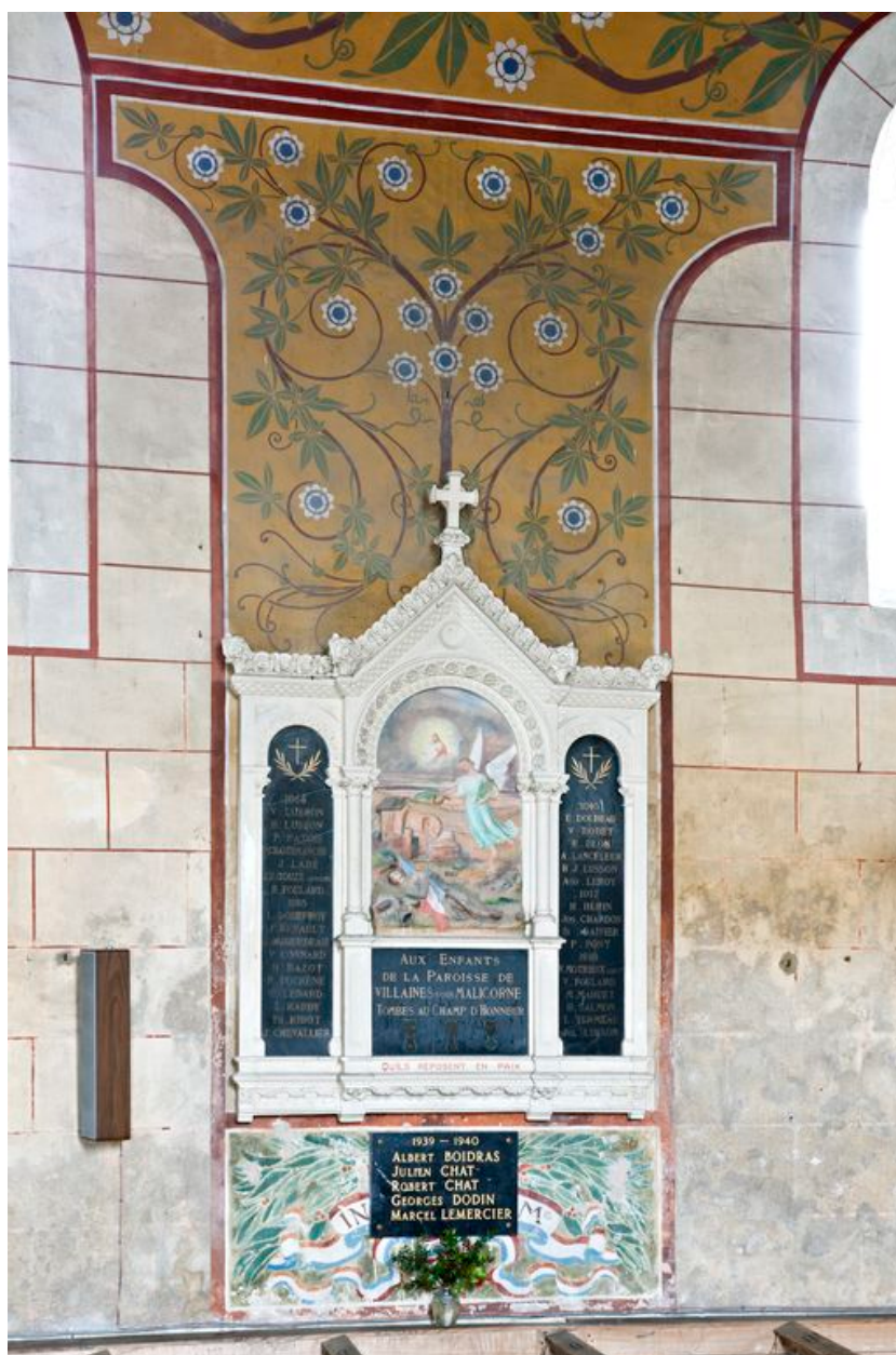
Nef, mur nord : vue d'ensemble du monument aux morts.
