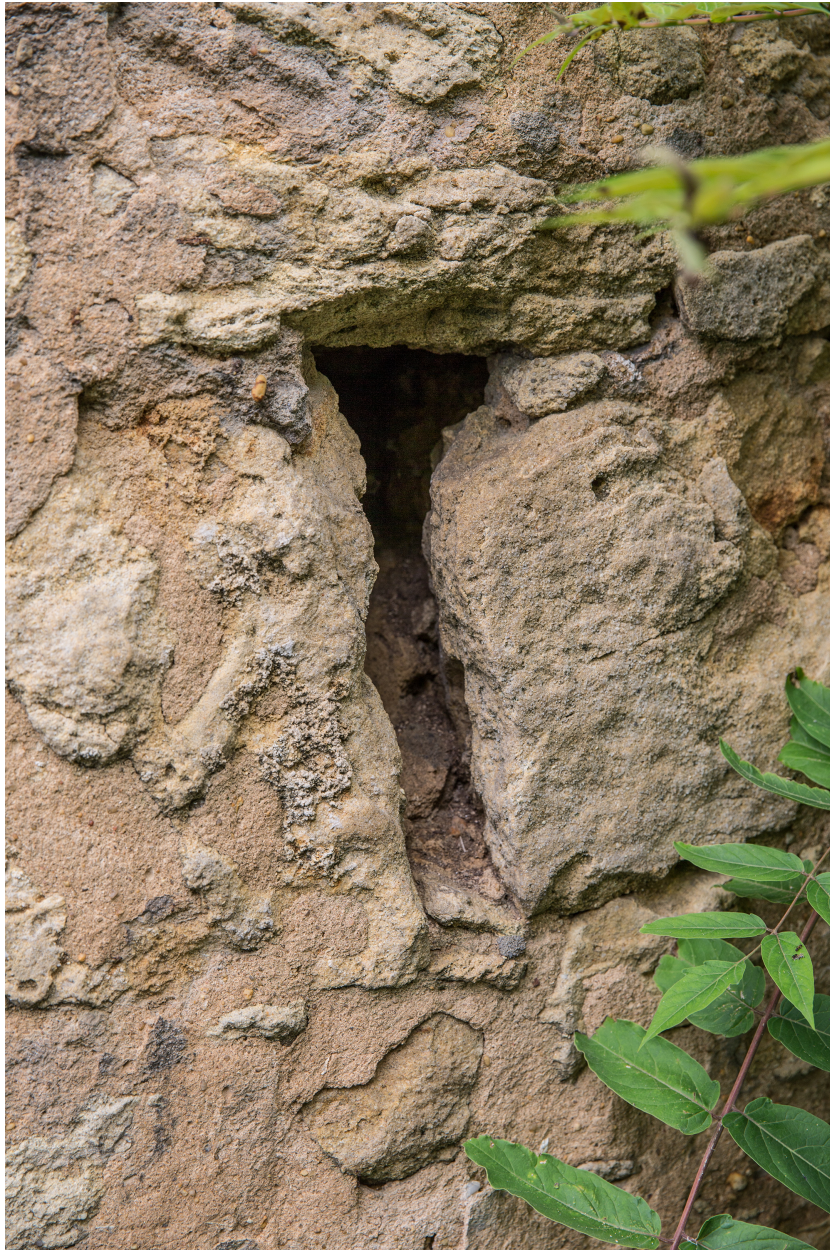
Une ouverture de la tour à l'arrière des rues des Vieux Ponts et Michel Beaufils (cour de l'école Sainte-Anne).
