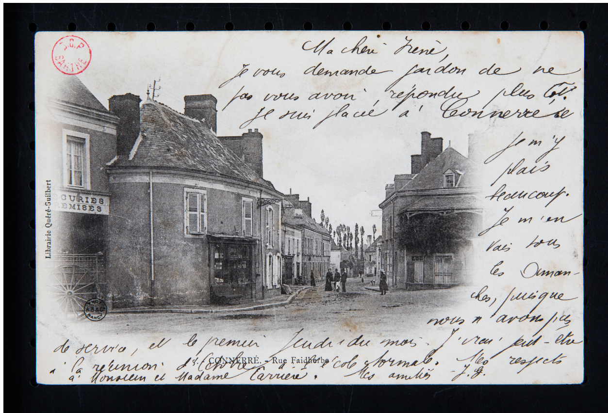
Une des tours de l'ancienne porte du Lion transformée en maison, avant démolition, carte postale, avant 1909.
