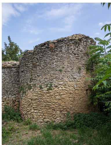
Une tour du rempart à l'arrière des rues des Vieux Ponts et Michel Beaufils (cour de l'école Sainte-Anne).
