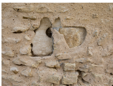
La tour de la Gaillarderie, détail d'une ancienne ouverture de tir. Phot. Pierre-Bernard Fourny IVR52_20187201219NUCA
