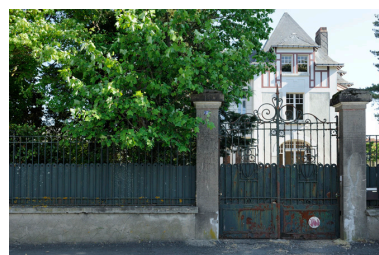
Maison de Louis Pasquier vue depuis la rue Pasteur. Phot. Bruno Rousseau, Phot. Youenn Communeau IVR52_20114901488NUCA
