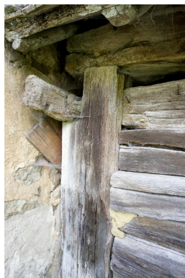
Remise, mur en bois : détail de l'élévation externe à l'angle postérieur gauche. Phot. François Lasa IVR52_20077200780NUCA
