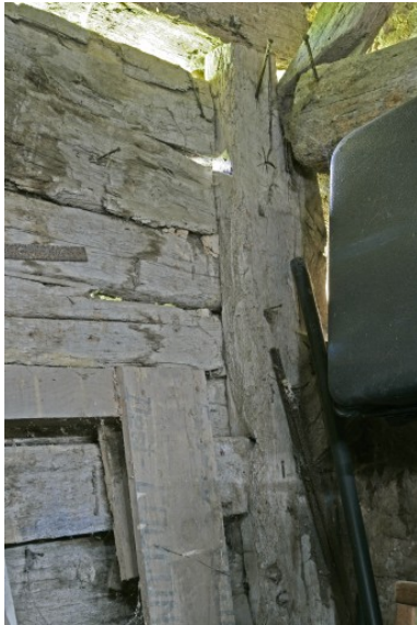
Remise, mur en bois : détail de l'élévation interne à l'angle postérieur gauche. Phot. François Lasa IVR52_20077200782NUCA
