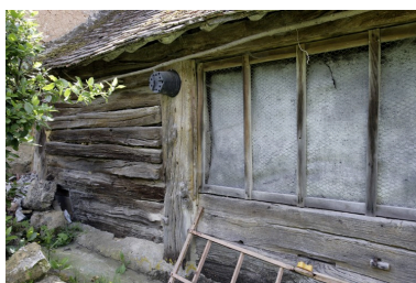
Remise, élévation postérieure : mur en bois. Phot. François Lasa IVR52_20077200779NUCA
