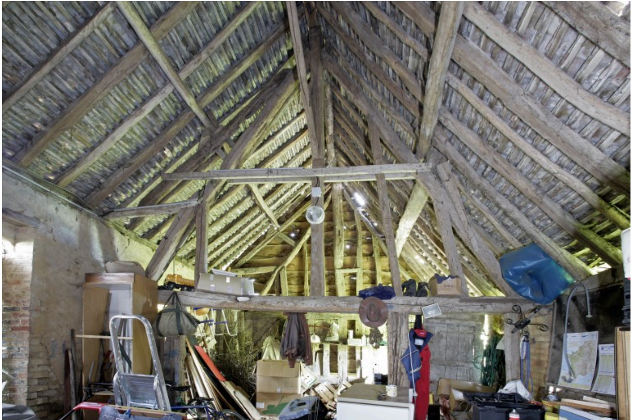
Remise, intérieur : vue générale.
