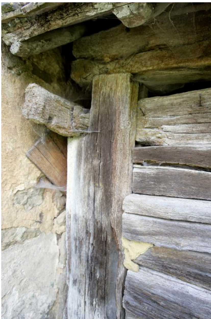
Remise, mur en bois : détail de l'élévation externe à l'angle postérieur gauche.
