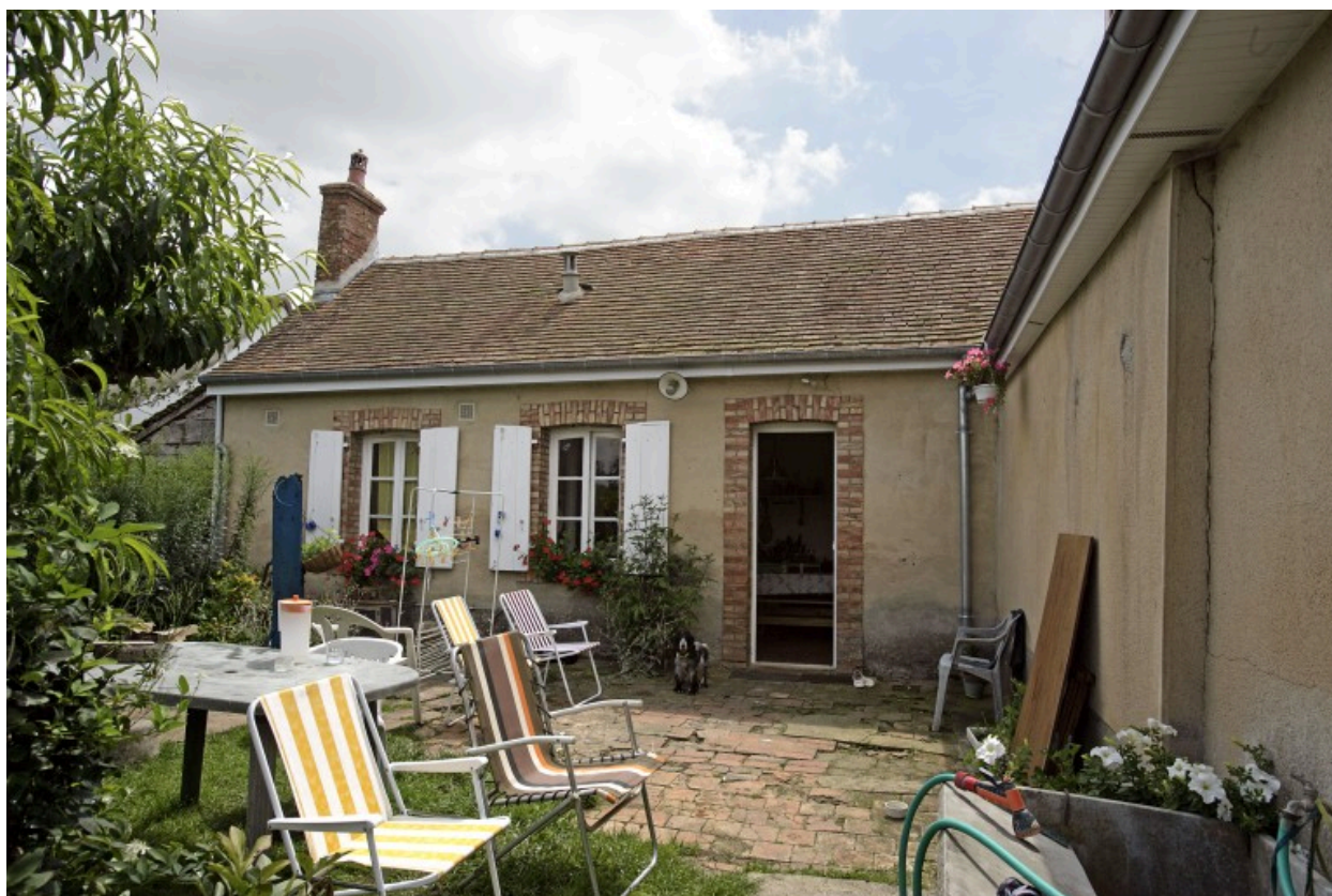
Logis : aile en retour à usage de logis, construite en 1924, vue depuis le jardin.
