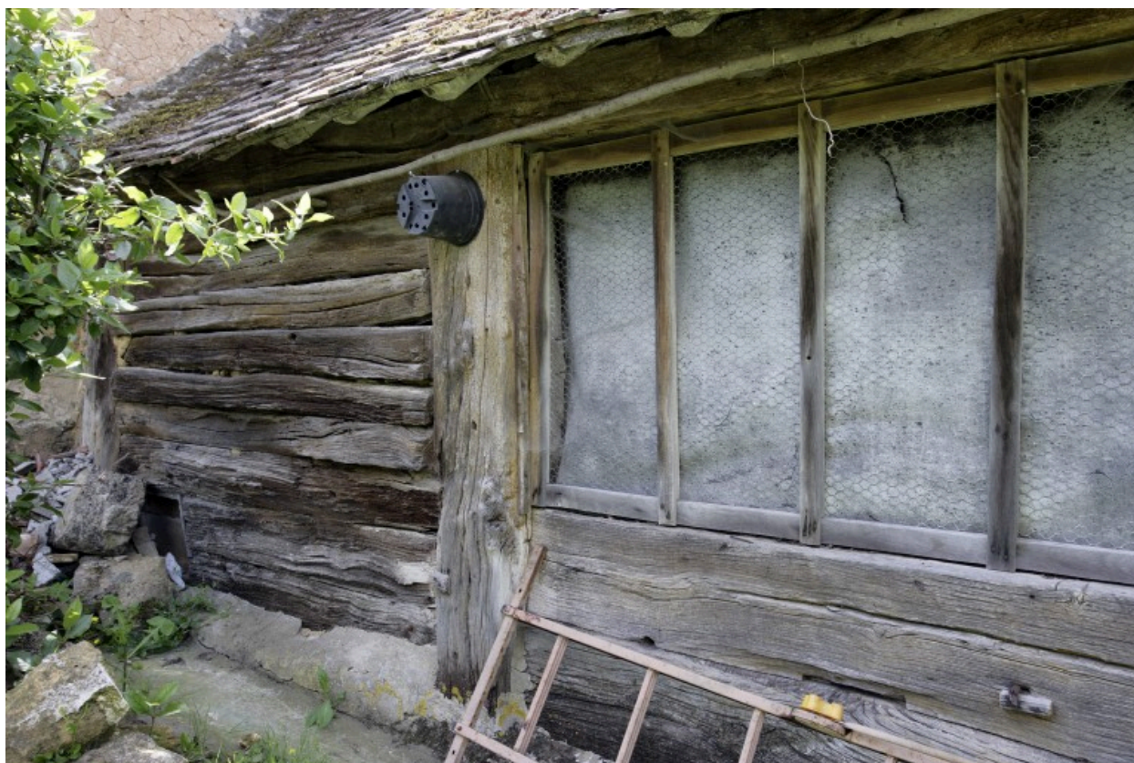
Remise, élévation postérieure : mur en bois.
