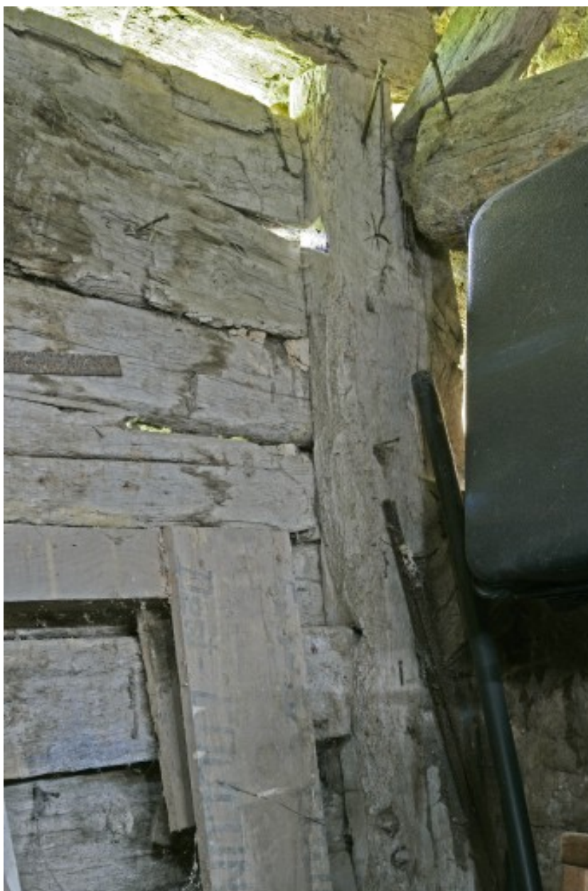
Remise, mur en bois : détail de l'élévation interne à l'angle postérieur gauche.
