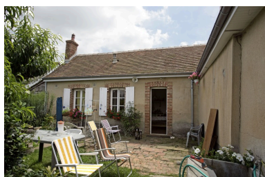
Logis : aile en retour à usage de logis, construite en 1924, vue depuis le jardin. Phot. François Lasa IVR52_20077200783NUCA
