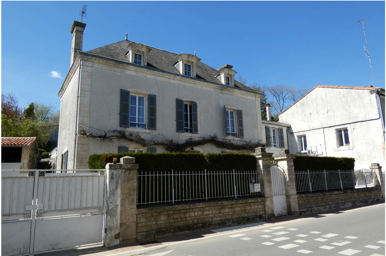
La maison vue depuis le sud-est.
