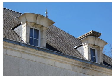
Deux des lucarnes avec leur fronton. Phot. Yannis Suire IVR52_20238501266NUCA
