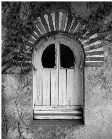
Baie d'une dépendance. Phot. Denis Pillet IVR52_19974401039X
