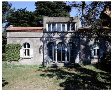
Elévation antérieure. Phot. Denis Pillet IVR52_19974400999XA
