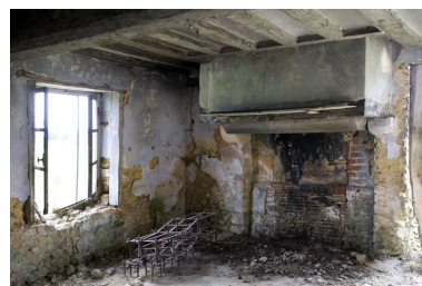
Vue intérieure de la chambre à feu. Phot. François Lasa IVR52_20087201405NUCA
