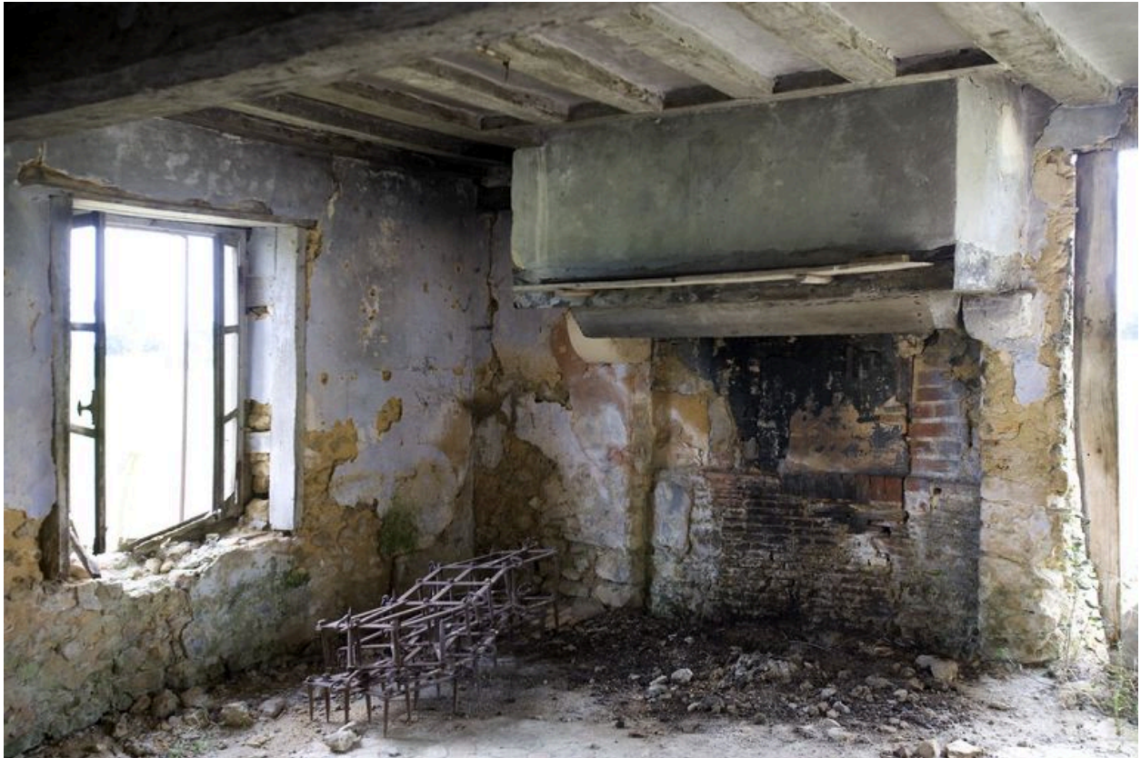
Vue intérieure de la chambre à feu.
