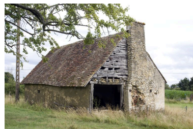
Vue générale depuis le nord-ouest Phot. François Lasa IVR52_20087201402NUCA
