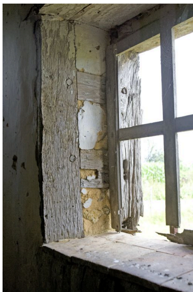
Détail de la baie de la chambre froide. Phot. François Lasa IVR52_20087201407NUCA
