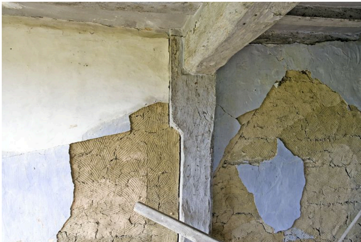
Intérieur, détail du pan-de-bois de l'élévation postérieure.
