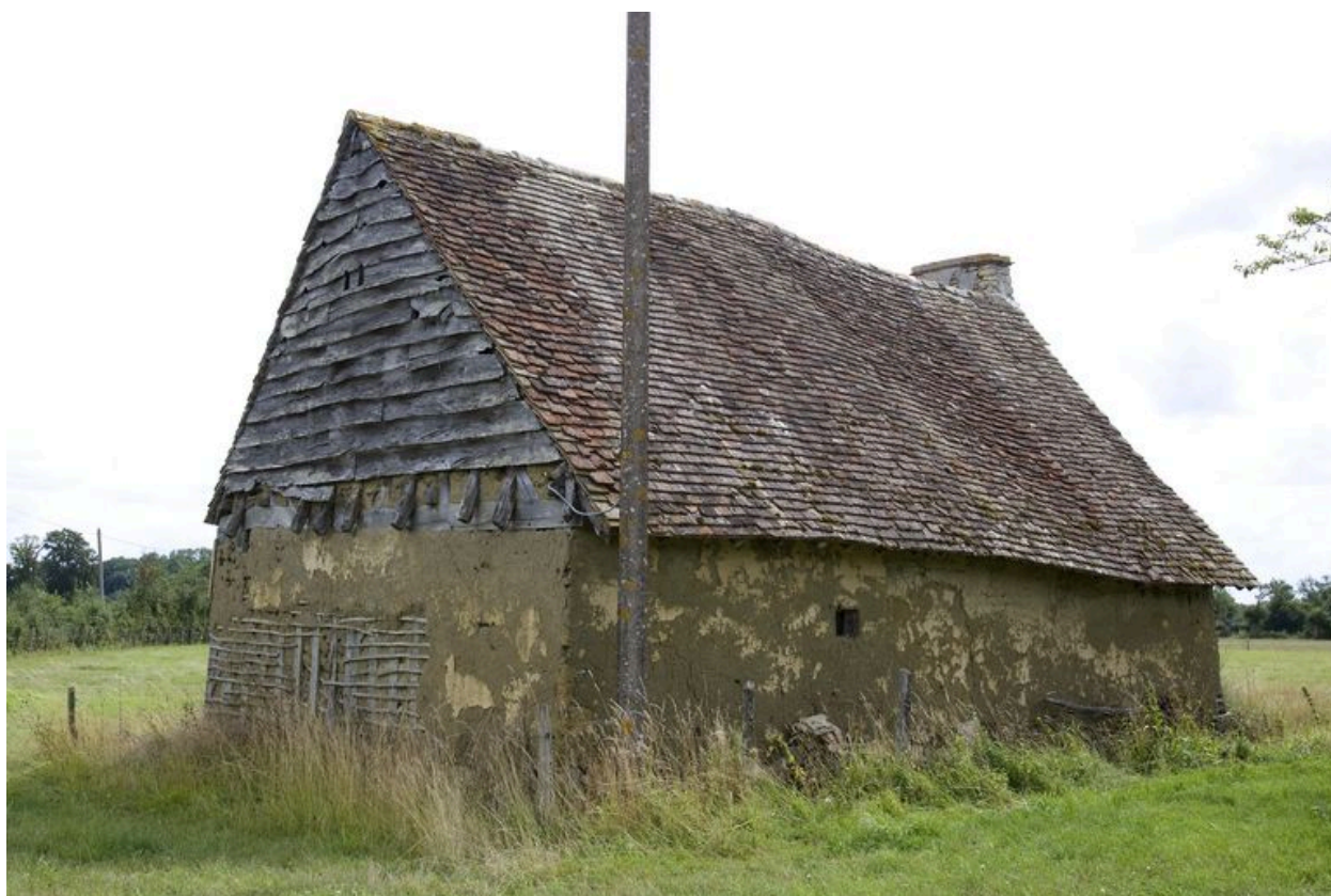
Logis, élévation postérieure.
