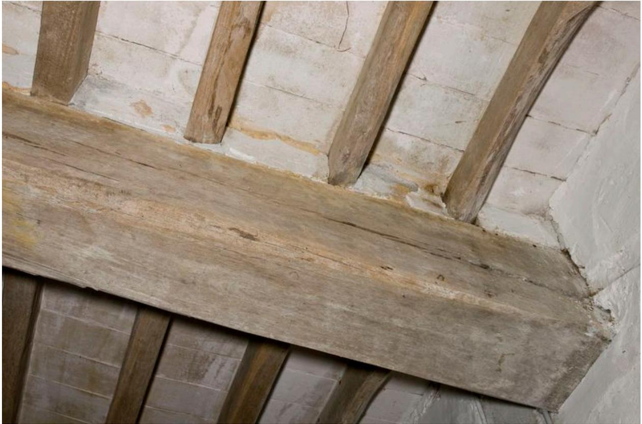
Poutre du plafond des étables, portant la date 1860. Le hourdis de briques creuses est le "plancher de briques creuses d'une forme nouvelle" remarqué en 1864 par la commission du Comice agricole.
