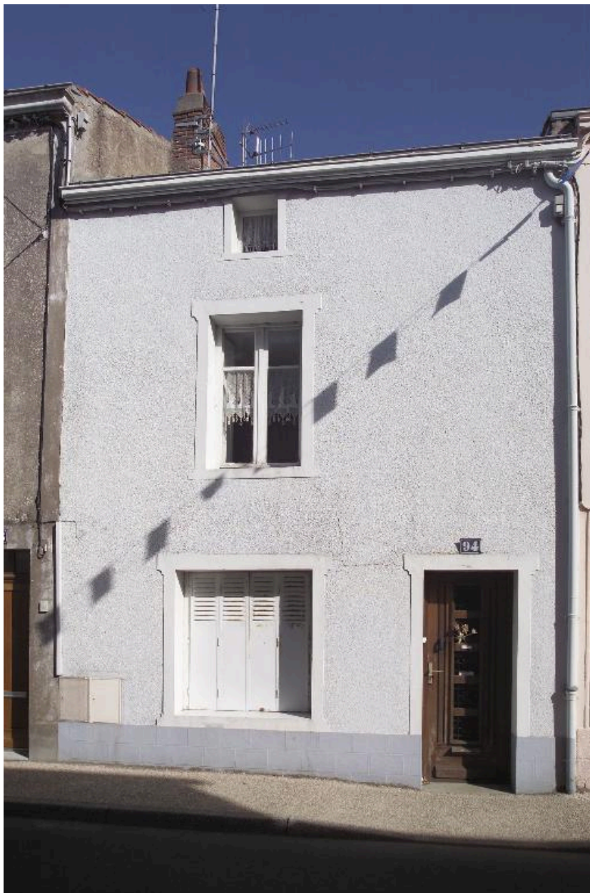
La façade antérieure de la maison 94 rue du Général-De-Gaulle.
