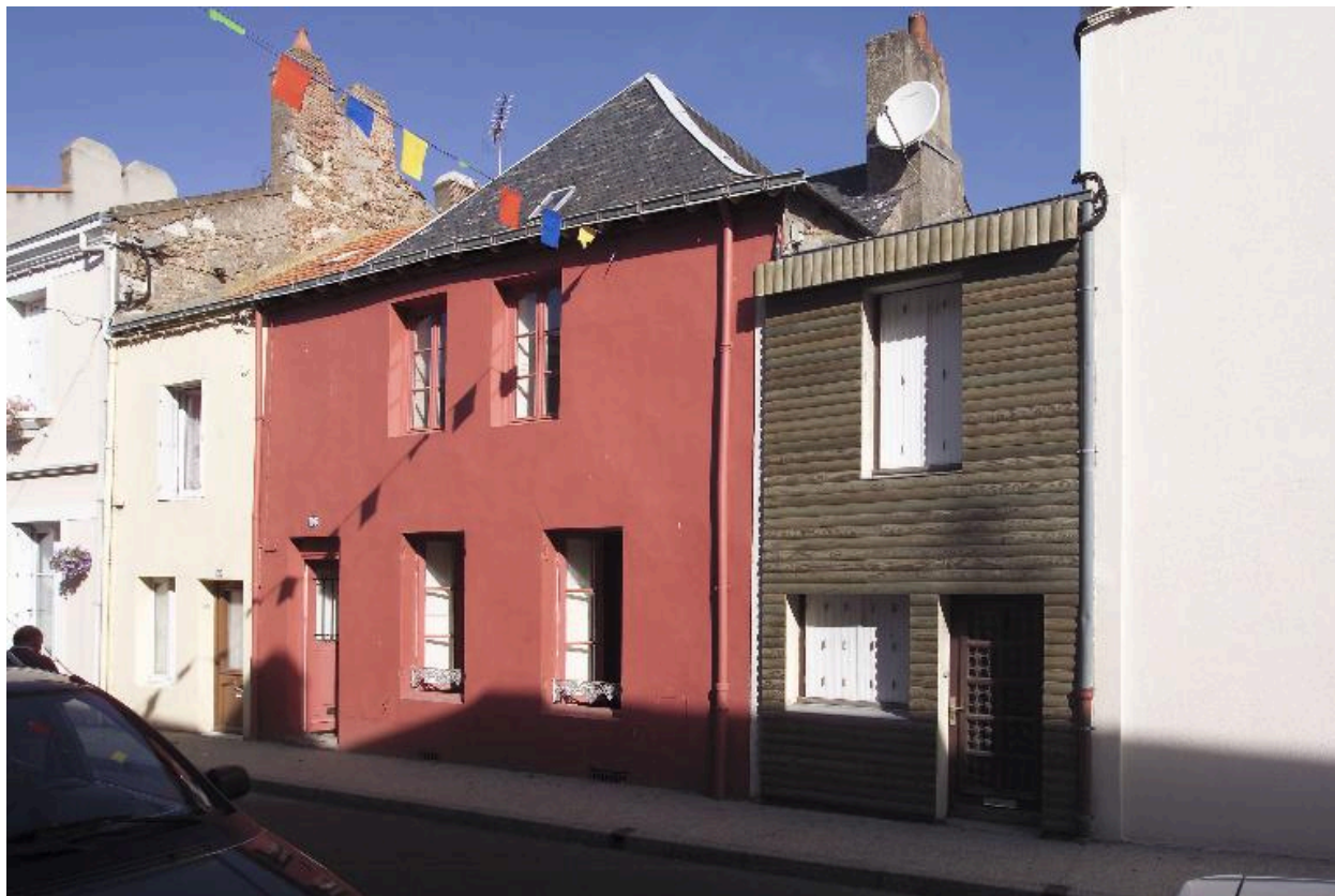
La façade antérieure de la maison n° 106 à 110 rue du Général-De-Gaulle.
