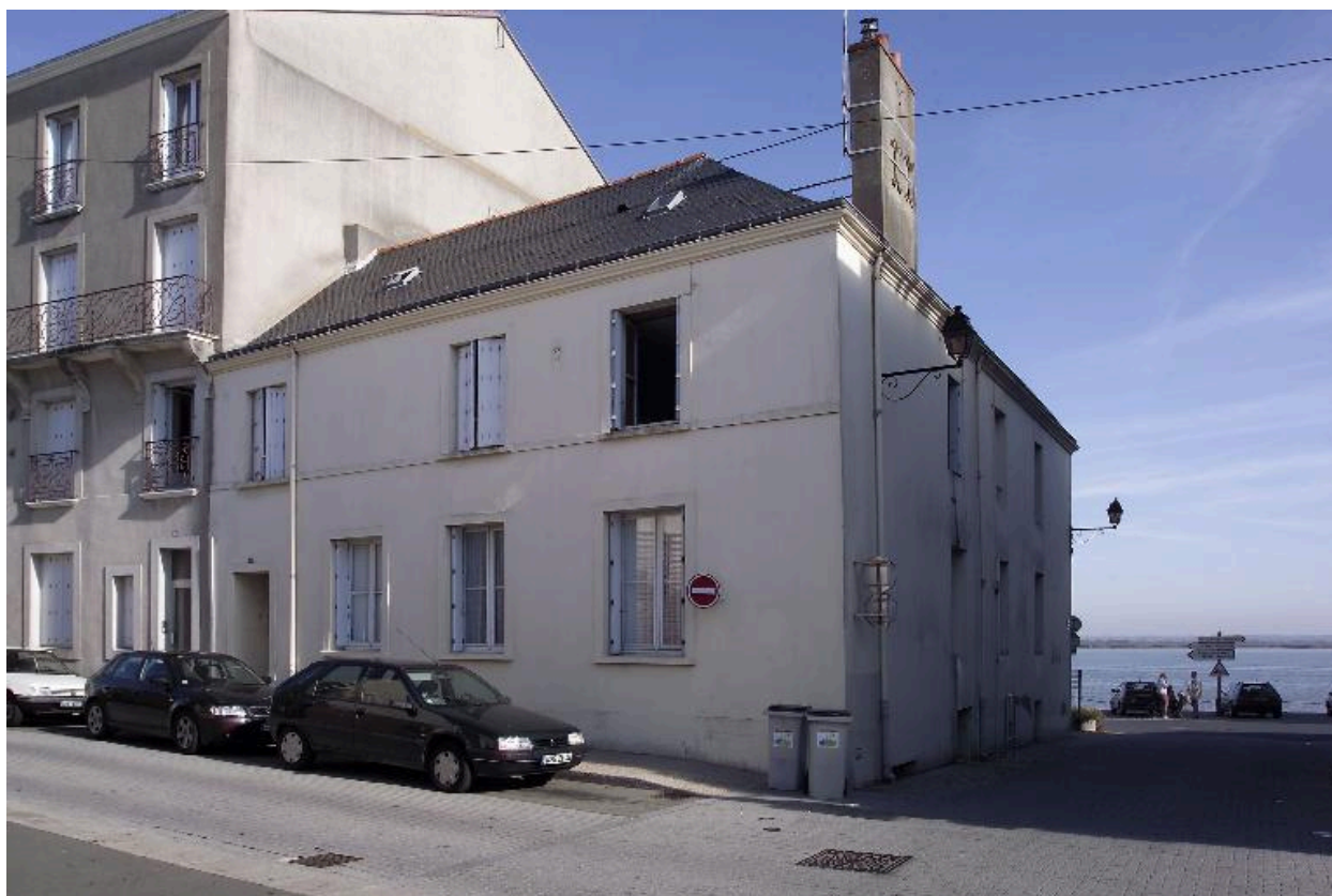
Vue de la façade n° 58 rue du Général-De-Gaulle.
