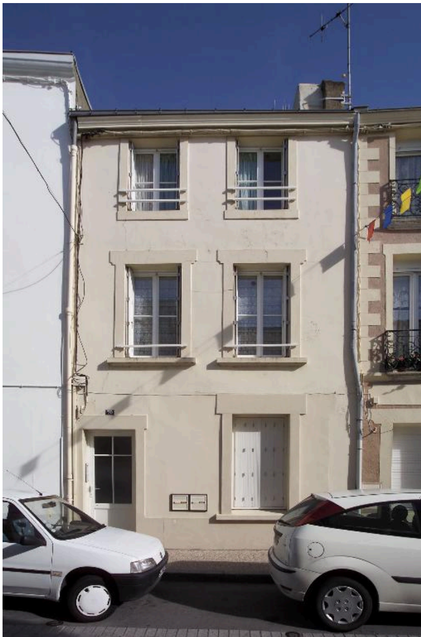
Vue de la façade n° 70 rue du Général-De-Gaulle.
