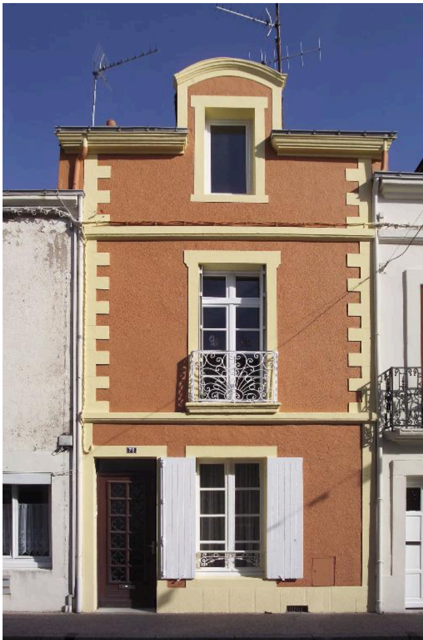
Vue de la façade n° 78 rue du Général-De-Gaulle.
