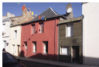
La façade antérieure de la maison n° 106 à 110 rue du Général-De-Gaulle. Phot. Denis Pillet IVR52_20034401013NUCA
