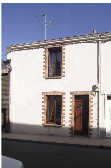
La façade antérieure de la maison n ° 104 bis rue du Général-De-Gaulle. Phot. Denis Pillet IVR52_20034401012NUCA
