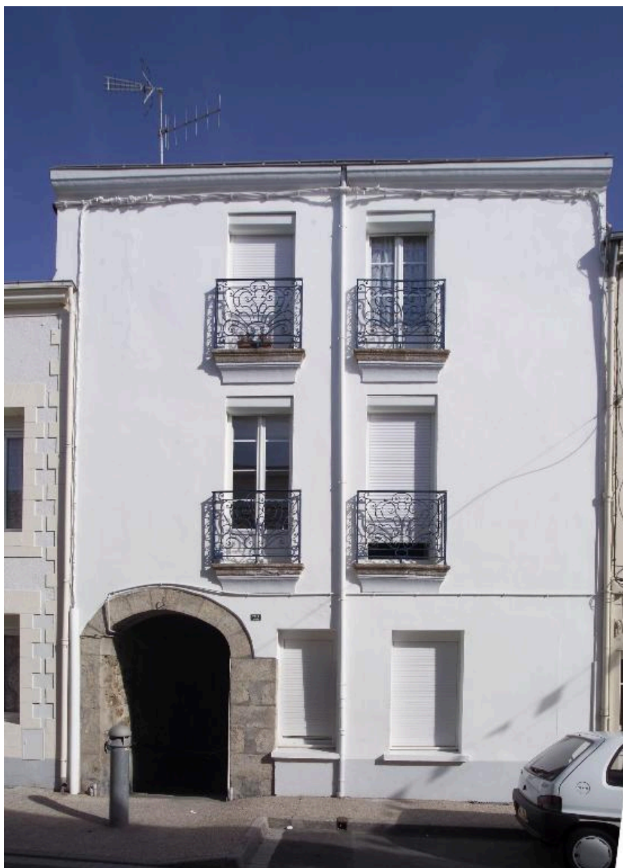
Vue de la façade n° 72 rue du Général-De-Gaulle.
