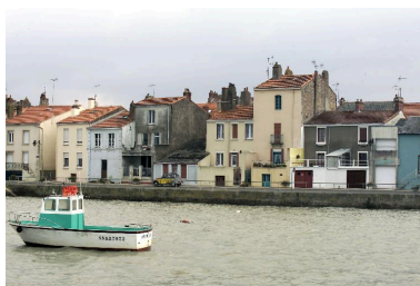
Vue du quai depuis le passage Neptune. Phot. Denis Pillet IVR52_20034401936NUCA
