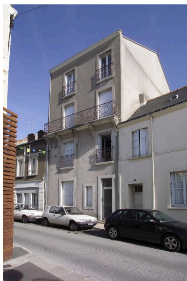
Vue des façades n° 58, 60, 62 rue du Général-De-Gaulle. Phot. Denis Pillet IVR52_20034400988NUCA
