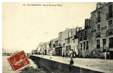
Le quai Boulay-Paty au début du XXe siècle, vue prise vers l'amont. Autr. Vassellier, Phot. Denis (reproduction) Pillet IVR52_20034401748NUCA
