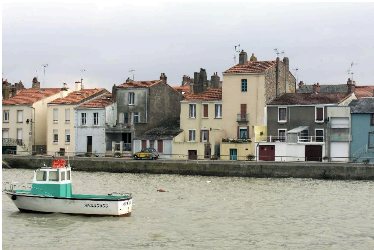
Vue du quai depuis le passage Neptune.
