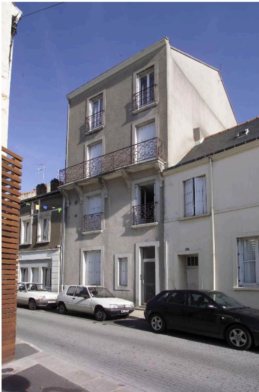
Vue des façades n° 58, 60, 62 rue du Général-De-Gaulle.
