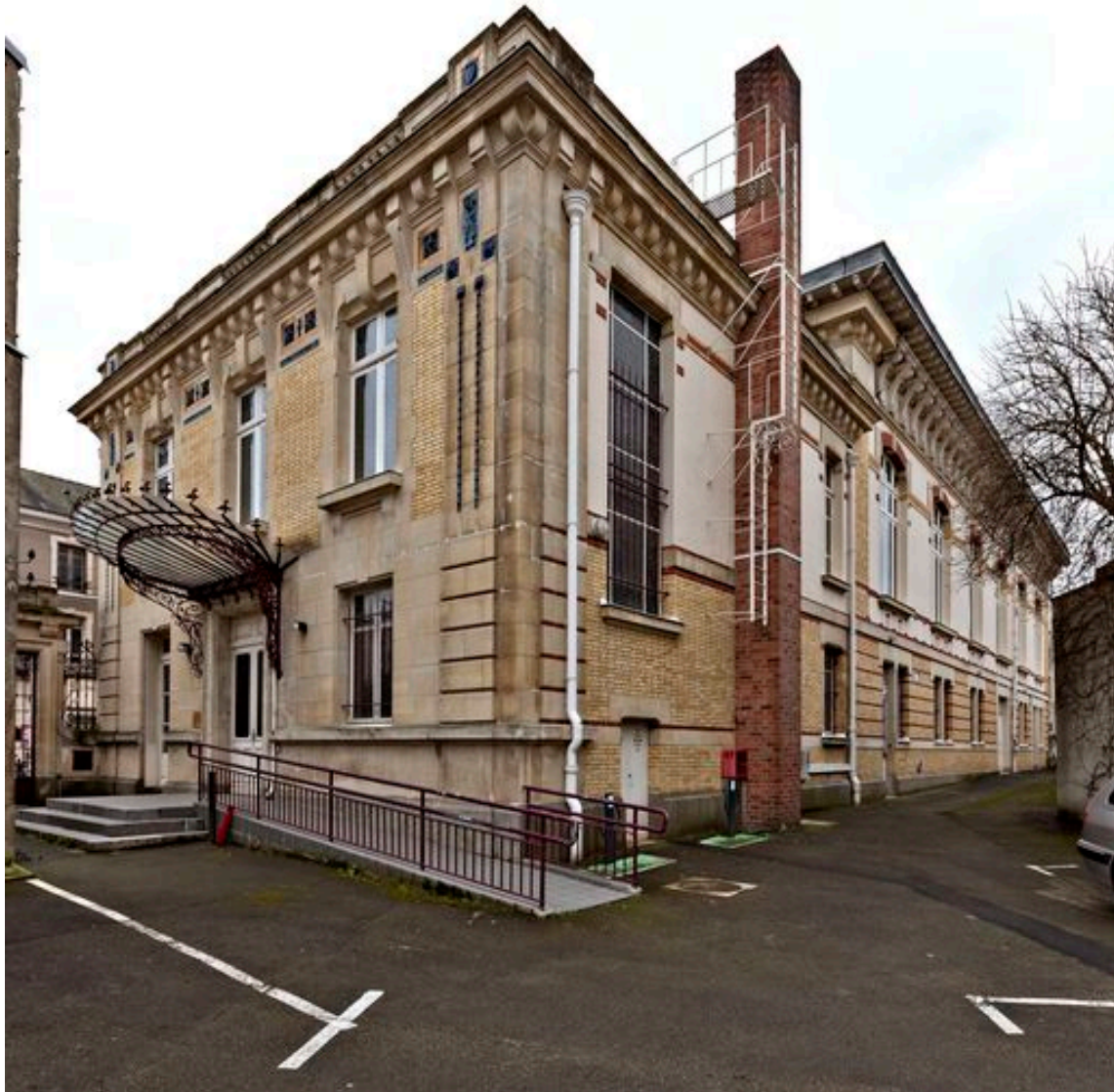
Vue d'ensemble depuis la cour, à l'est.
