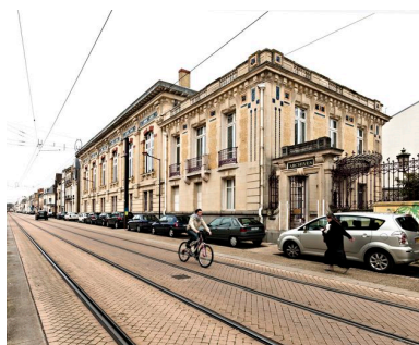
Vue d'ensemble de l'ancien siège social de la société Chappée et fils depuis la rue au sud. Phot. Yves Guillotin IVR52_20147202282NUCA
