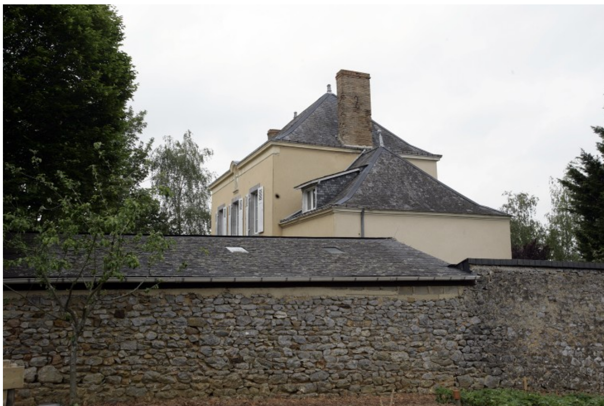
Vue depuis le chemin du lavoir.
