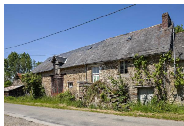
Hameau des Hauts-Buats, alignement nord, partie ouest (2023 ZI 29). Phot. Yves Guillotin IVR52_20215300709NUCA
