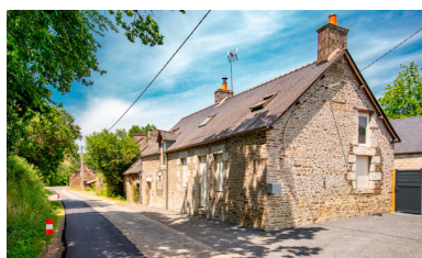
Hameau des Hauts-Buats, alignement nord, vu depuis l'est (2023 ZI 28). Phot. Pierre-Bernard Fourny IVR52_20235300855NUCA
