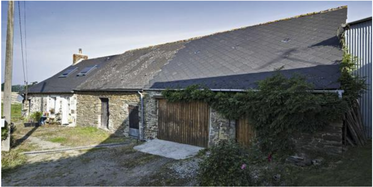
Hameau de la Roterie, maison, étables et garage en alignement (2023 ZC 24, 27, 25).
