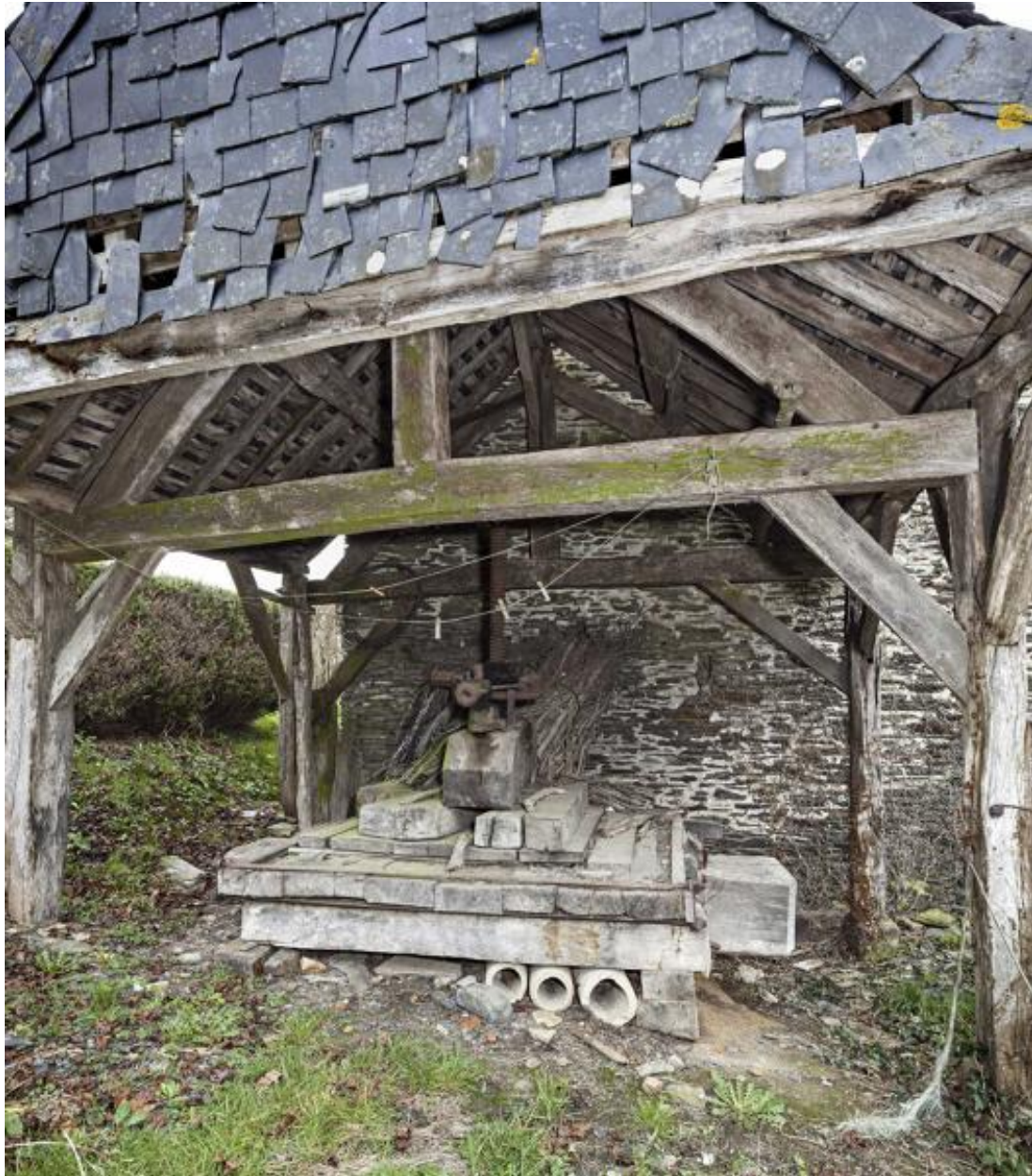
Pressoir à cidre, sous une loge en bois, écart de Montoger.
