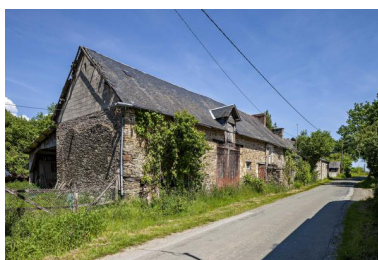
Hameau des Hauts-Buats, alignement nord, vu depuis l'ouest (2023 ZI 29). Phot. Yves Guillotin IVR52_20215300707NUCA
