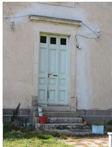
La porte. Phot. Yannis Suire IVR52_20188500571NUCA
