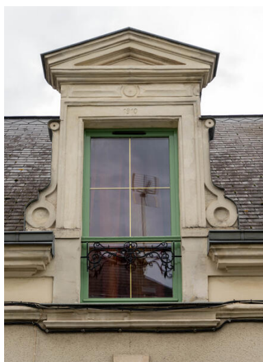
Vue d'une lucarne portant date impasse du Préau. Phot. Pierre-Bernard Fourny IVR52_20227200966NUCA
