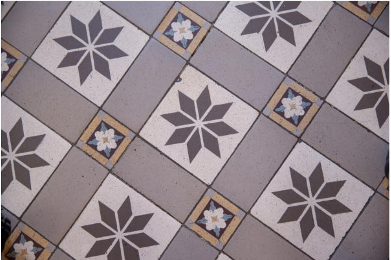
Vue de carreaux de ciment dans le vestibule d'entrée dans une maison rue Gambetta.
