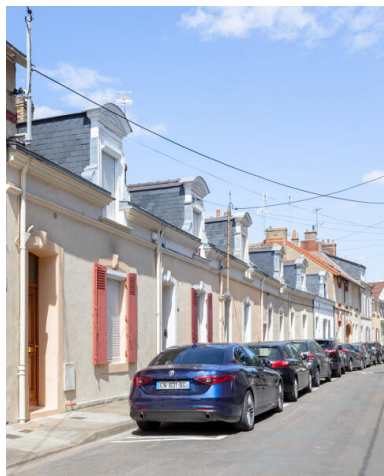
Vue d'alignement de mancelles rue de Valmy. Phot. Paul Hamelin IVR52_20227200494NUCA
