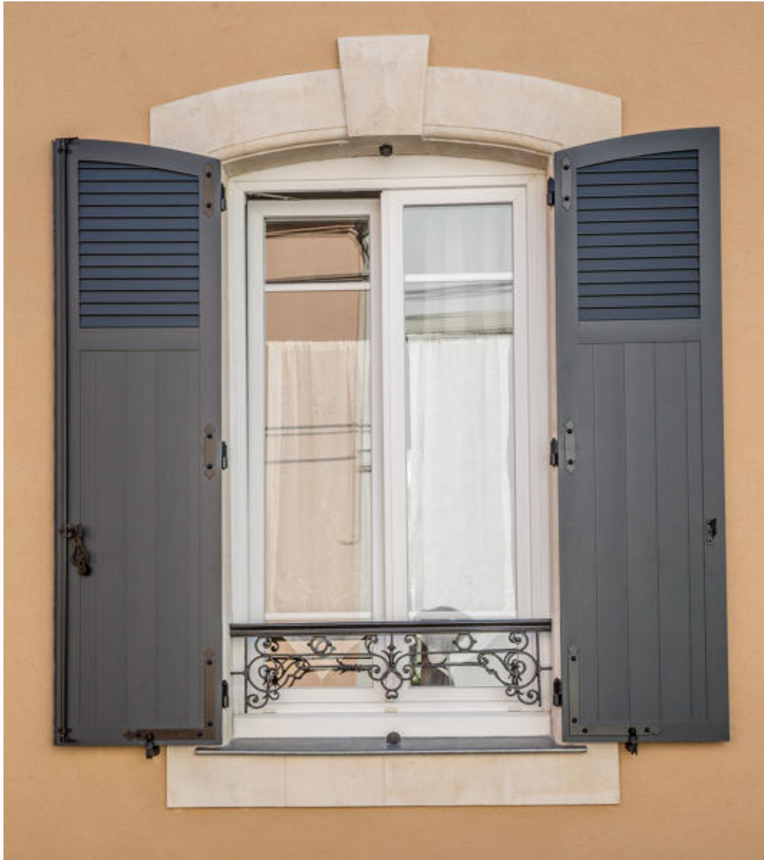
Vue d'une fenêtre en rez-de-chaussée d'une mancelle rue Jean-Jacques-Rousseau.
