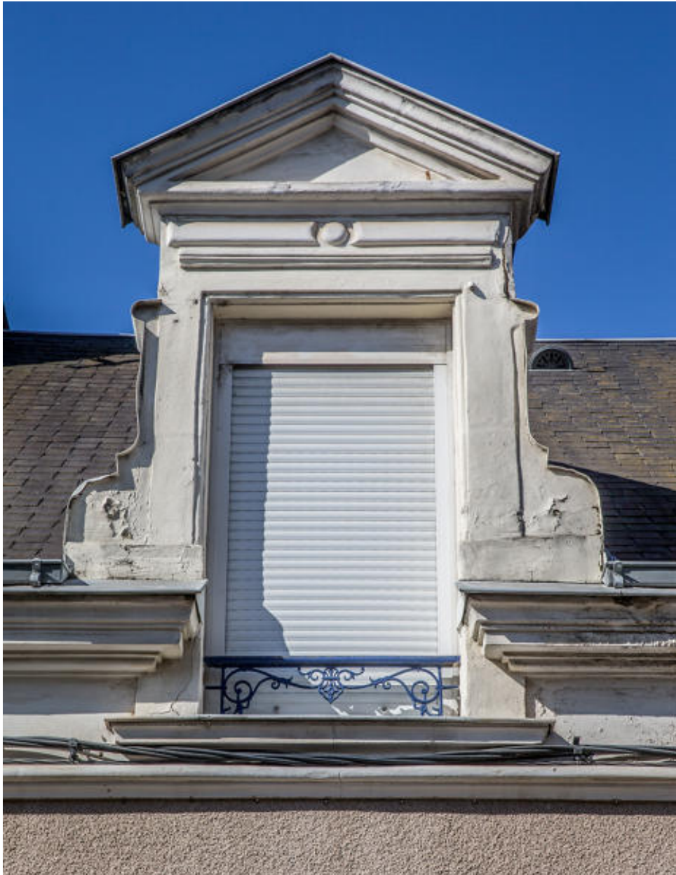
Vue d'une lucarne de pierre avenue Olivier-Heuzé.
