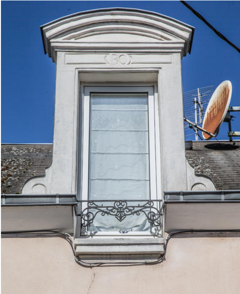
Vue d'une lucarne en pierre rue du pavé.
