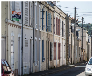
Vue d'un alignement de grande mancelle rue du 4 septembre. Phot. Pierre-Bernard Fourny IVR52_20187200985NUCA
