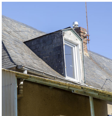
Vue d'une lucarne à jouées de bois rue des Aloes. Phot. Pierre-Bernard Fourny IVR52_20197202188NUCA
