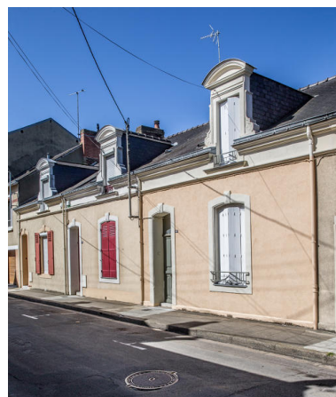
Vue d'un alignement de mancelles rue Hoche. Phot. Pierre-Bernard Fourny IVR52_20187200931NUCA
