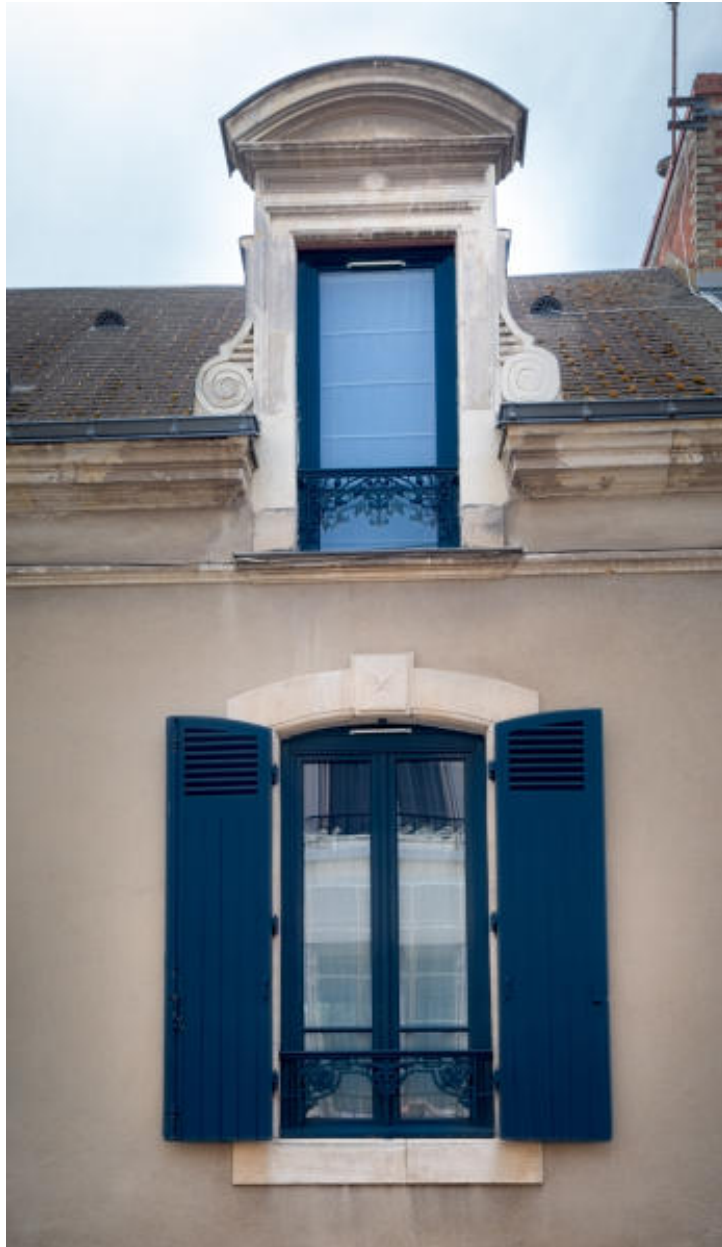
Vue d'une travée latérale d'une mancelle rue Hoche.
