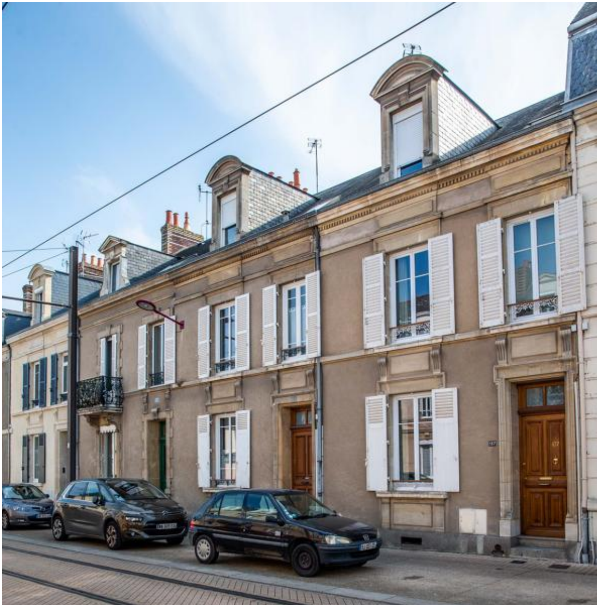
Vue d'un alignement de grandes mancelles rue Gambetta.
