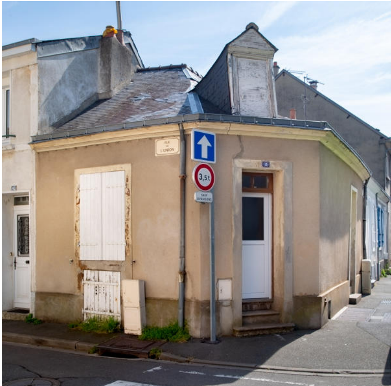
Vue d'une mancelle années 1810-1820 rue de l'Union.
