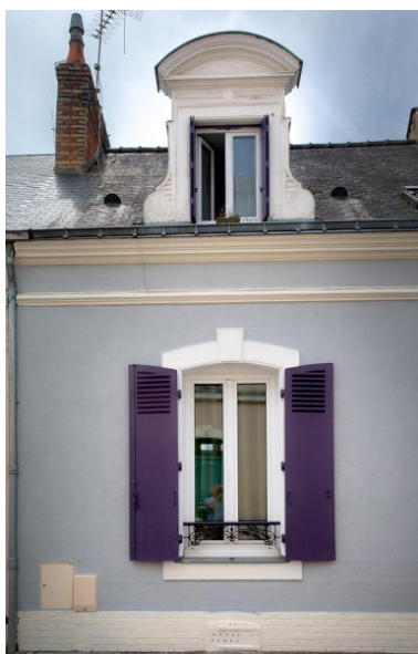
Vue d'une travée latérale d'une mancelle rue Ambroise-Paré. Phot. Pierre-Bernard Fourny IVR52_20197201350NUCA
