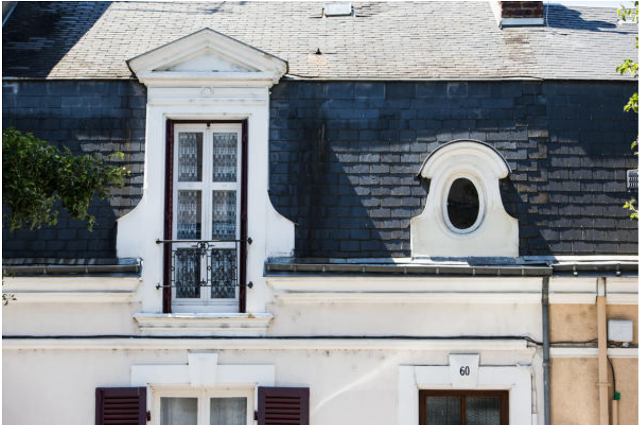
Vue d'une lucarne et d'un oeil de boeuf rue du Colonel-Raynal.
