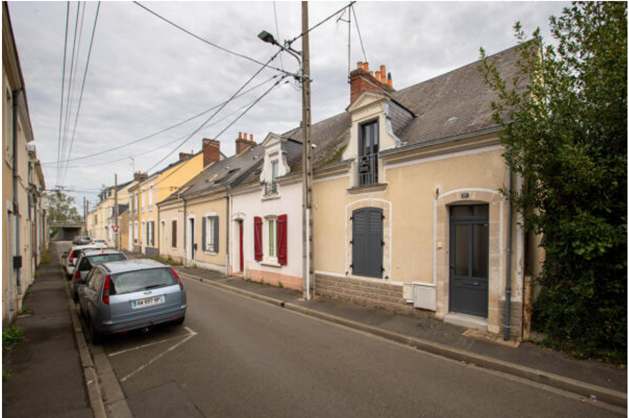
Vue d'un alignement de mancelles rue du Ponceau.
