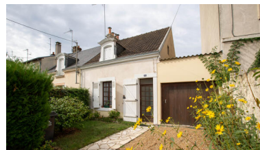
Vue d'une mancelle en retrait rue Briffault. Phot. Pierre-Bernard Fourny IVR52_20227200974NUCA
