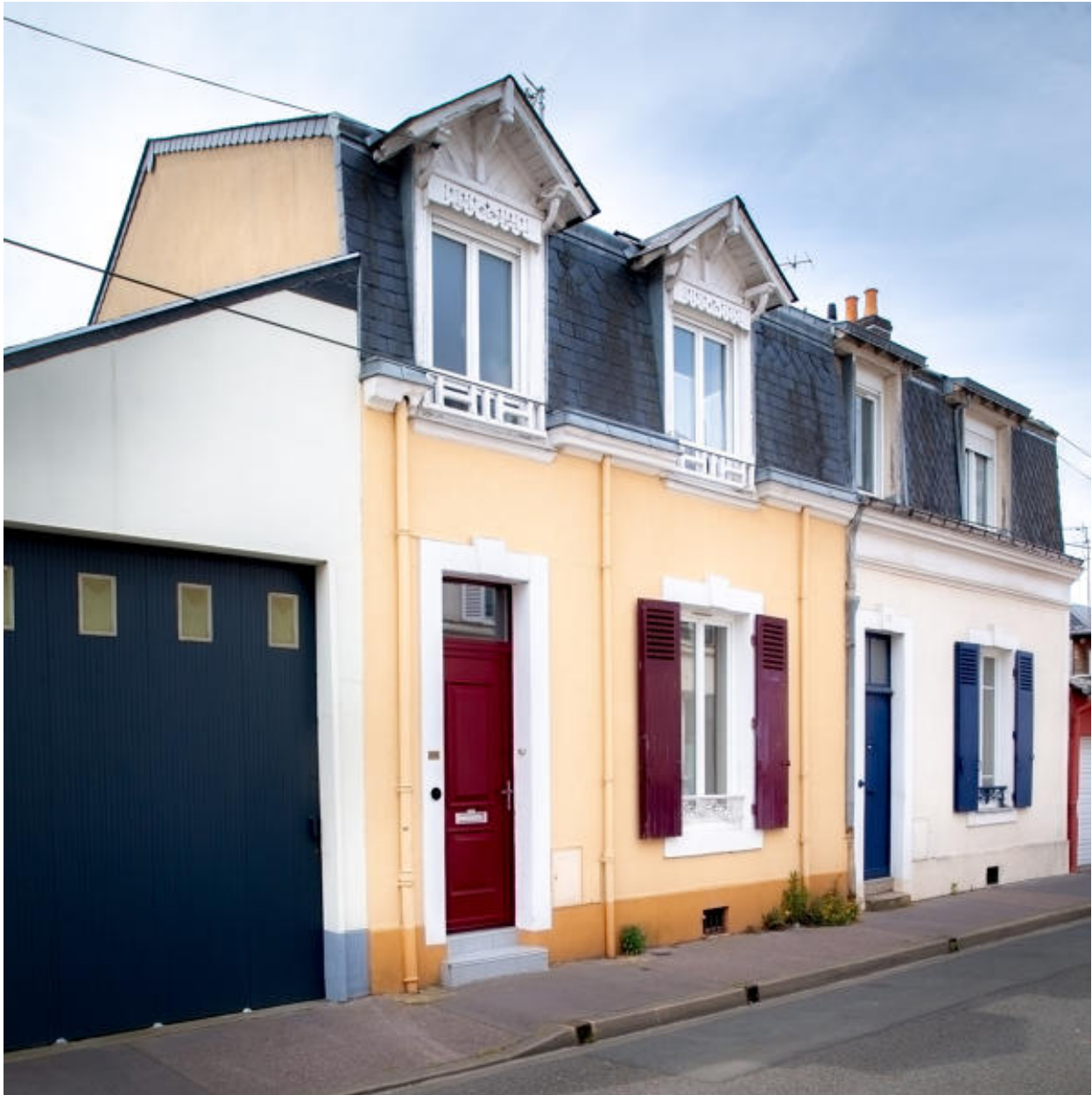
Vue de deux mancelles avec bris de toiture réhaussés rue Fleury.
