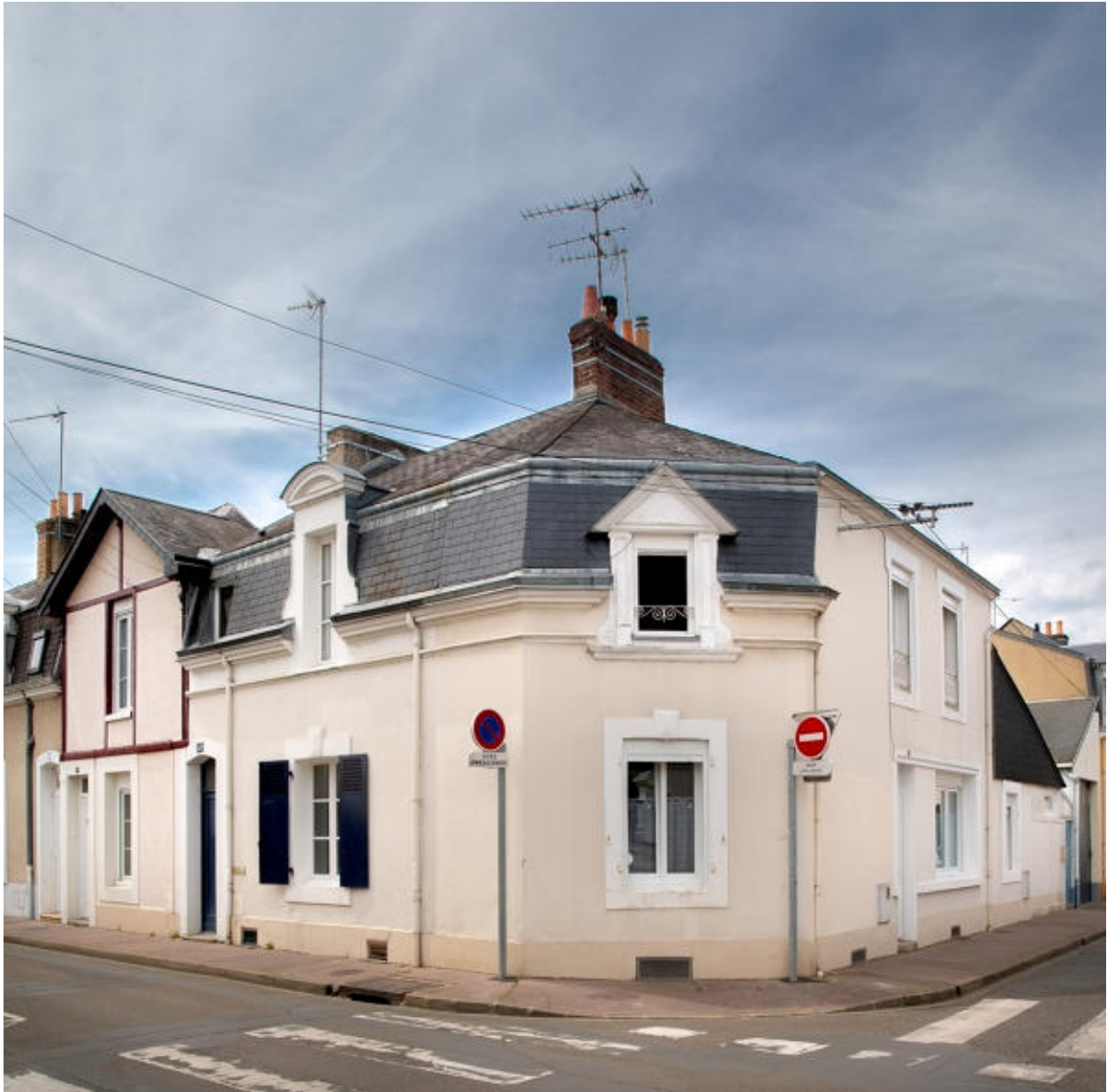
Vue d'une mancelle en angle avec lucarne de bois et lucarne de pierre rue Kléber.
