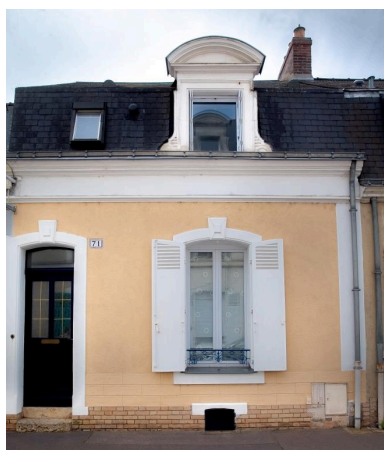
Vue d'une maison dite mancelle rue Hoche. Phot. Pierre-Bernard Fourny IVR52_20197201351NUCA
