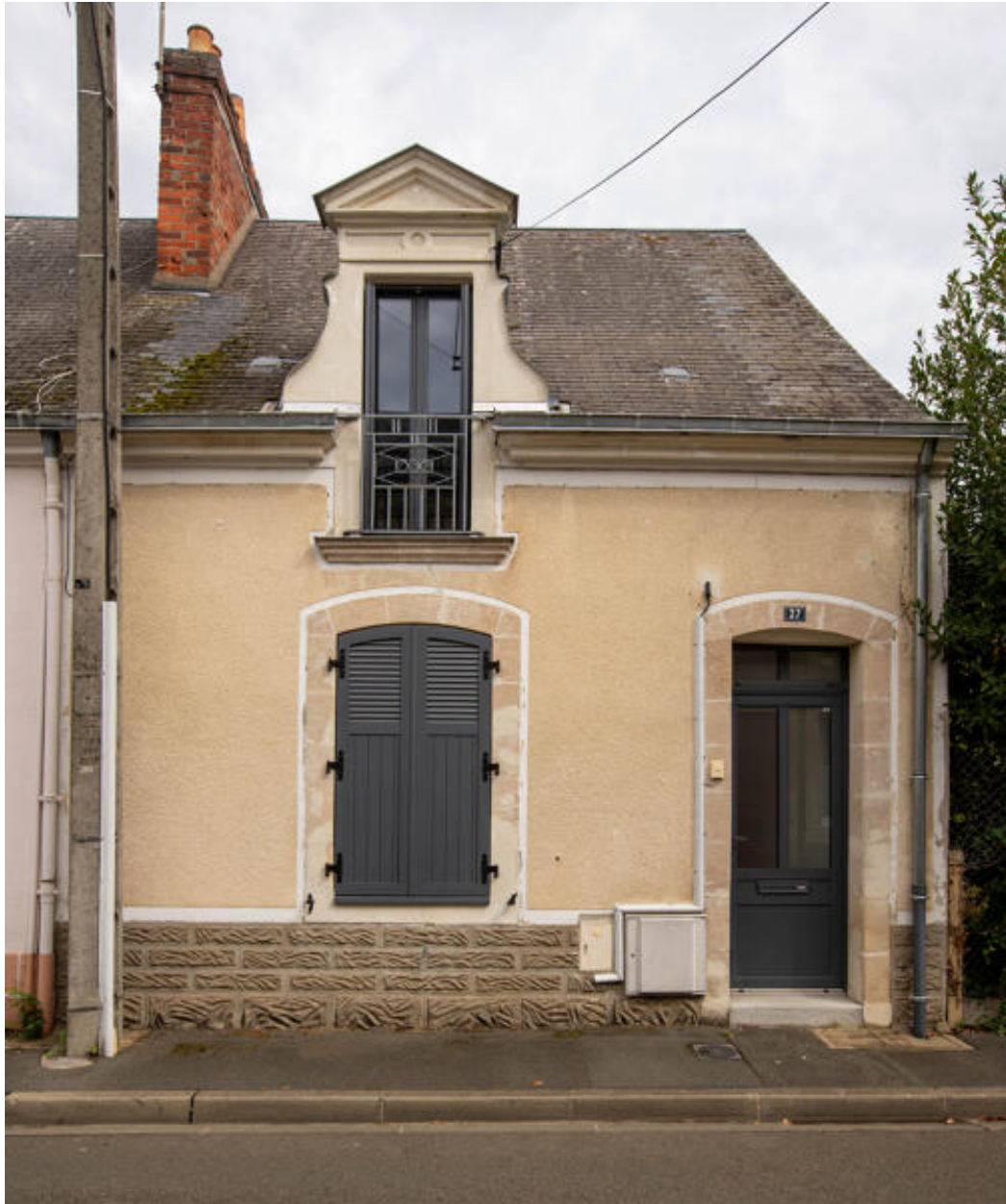
Vue d'une mancelle rue du Ponceau.
