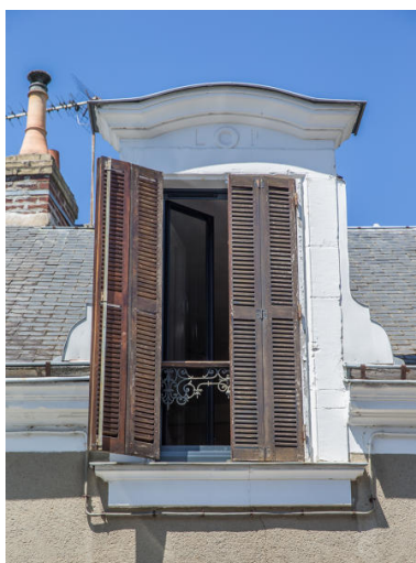
Vue d'une lucarne de pierre rue du 4 septembre. Phot. Pierre-Bernard Fourny IVR52_20187200971NUCA
