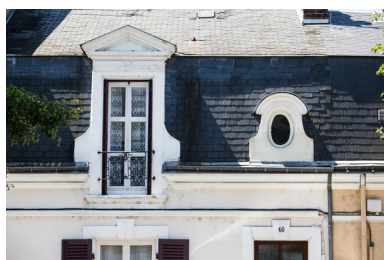
Vue d'une lucarne et d'un oeil de boeuf rue du Colonel-Raynal. Phot. Pierre-Bernard Fourny IVR52_20187200984NUCA
