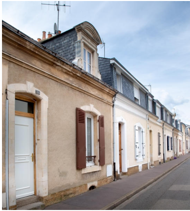
Vue d'un alignement de mancelles rue des Muriers. Phot. Pierre-Bernard Fourny IVR52_20197201356NUCA
