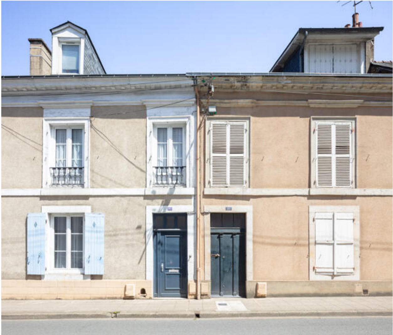
Vue de grandes mancelles à l'armier rue Flore.
