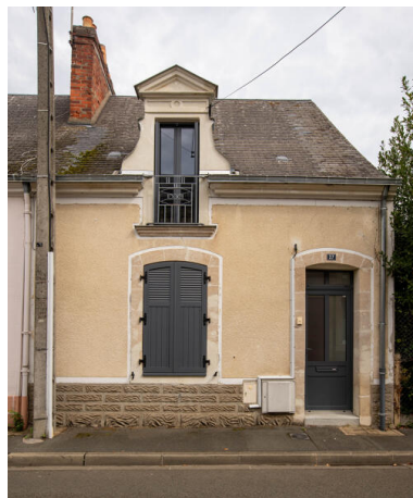
Vue d'une mancelle rue du Ponceau. Phot. Pierre-Bernard Fourny IVR52_20227200997NUCA
