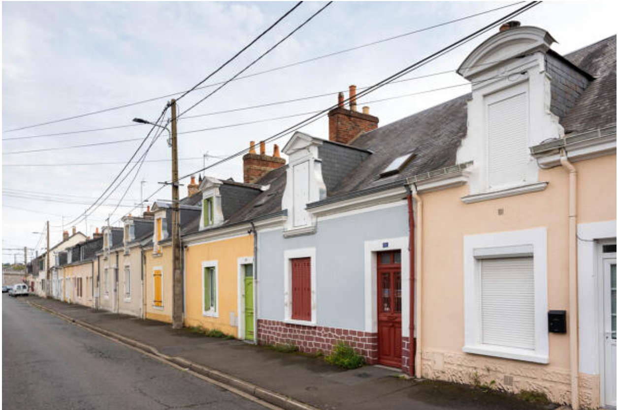
Vue d'un alignement de mancelles rue Alfred-de-Musset.
