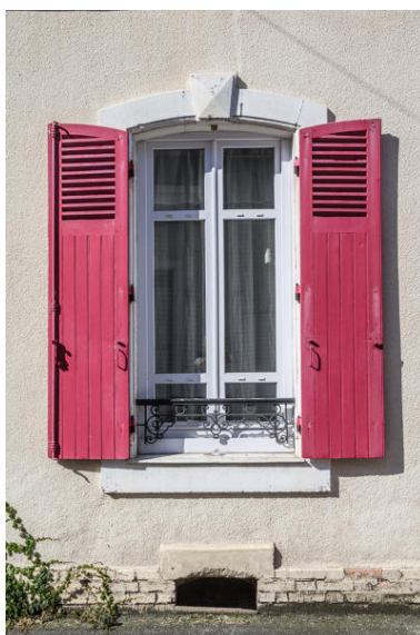
Vue d'une fenêtre en rez-de-chaussée d'une mancelle. Phot. Pierre-Bernard Fourny IVR52_20187200907NUCA
