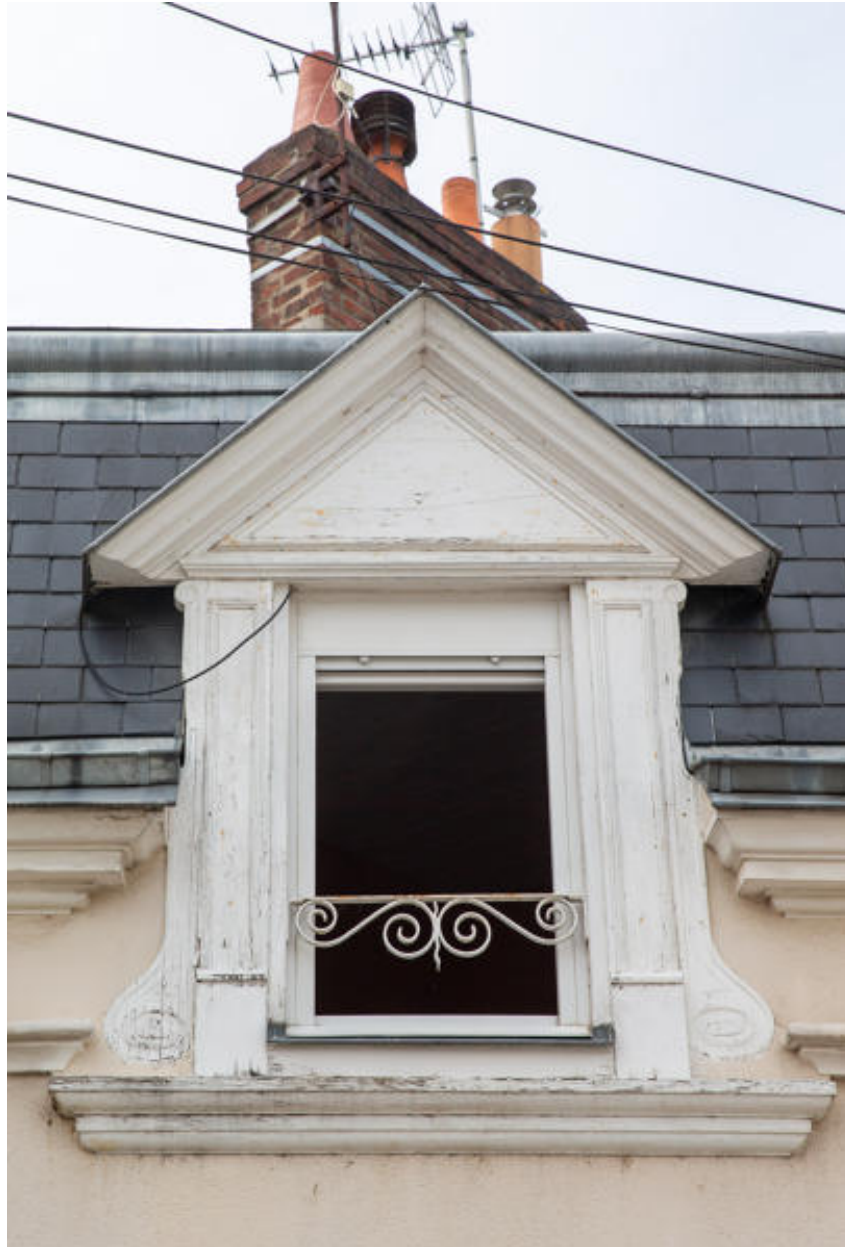
Vue d'une lucarne à jouées de bois rue des Muriers.
