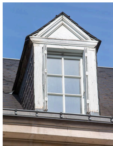
Vue d'une lucarne à jouées de bois rue Montoise. Phot. Pierre-Bernard Fourny IVR52_20197201307NUCA
