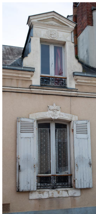
Détail d'une travée de mancelle avec agrafe et tympan de lucarne sculptés. Phot. Pierre-Bernard Fourny IVR52_20197201380NUCA
