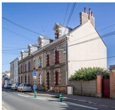
Vue de grandes mancelles avec style 1880 rue Eichthal. Phot. Pierre-Bernard Fourny IVR52_20187200909NUCA
