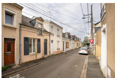
Vue d'une mancelle dans un alignement contemporain. Phot. Pierre-Bernard Fourny IVR52_20227200998NUCA
