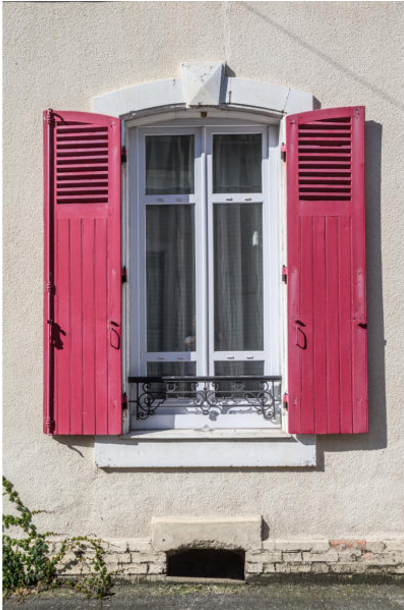
Vue d'une fenêtre en rez-de-chaussée d'une mancelle.
