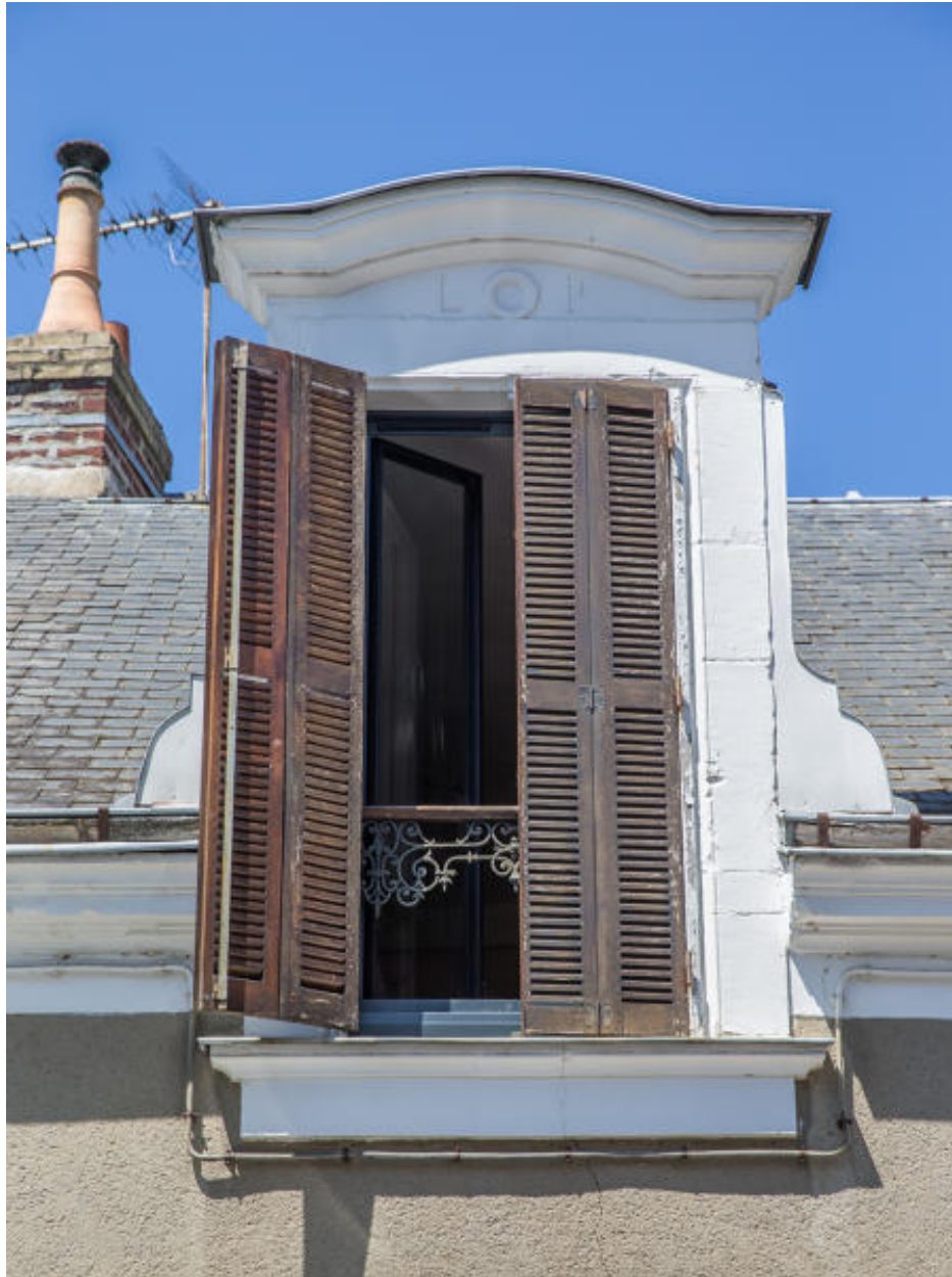
Vue d'une lucarne de pierre rue du 4 septembre.
