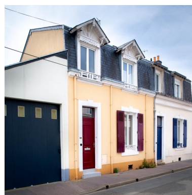
Vue de deux mancelles avec bris de toiture réhaussés rue Fleury. Phot. Pierre-Bernard Fourny IVR52_20197201359NUCA
