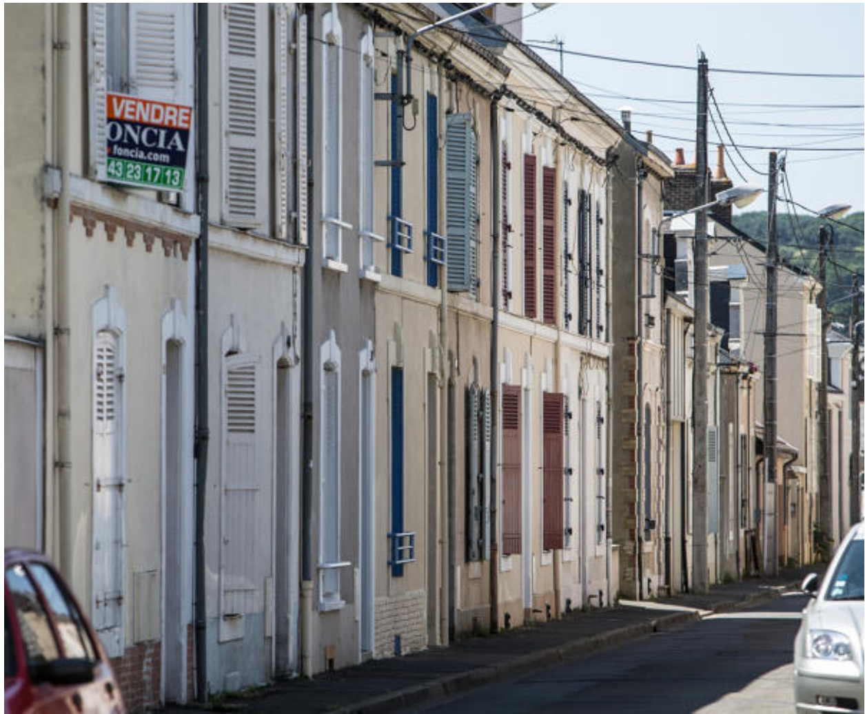
Vue d'un alignement de grande mancelle rue du 4 septembre.
