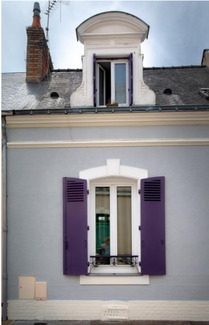
Vue d'une travée latérale d'une mancelle rue Ambroise-Paré.
