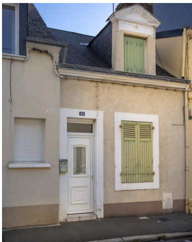
Vue d'une mancelle avec lucarne de bois rue Saint-Pavin. Phot. Pierre-Bernard Fourny IVR52_20197201830NUCA
