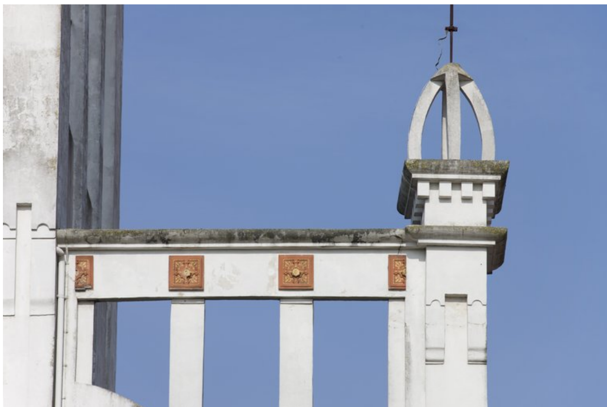
Détail du premier niveau.
