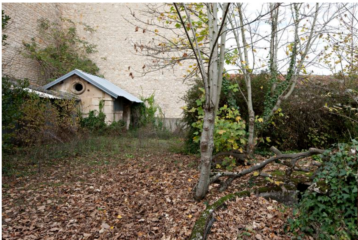
Jardin et dépendance du logement de gardien, du côté ouest.
