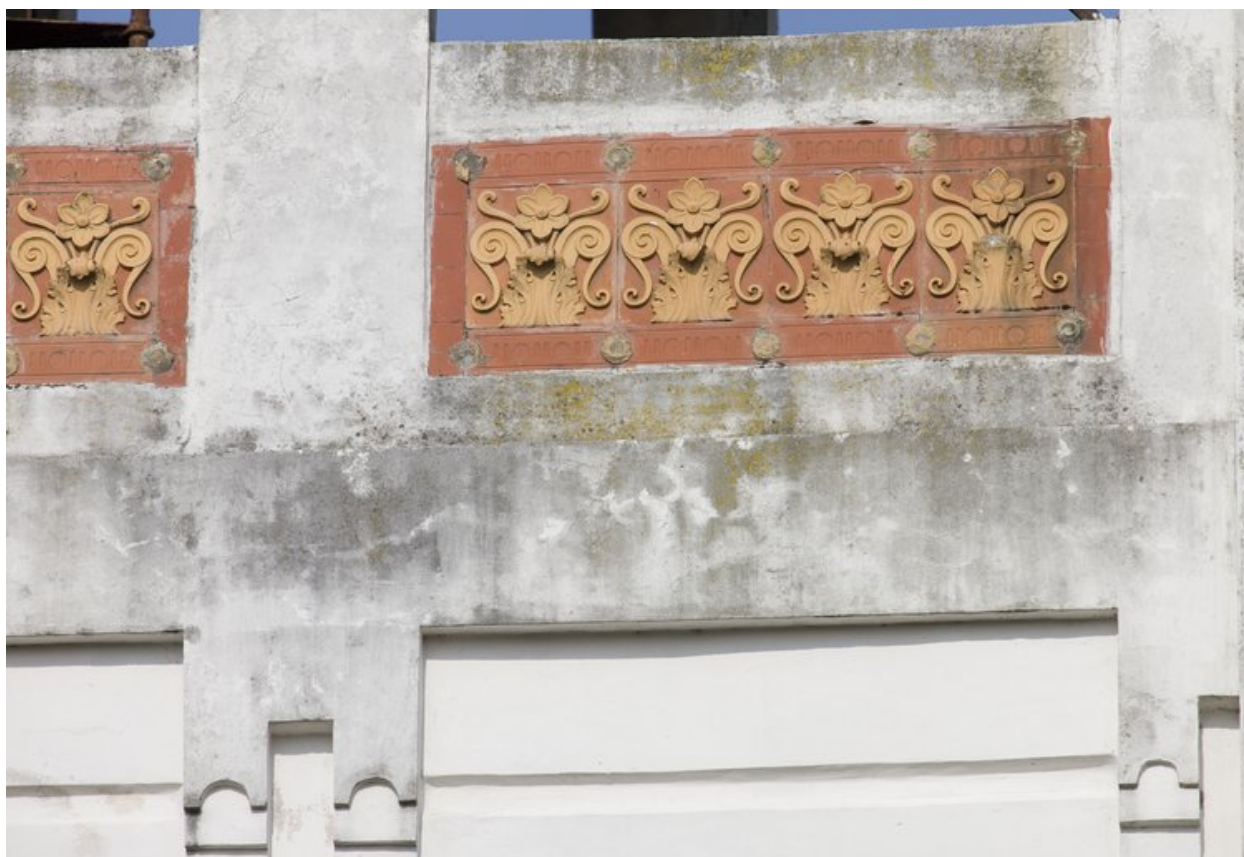
Détail du décor du deuxième niveau.
