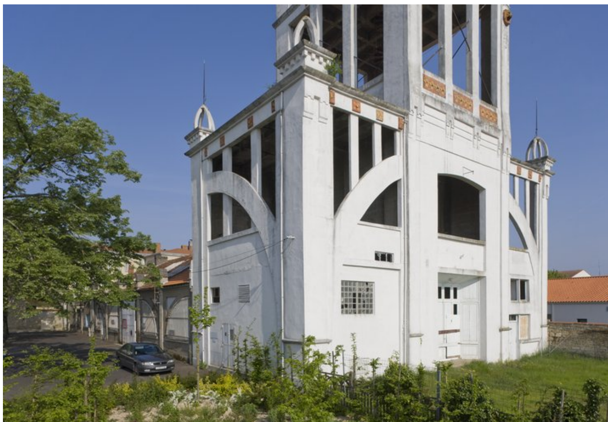
Vue du premier niveau, prise du sud-est.
