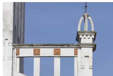
Détail du premier niveau. Phot. Patrice Giraud IVR52_20098500235NUCA
