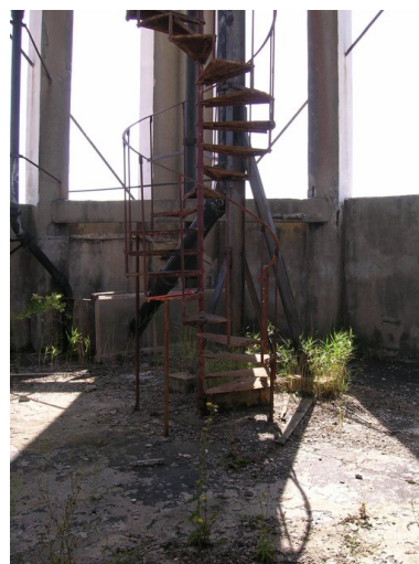
Vue de l'escalier principal. IVR52_20098500530NUCA
