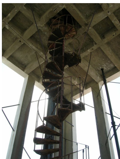
Vue de l'escalier principal. IVR52_20098500531NUCA
