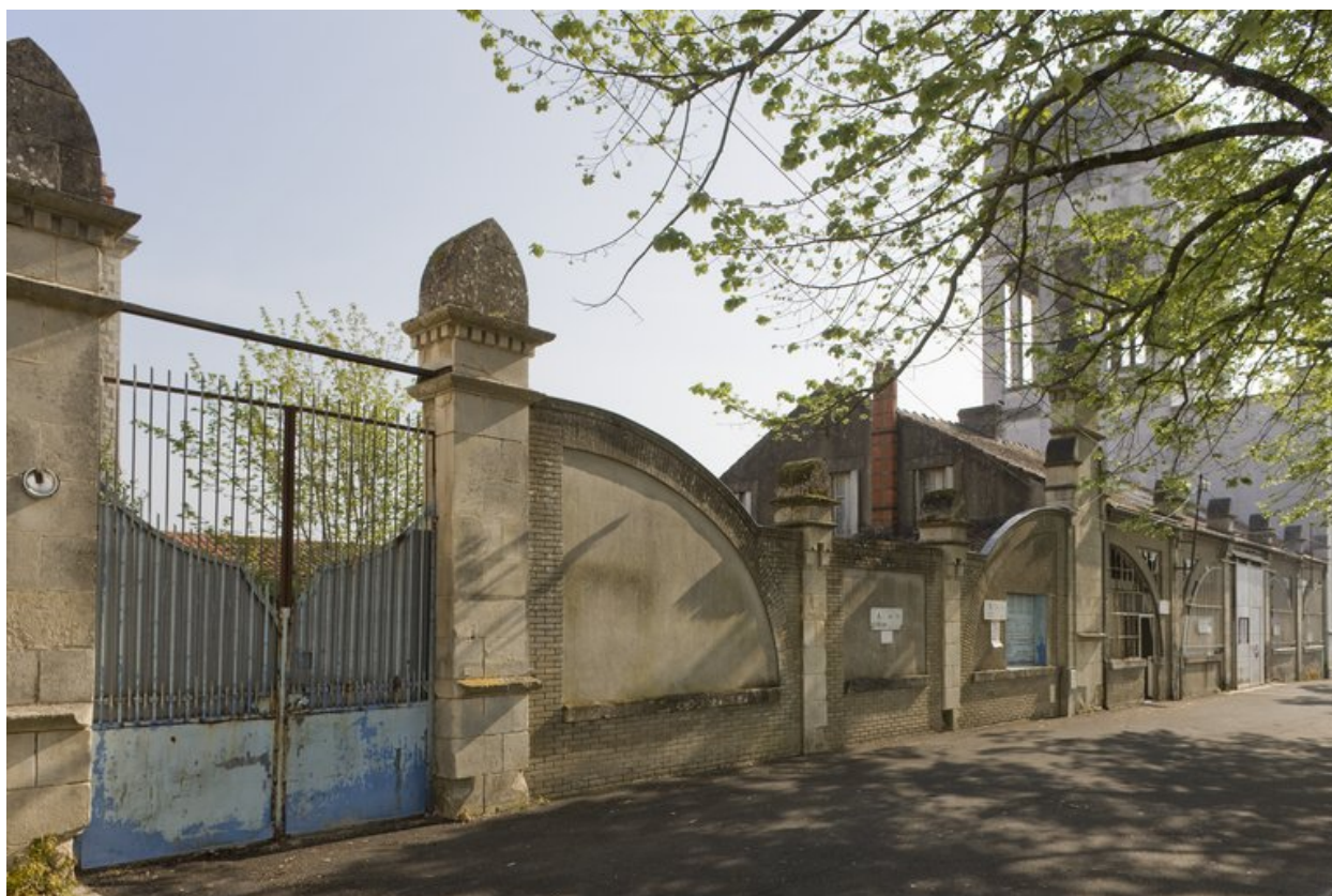
Vue de l'usine électrique, à l'ouest du réservoir.
