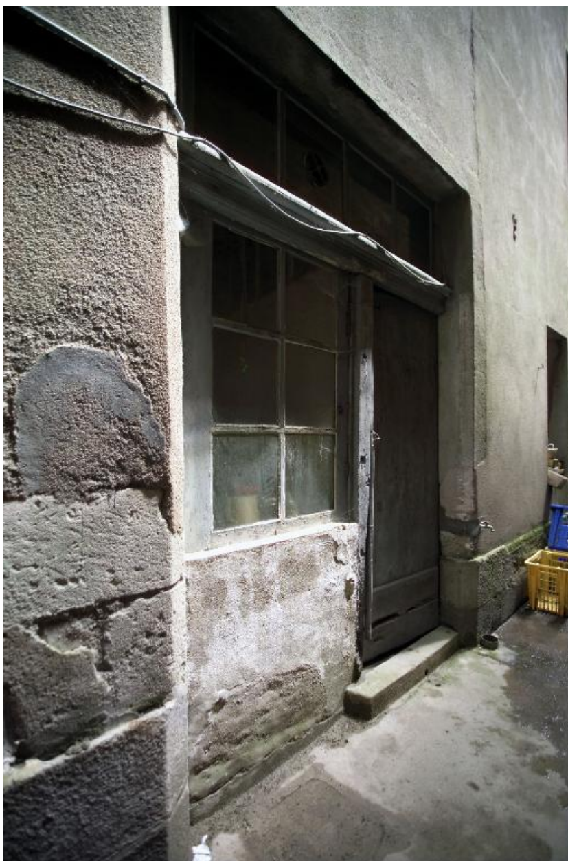
La porte d'accès à l'escalier depuis l'allée.
