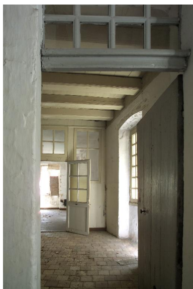
Le corps secondaire vu depuis le palier du premier étage. Phot. Denis Pillet IVR52_20034400684NUCA
