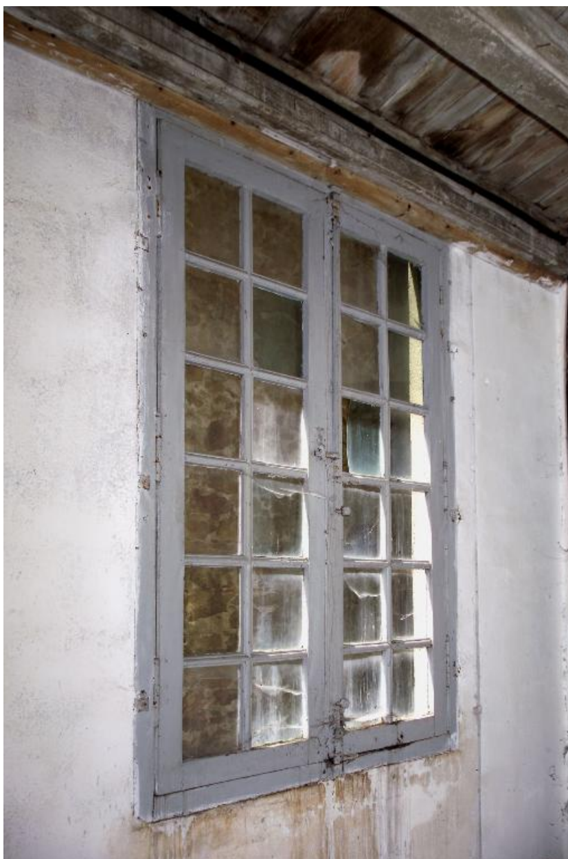
L'escalier, la baie du premier étage.
