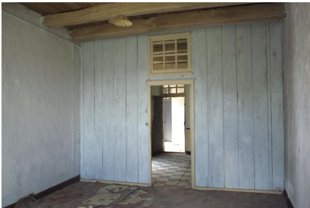
Le corps secondaire, vue d'ensemble vers l'escalier, au premier plan, la cloison de bois.
