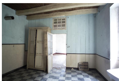
Le corps secondaire, les pièces du deuxième étage, vue prise à partir du palier de l'escalier. Phot. Denis Pillet IVR52_20034400686NUCA
