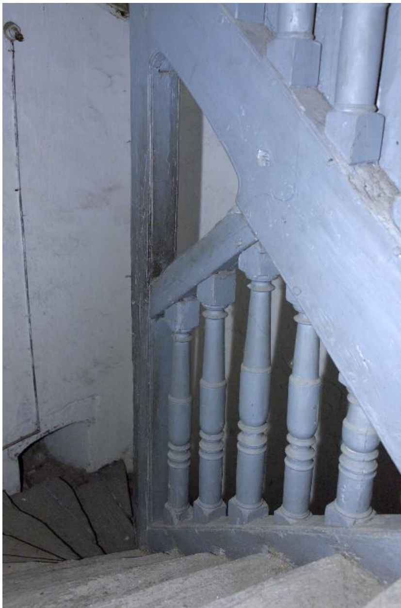
L'escalier, détail des balustres.
