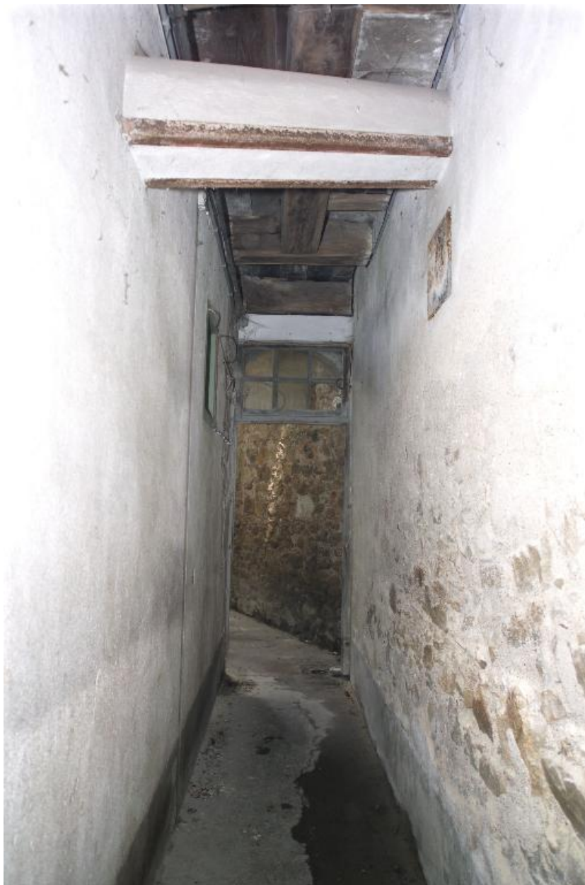
Le couloir d'accès à la cour et à l'escalier depuis la rue.
