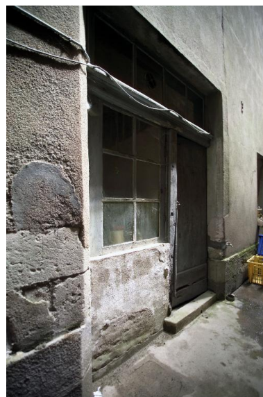
La porte d'accès à l'escalier depuis l'allée.
