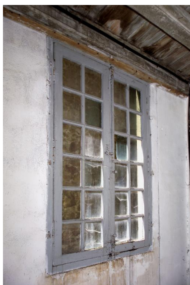
L'escalier, la baie du premier étage. Phot. Denis Pillet IVR52_20034400681NUCA
