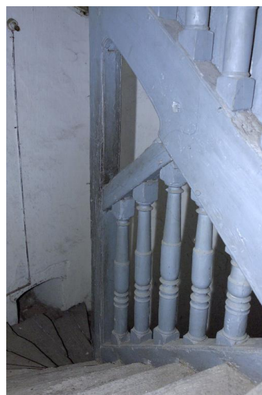
L'escalier, détail des balustres. Phot. Denis Pillet IVR52_20034401141NUCA
