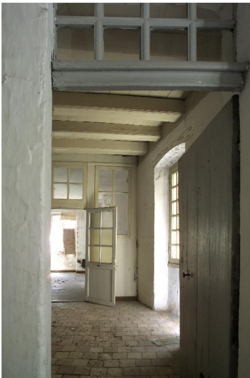
Le corps secondaire vu depuis le palier du premier étage.
