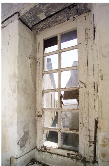
L'allée vue depuis le deuxième étage du corps principal. Phot. Denis Pillet IVR52_20034400697NUCA
