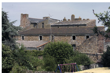
Vue d'ensemble depuis le cœur de l'îlot : en arrière-plan l'immeuble n ° 11, au plan intermédiaire, le corps secondaire de l'immeuble n° 13.
