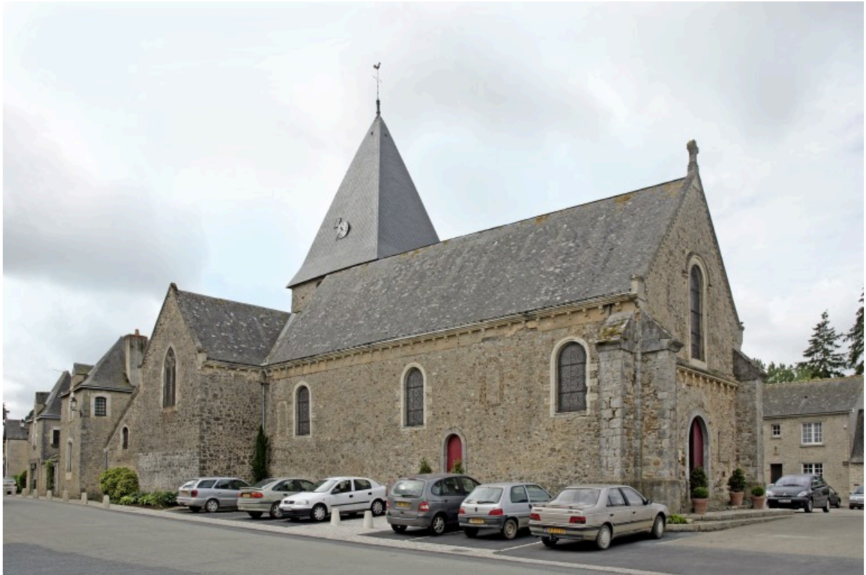
Les élévations nord et ouest vues depuis la rue principale.
