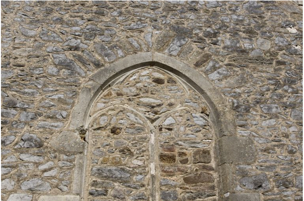
Détail du mur est du chevet : partie supérieure de la baie bouchée.
