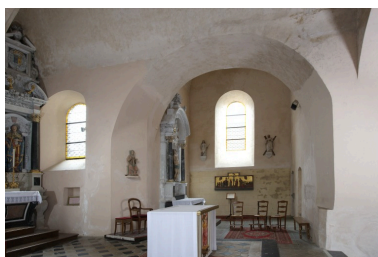
Vue intérieure : la chapelle sud et le mur sud du chœur. Phot. François Lasa IVR52_20065302780NUCA
