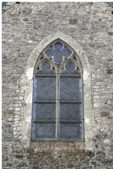
Détail du mur nord de la chapelle nord : la baie. Phot. François Lasa IVR52_20075302237NUCA
