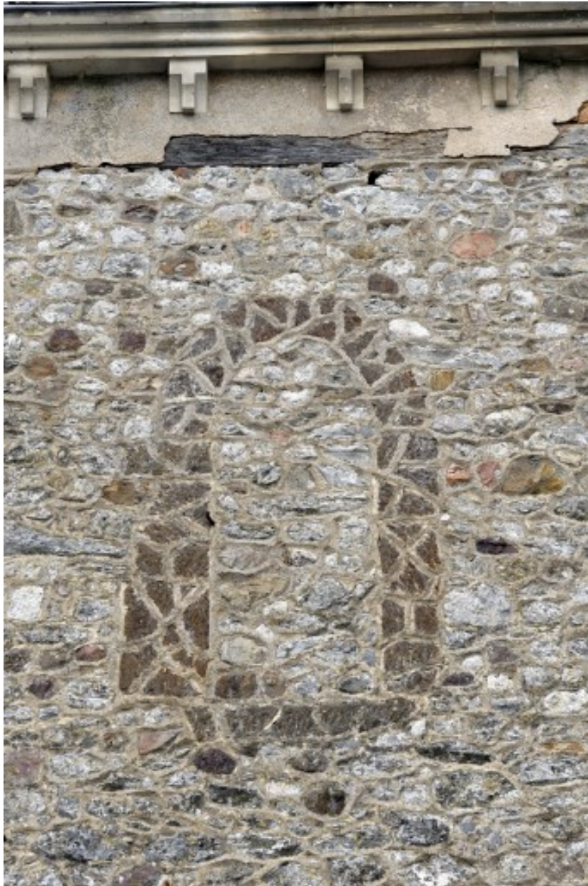
Détail du mur nord de la nef : baie romane bouchée.
