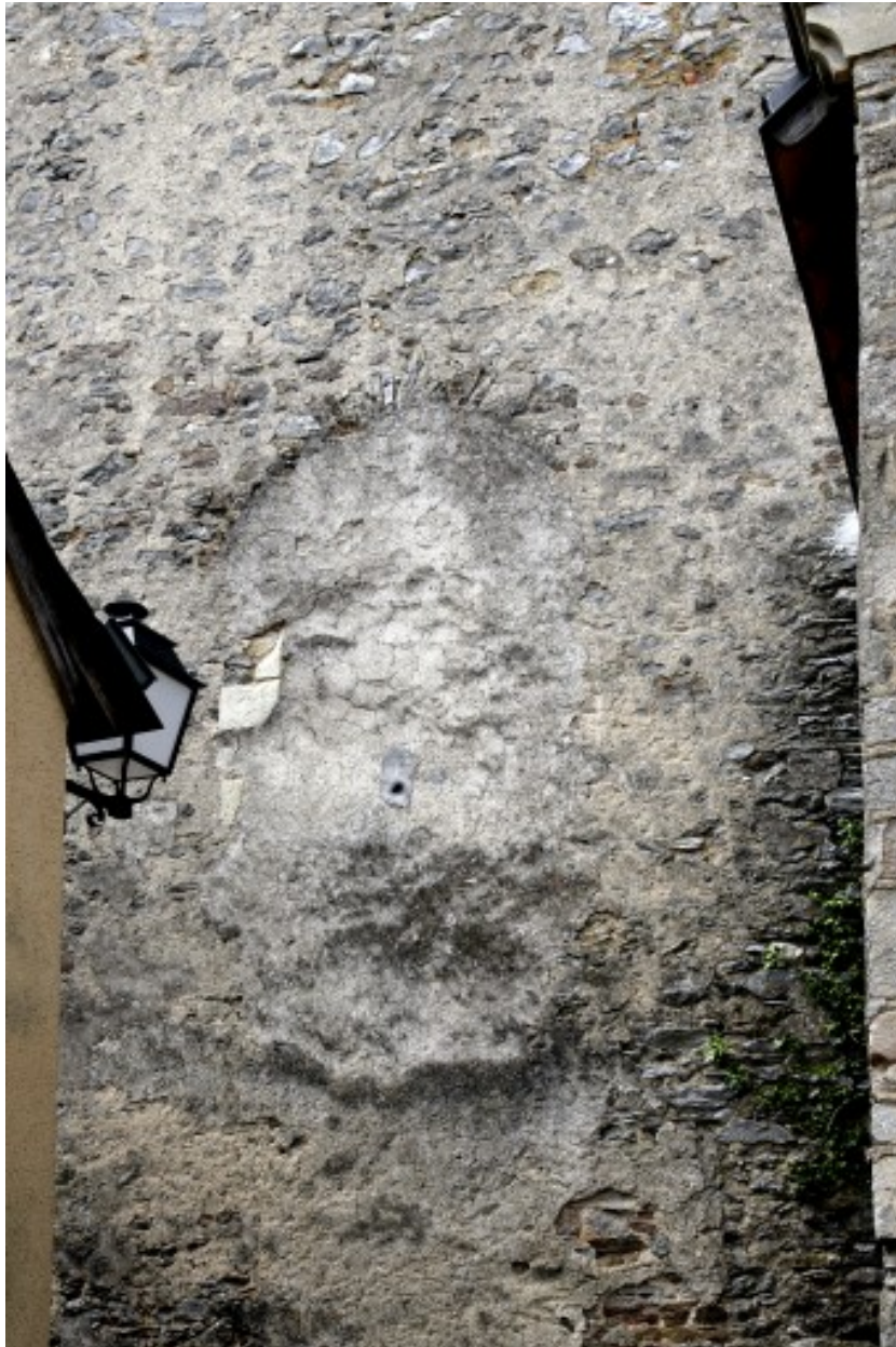
Détail du mur est de la tour : baie bouchée.
