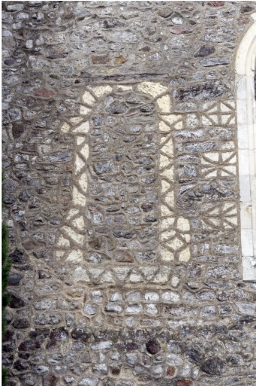
Détail du mur nord de la nef : baie bouchée.
