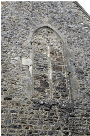
Détail du mur est du chevet : baie bouchée. Phot. François Lasa IVR52_20075302201NUCA
