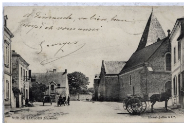
Carte postale, début du XXe siècle : les élévations nord et ouest de l'église vues depuis la rue principale. Autr. Désiré et Henriette Hamel-Jallier, Phot. François Lasa IVR52_20085302318NUCA
