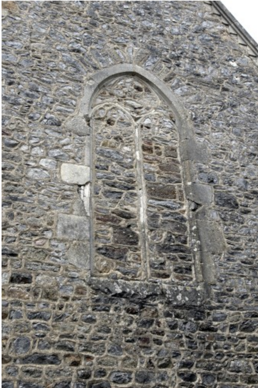
Détail du mur est du chevet : baie bouchée.
