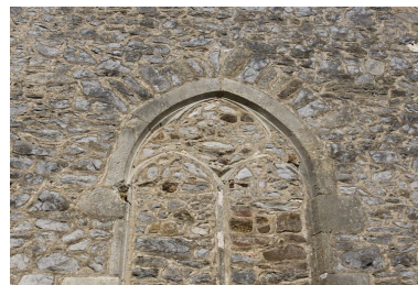
Détail du mur est du chevet : partie supérieure de la baie bouchée. Phot. Yves Guillotin IVR52_20095300142NUCA
