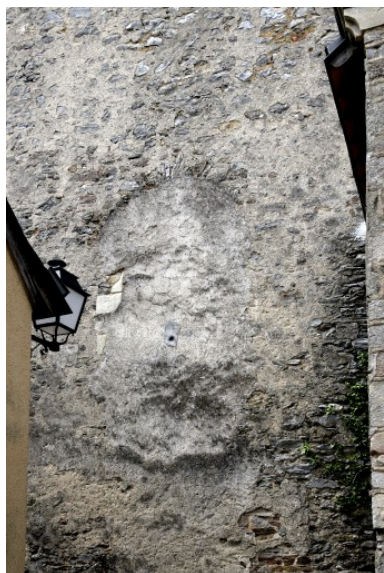
Détail du mur est de la tour : baie bouchée. Phot. François Lasa IVR52_20075302200NUCA
