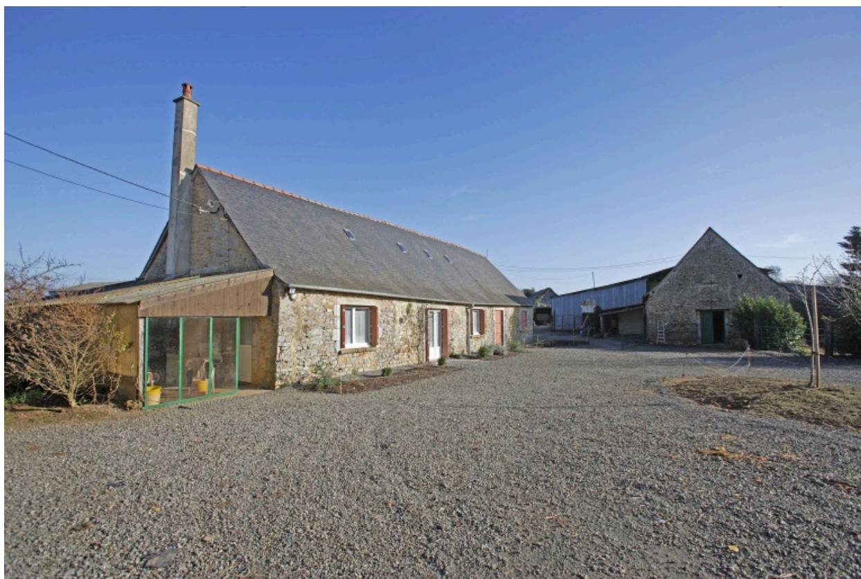
L'ancien logis-étable et le pignon de l'étable vus depuis la cour principale à l'ouest.
