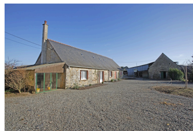
L'ancien logis-étable et le pignon de l'étable vus depuis la cour principale à l'ouest. Phot. François Lasa IVR52_20065302865NUCA
