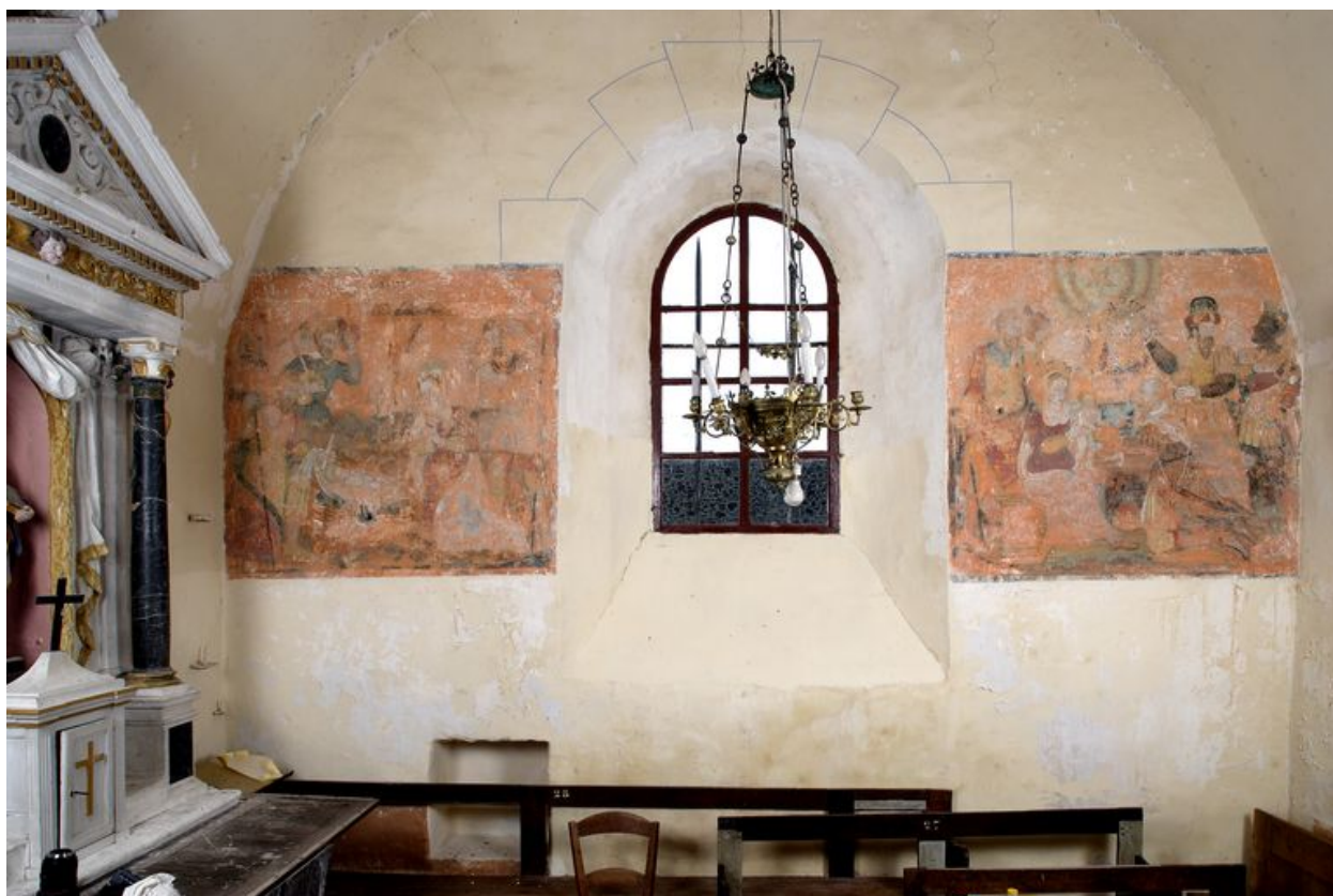
Vue d'ensemble du mur sud de la chapelle sud.
