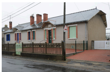
Maisons ouvrières situées rue Principale. Phot. Bruno Rousseau IVR52_20104902256NUCA
