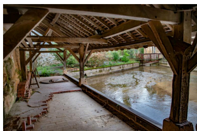
L'intérieur du lavoir. Phot. Pierre-Bernard Fourny IVR52_20197202505NUCA
