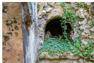
Une ancienne évacuation des eaux de ruissellement. Phot. Pierre-Bernard Fourny IVR52_20197202503NUCA
