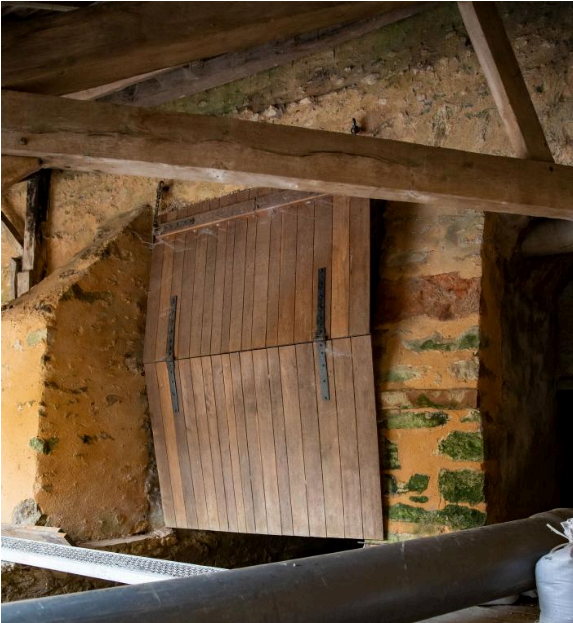
Une arche du pont sous le lavoir.
