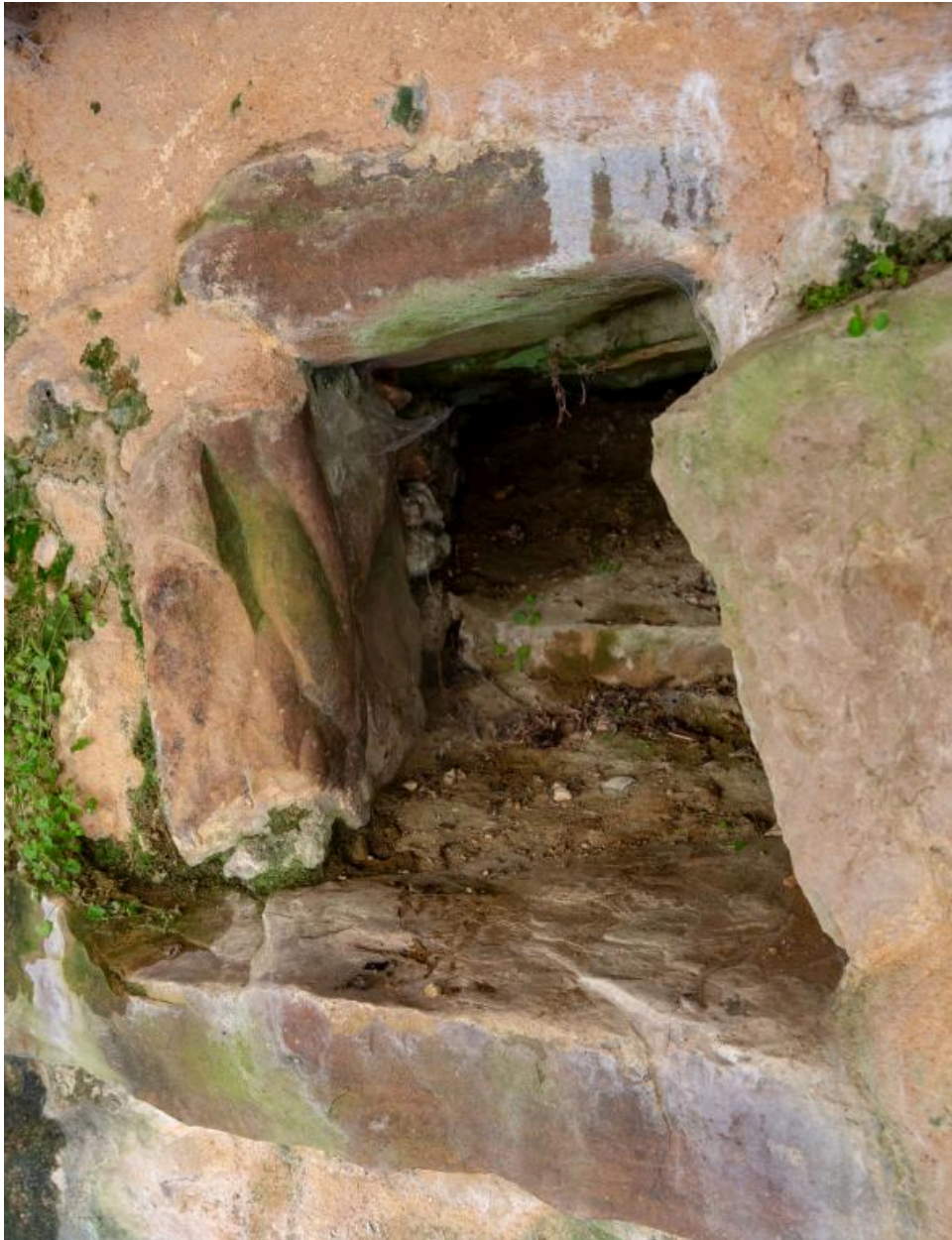
Une ancienne évacuation des eaux de ruissellement.
