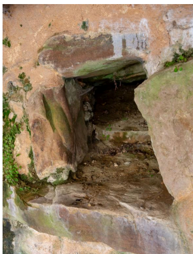
Une ancienne évacuation des eaux de ruissellement. Phot. Pierre-Bernard Fourny IVR52_20197202502NUCA
