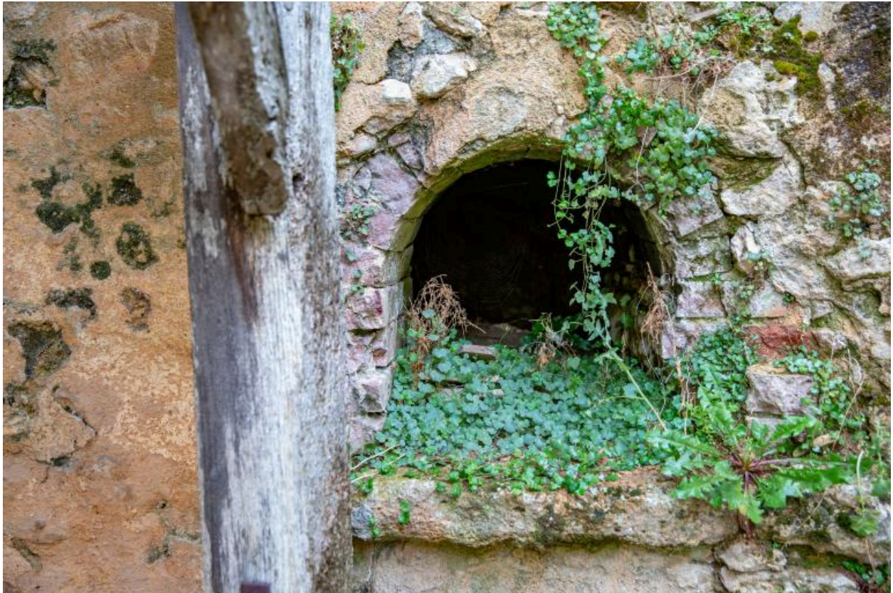
Une ancienne évacuation des eaux de ruissellement.
