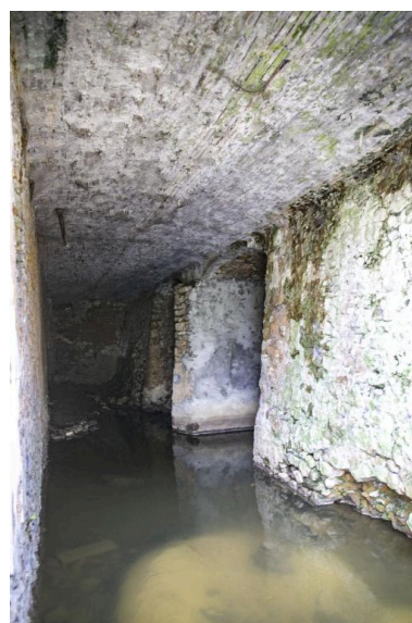
Le pont côté nord. Phot. Pierre-Bernard Fourny IVR52_20197202938NUCA
