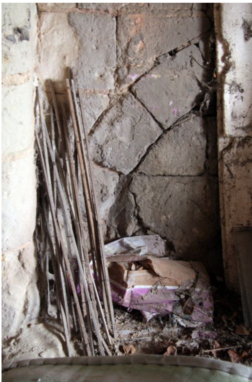
le logis, 1er étage, détail : le foyer en pierre de la cheminée sud avec son arc de décharge.
