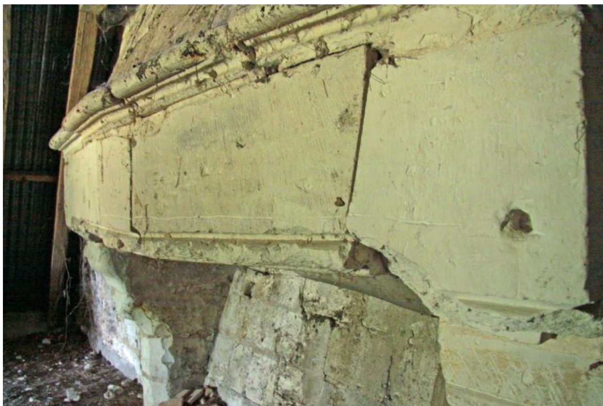
Le logis, comble, cheminée : manteau brisé.
