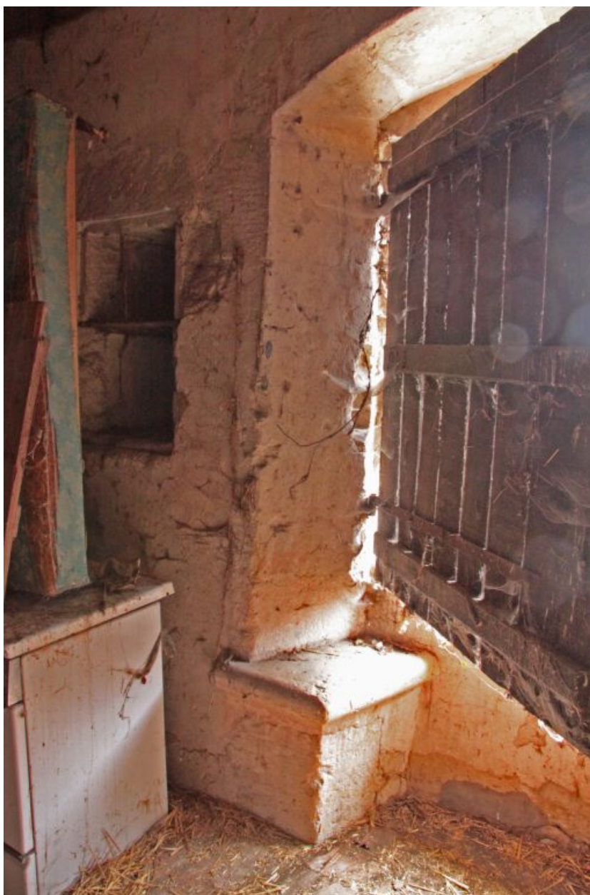
Le logis, 1er étage, détail : la croisée et la niche.
