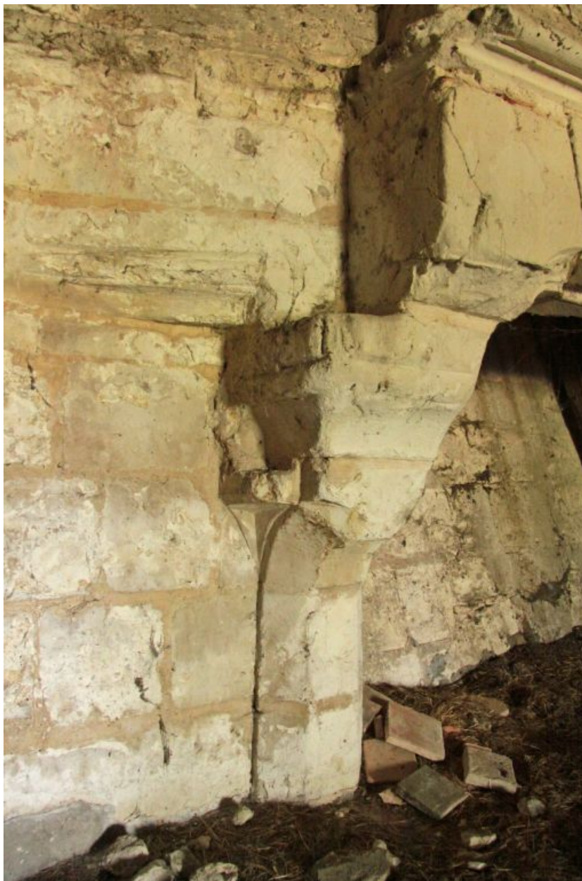
Le logis, comble, cheminée : piédroit gauche.
