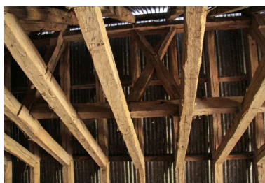
Le logis, comble : la charpente. Phot. Jean-Baptiste Darrasse IVR52_20097200777NUCA
