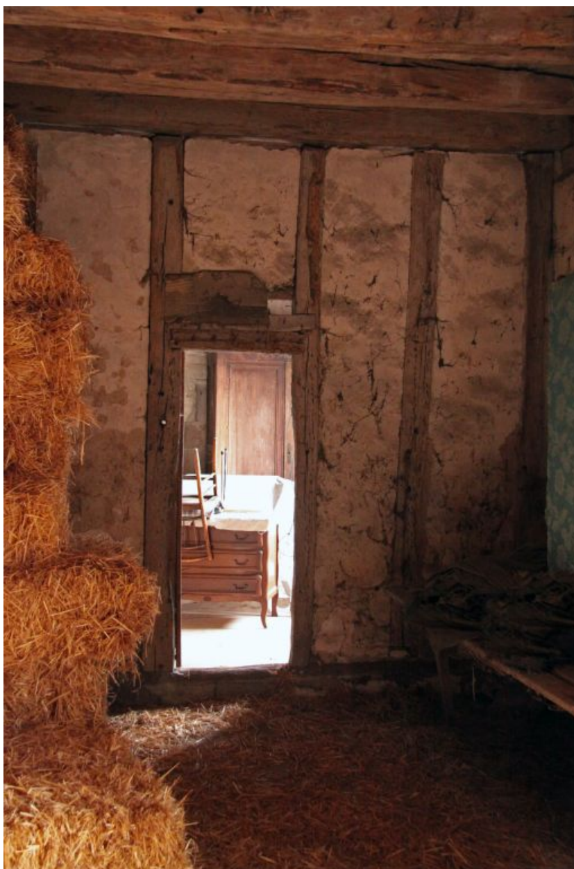
le logis, 1er étage : cloison en pan-de-bois.
