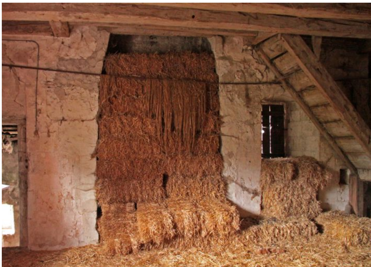
Le logis, 1er étage, pignon nord : cheminée ajoutée au début du XVIe siècle et qui bouche la 1ère baie.
