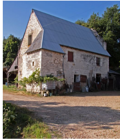
Le logis, façade O sur la cour. Phot. Jean-Baptiste Darrasse IVR52_20097200390NUCA
