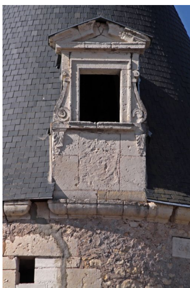
Grosse tour sud-ouest : lucarne à fronton. Phot. Jean-Baptiste Darrasse IVR52_20097200401NUCA
