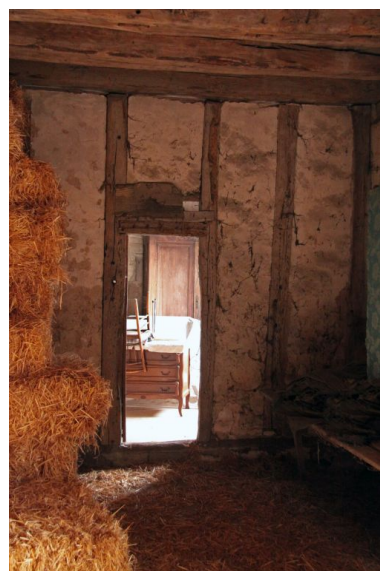
le logis, 1er étage : cloison en pan-de-bois. Phot. Jean-Baptiste Darrasse IVR52_20097200784NUCA
