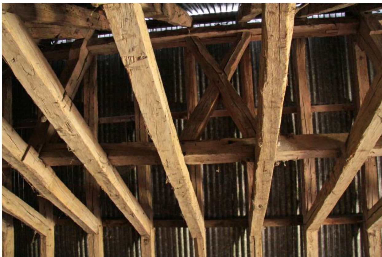
Le logis, comble : la charpente.
