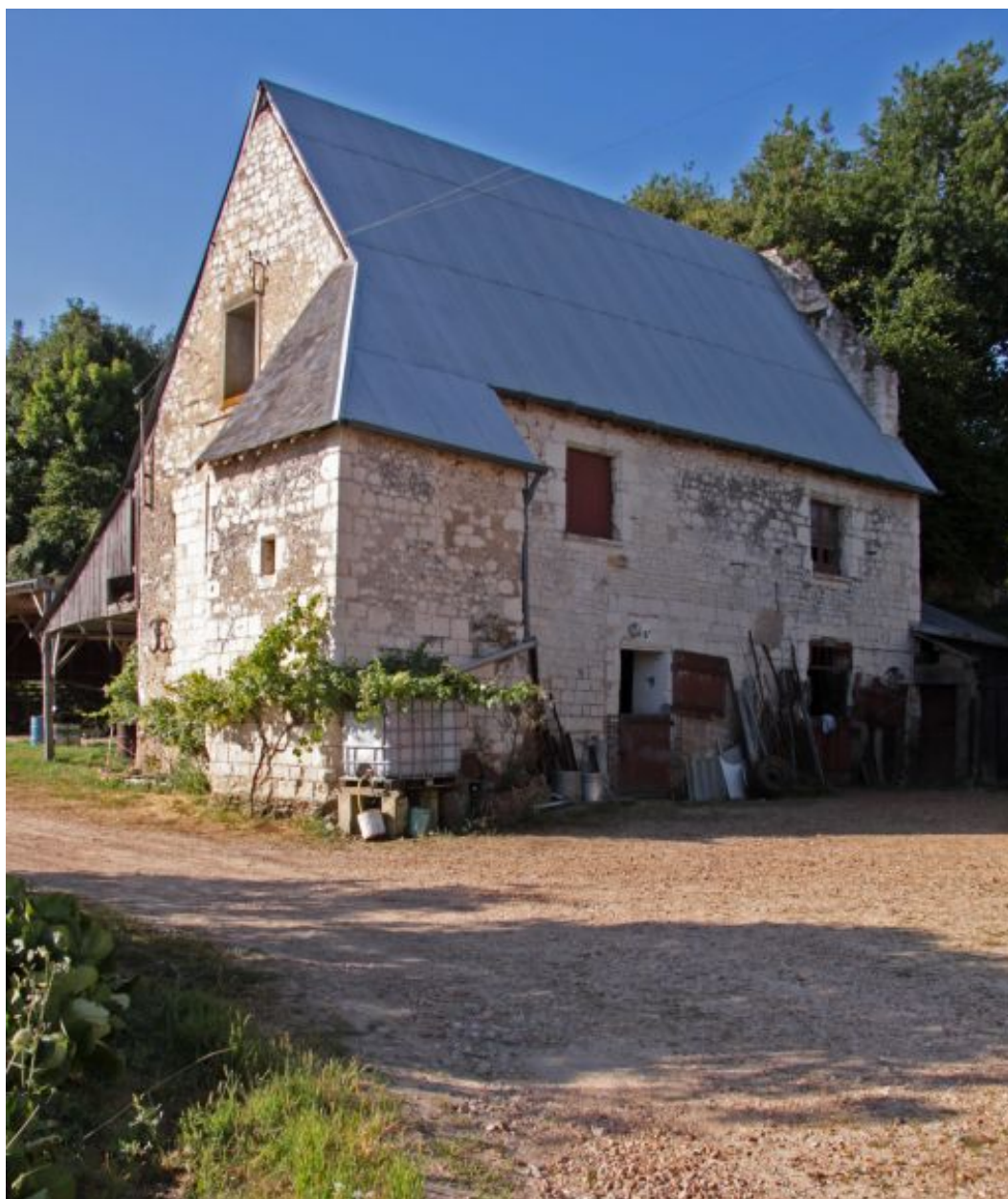
Le logis, façade O sur la cour.
