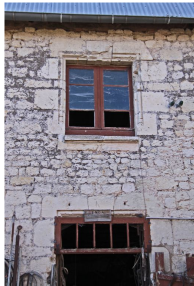
Le logis, façade ouest, travée de baies : ancienne croisée et linteau de fenêtre transformée en porte d'étable ? Phot. Jean-Baptiste Darrasse IVR52_20097200395NUCA
