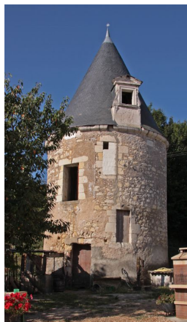
Grosse tour au sud-ouest de la cour. Phot. Jean-Baptiste Darrasse IVR52_20097200393NUCA
