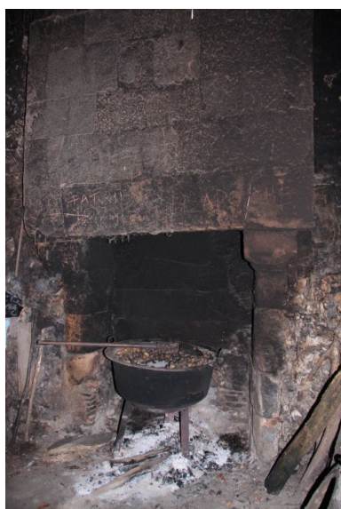
Grosse tour S-0, rez-de-chaussée : cheminée (1606). Phot. Jean-Baptiste Darrasse IVR52_20097200807NUCA
