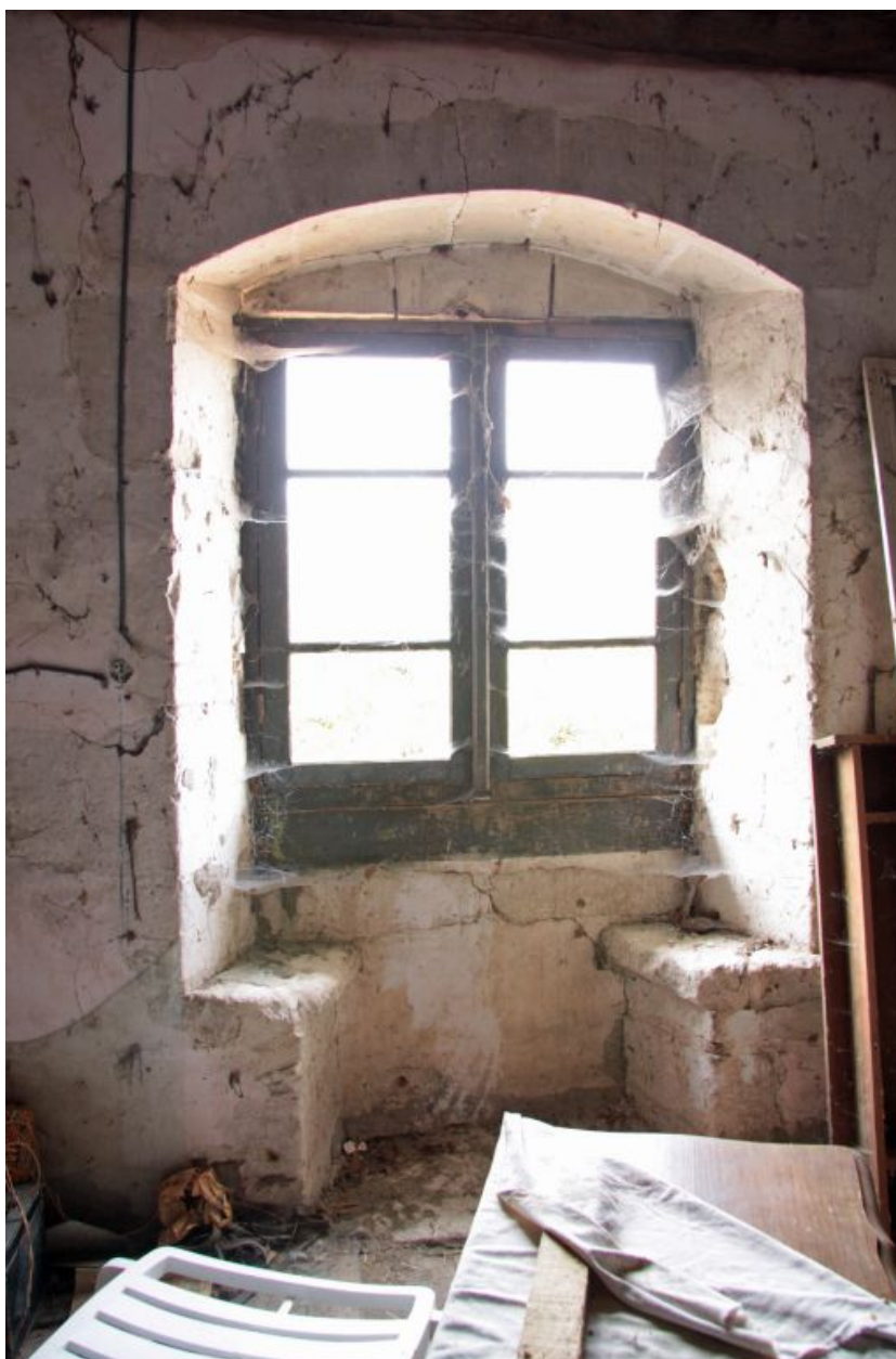
Le logis, 1er étage, détail : revers de la 2e croisée à coussièges.
