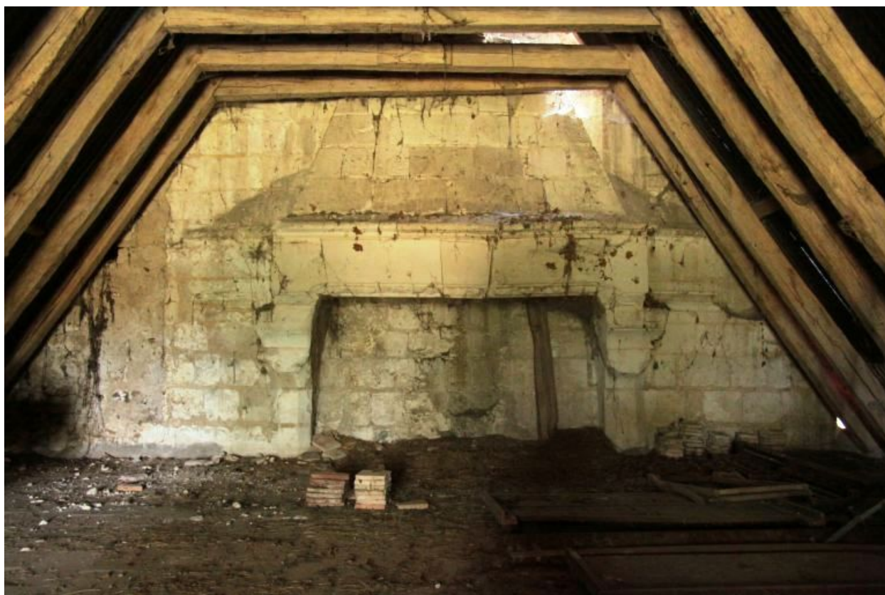
Le logis, comble : grande cheminée en pierre sous charpente.
