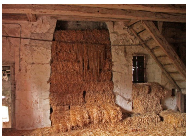
Le logis, 1er étage, pignon nord : cheminée ajoutée au début du XVIe siècle et qui bouche la 1ère baie. Phot. Jean-Baptiste Darrasse IVR52_20097200786NUCA
