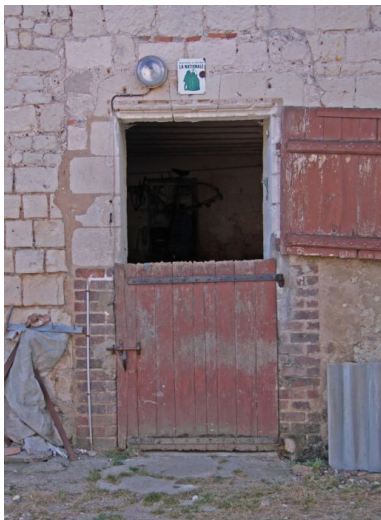
Le logis, façade O, détail : porte d'étable aménagée avec un linteau en réemploi. Phot. Jean-Baptiste Darrasse IVR52_20097200394NUCA
