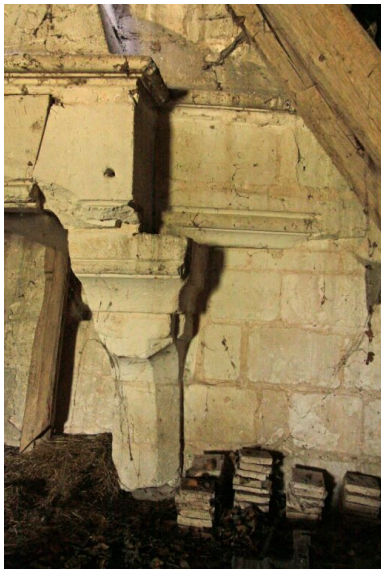
Le logis, comble, cheminée : piédroit droit. Phot. Jean-Baptiste Darrasse IVR52_20097200773NUCA
