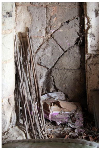
le logis, 1er étage, détail : le foyer en pierre de la cheminée sud avec son arc de décharge. Phot. Jean-Baptiste Darrasse IVR52_20097200766NUCA
