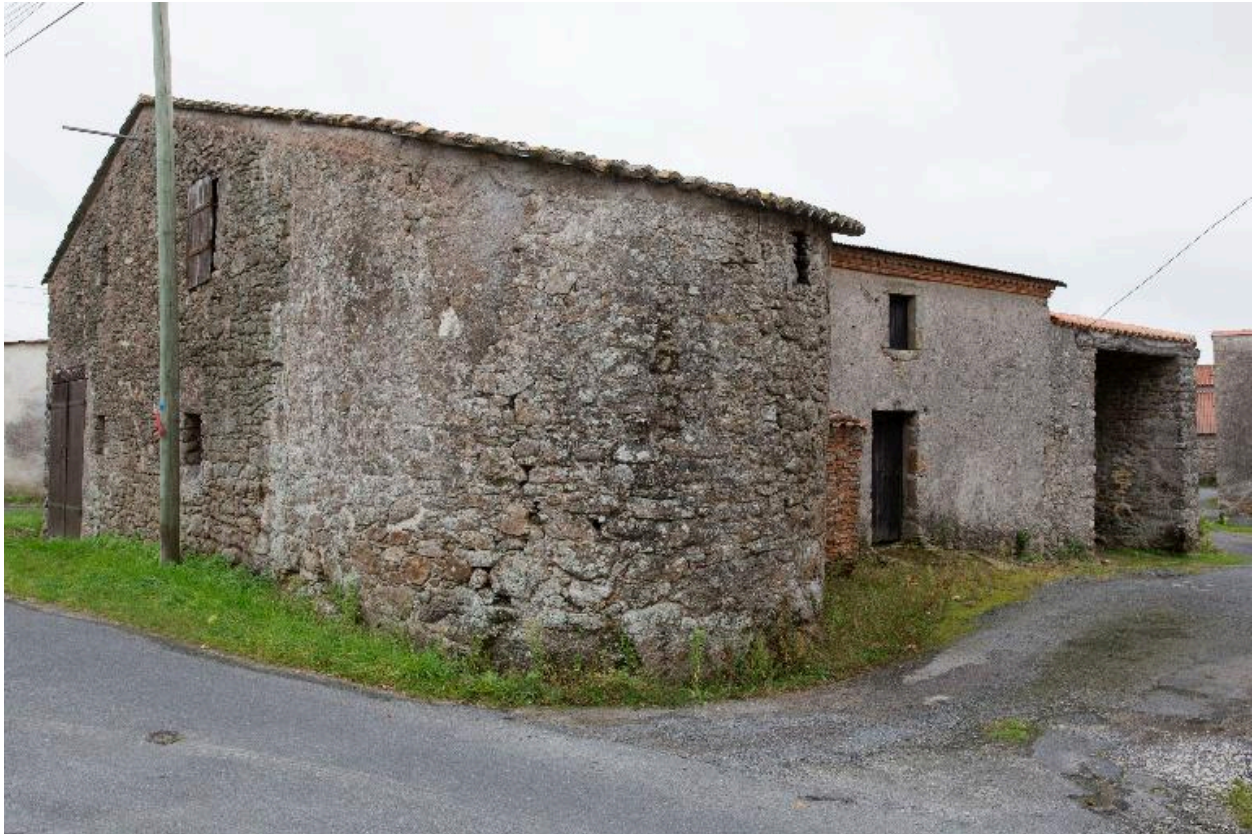
Dépendance avec maçonnerie en arrondi, AW01-212, cadastre 2018.
