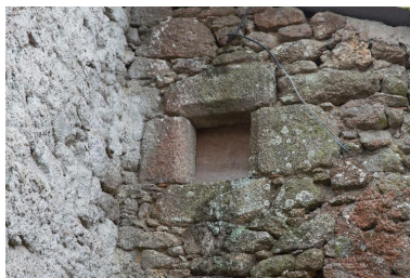
Baie à chanfrein Phot. Denis Pillet IVR52_20154400674NUCA
