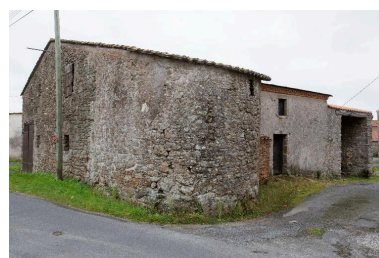
Dépendance avec maçonnerie en arrondi, AW01-212, cadastre 2018. Phot. Denis Pillet IVR52_20154400672NUCA
