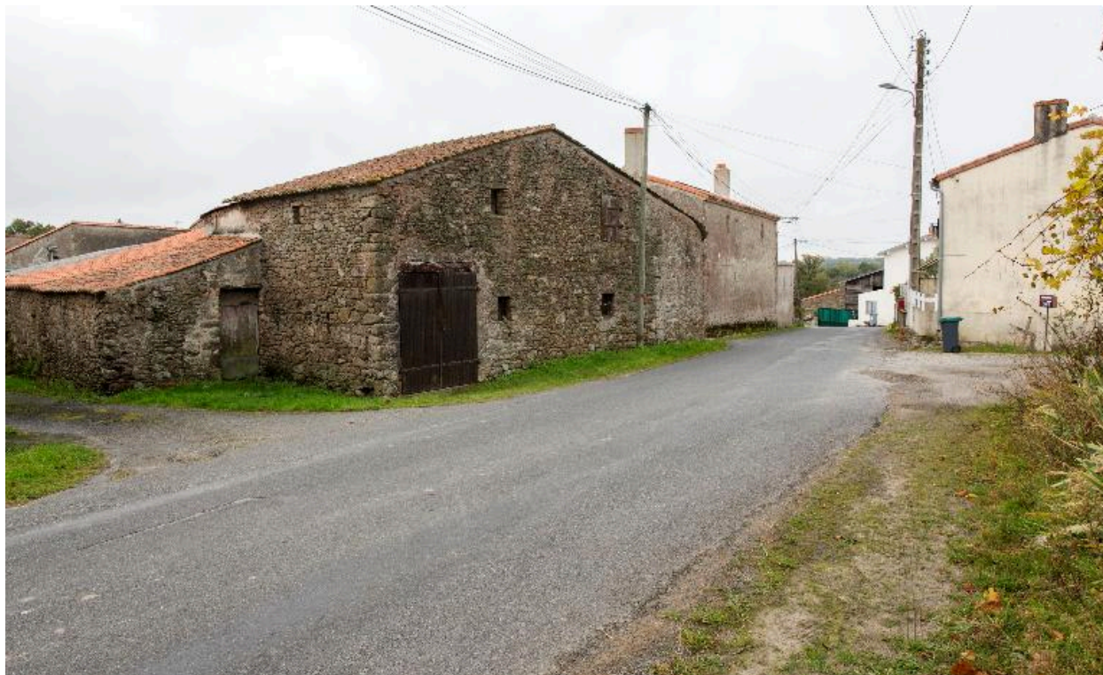
Dépendance construite au XIXe siècle, AW01-212, cadastre 2018.
