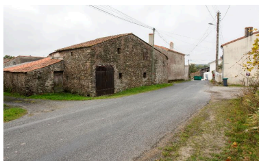
Dépendance construite au XIXe siècle, AW01-212, cadastre 2018. Phot. Denis Pillet IVR52_20154400664NUCA
