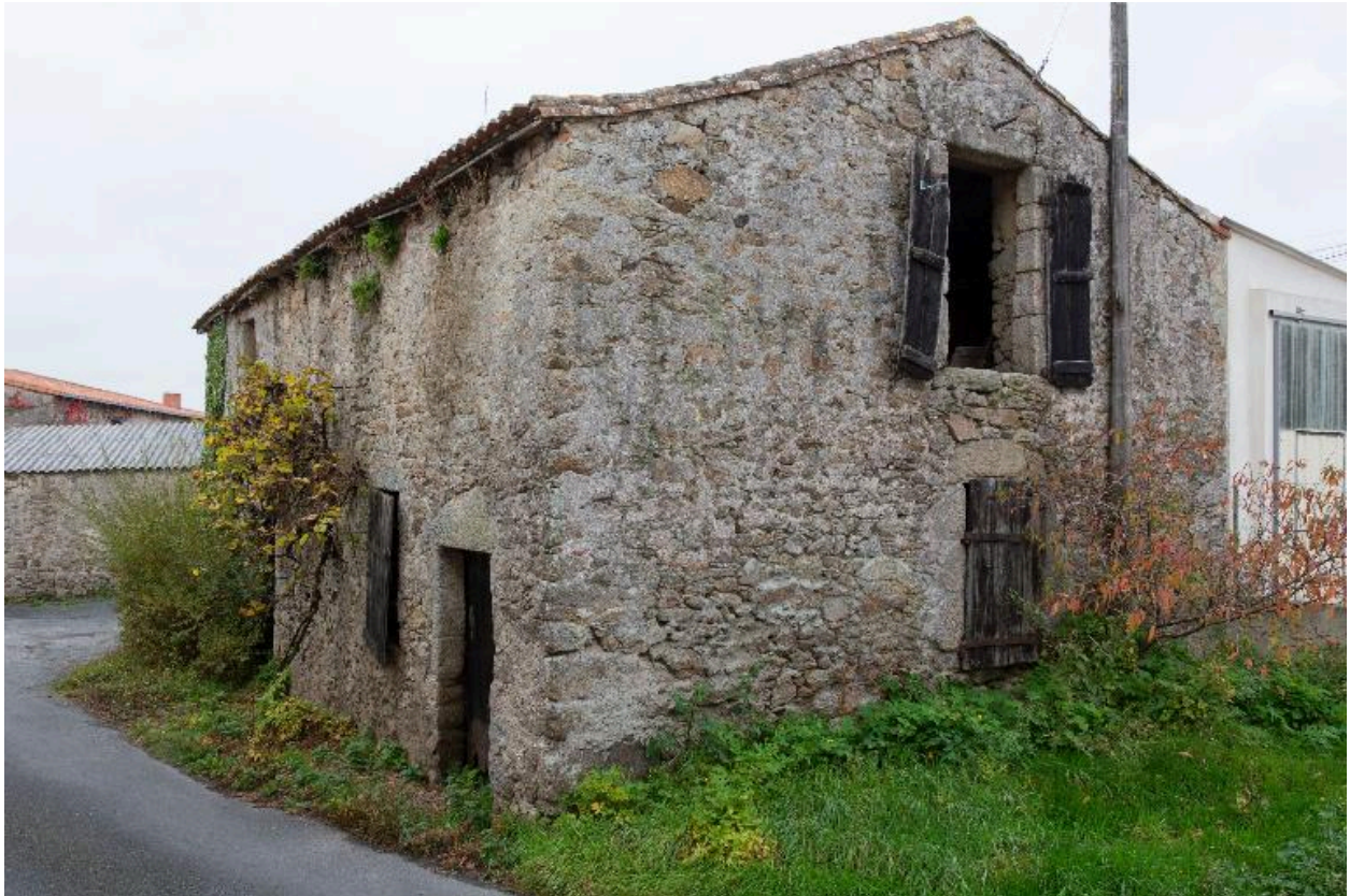
Maison, vue du pignon, AW01-214, cadastre 2018.
