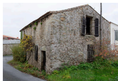
Maison, vue du pignon, AW01-214, cadastre 2018. Phot. Denis Pillet IVR52_20154400668NUCA
