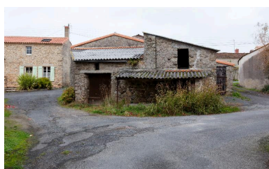
Îlot bâti, AW01-736, cadastre 2018. Phot. Denis Pillet IVR52_20154400670NUCA
