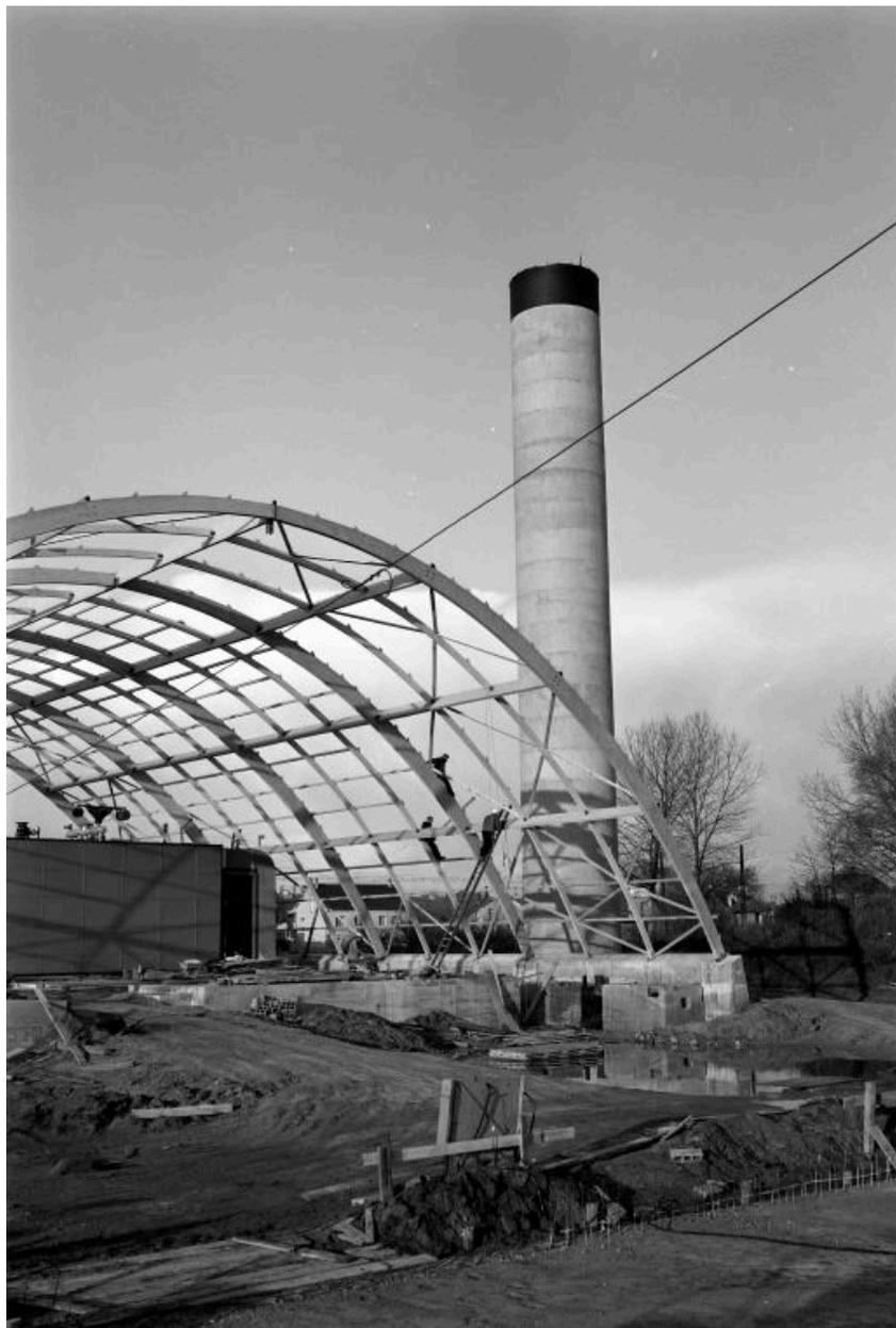
Vue de la structure métallique de la chaufferie pendant le chantier, 1965.
