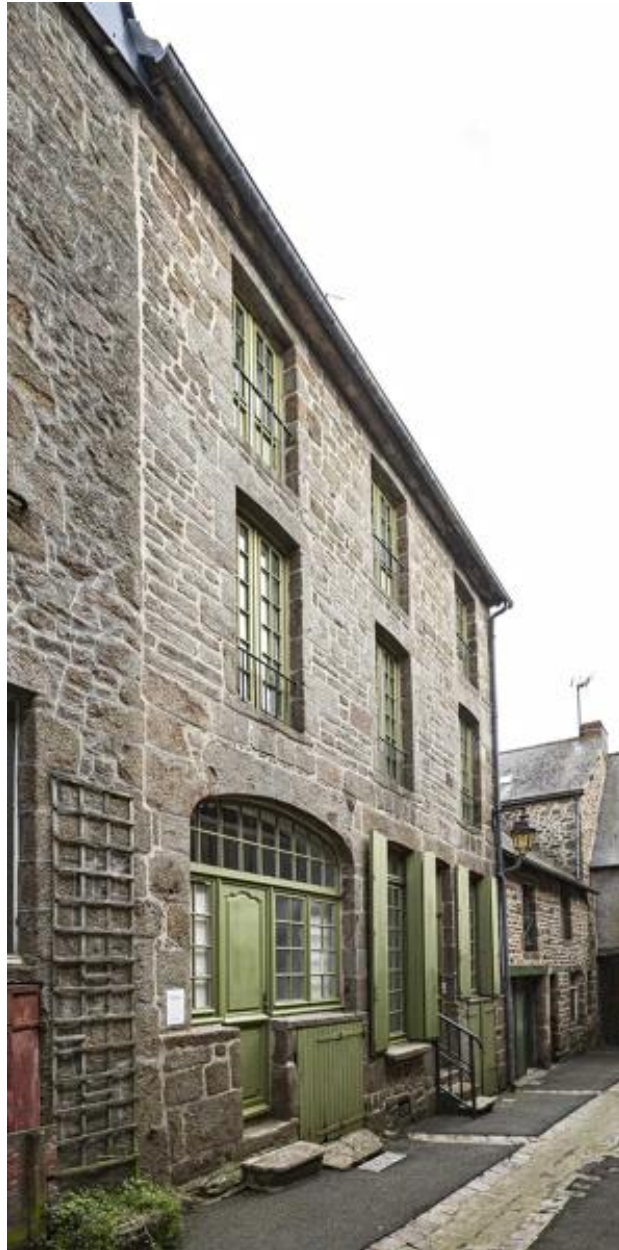
Maison et ancienne boutique, 4 rue Cébaudière, vue depuis le nord.
