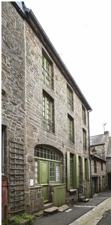
Maison et ancienne boutique, 4 rue Cébaudière, vue depuis le nord. Phot. Yves Guillotin IVR52_20215300804NUCA
