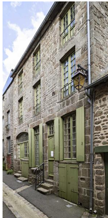
Maison et ancienne boutique, 4 rue Cébaudière, vue depuis le sud. Phot. Yves Guillotin IVR52_20215300803NUCA
