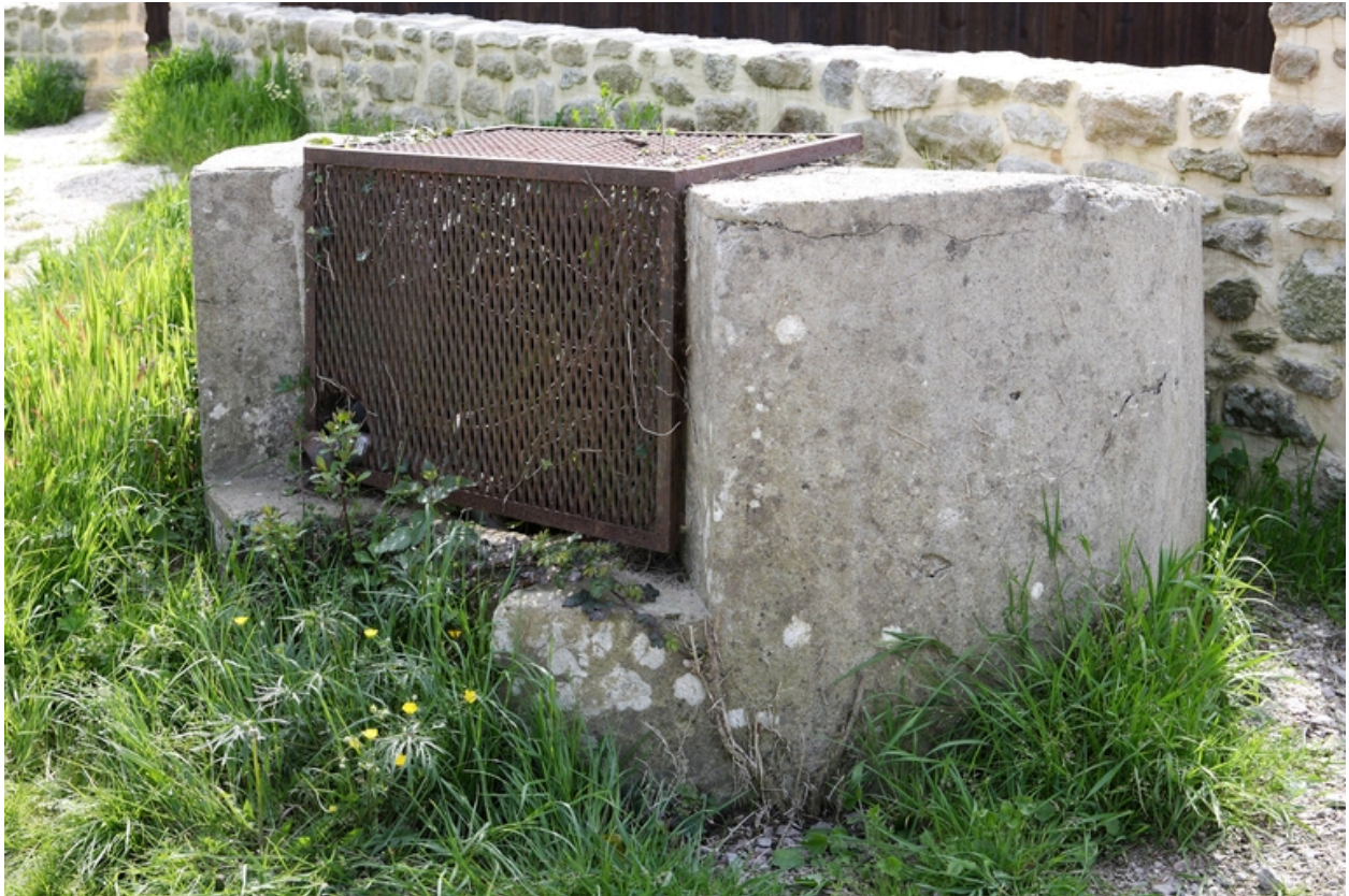
Vue du puits commun.
