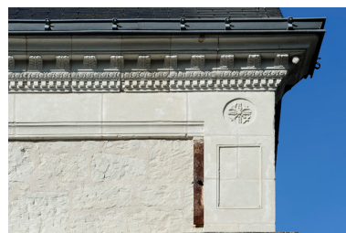
Détail de la corniche Phot. Bruno Rousseau, Phot. Youenn Communeau IVR52_20114900694NUCA
