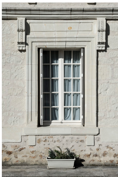
Baie du rez-de-chaussée Phot. Bruno Rousseau, Phot. Youenn Communeau IVR52_20114900691NUCA
