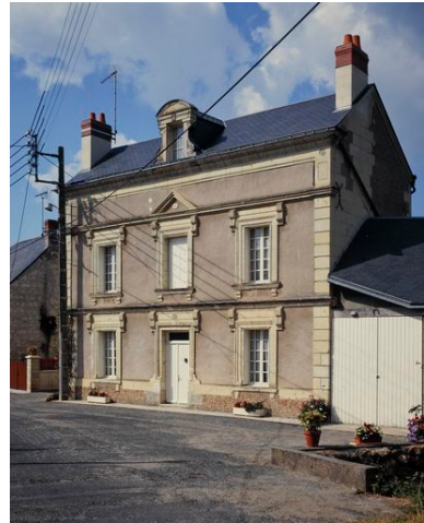
Vue générale de la maison, avec ses enduits (en 1996). Phot. Bruno Rousseau IVR52_19964901430VA
