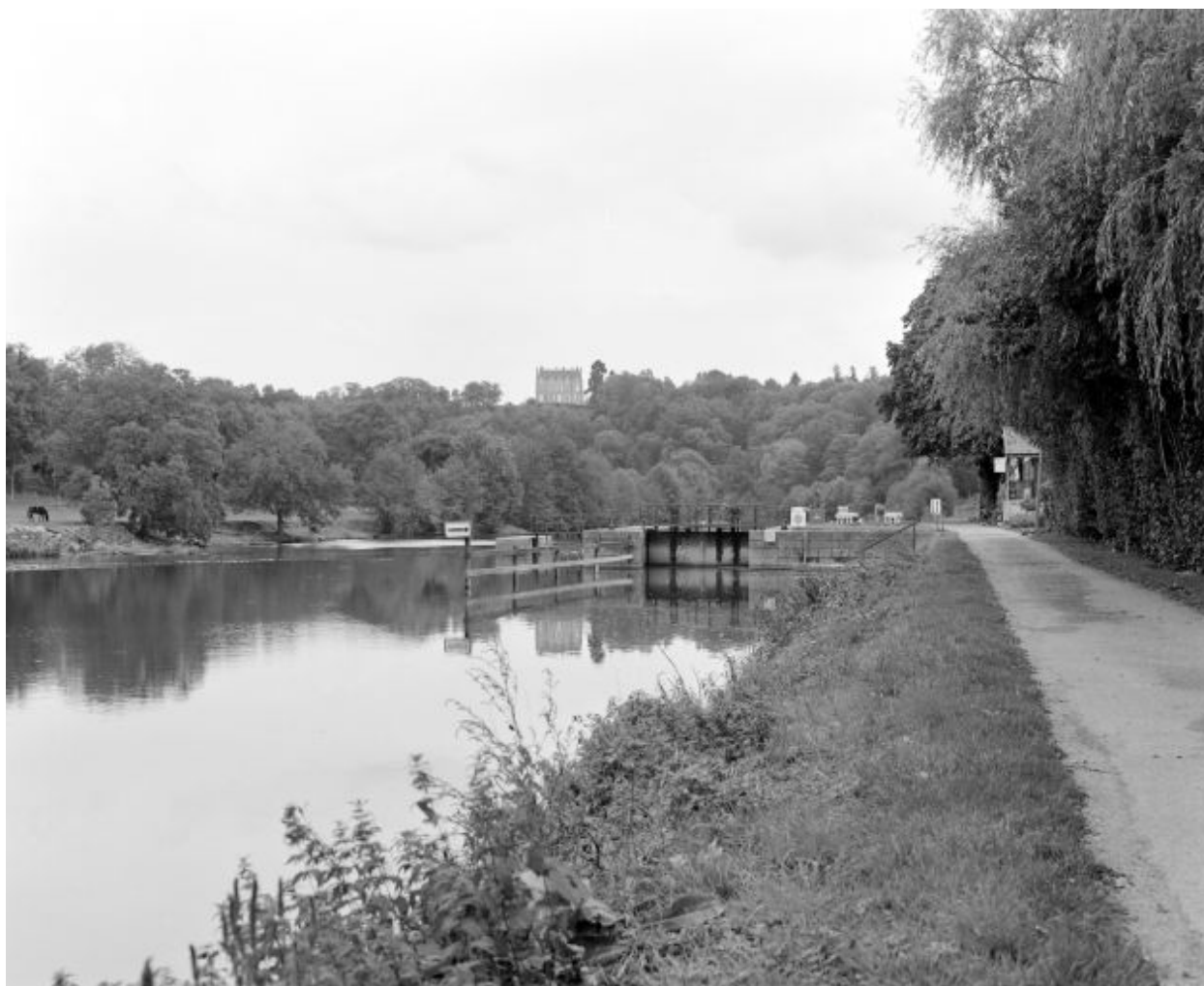
Vue d'ensemble depuis le chemin de halage, rive droite, en amont : barrage, pertuis, écluse. A l'arrière-plan, le château de la Roche.
