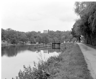
Vue d'ensemble depuis le chemin de halage, rive droite, en amont : barrage, pertuis, écluse. A l'arrière-plan, le château de la Roche.
