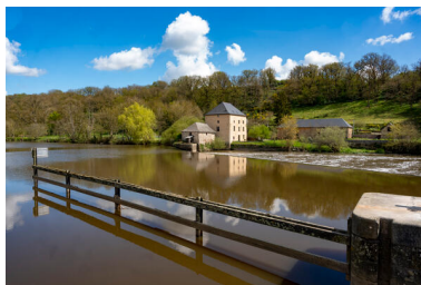
Le barrage de l'écluse. Phot. Pierre-Bernard Fourny IVR52_20225300439NUCA
