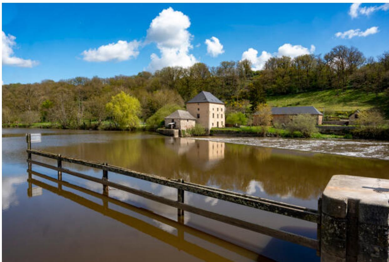
Le barrage de l'écluse.
