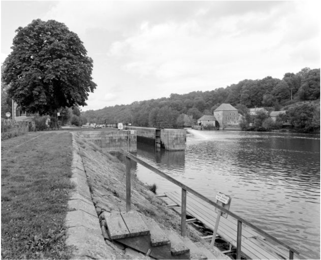
Vue d'ensemble depuis le chemin de halage, rive droite, en aval : maison éclusière, écluse, barrage, moulin.
