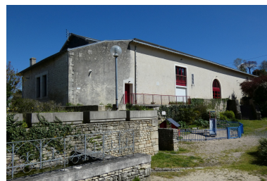
La halle vue depuis l'ouest. Phot. Yannis Suire IVR52_20238501279NUCA
