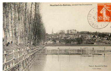
Le bourg de Montfort depuis les bords de l'Huisne, carte postale du début du XXe siècle. Phot. Pierre-Bernard Fourny IVR52_20197201024NUCA
