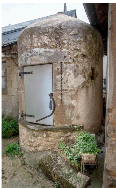
Un puits de cour commune. Phot. Pierre-Bernard Fourny IVR52_20197200894NUCA
