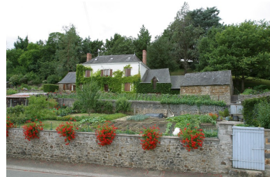
Vue d'ensemble du 3, rue creuse, depuis la route de Saint-Pierre à l'est : l'ancienne maison devenue resserre est à droite. Phot. François Lasa IVR52_20035302380NUCA
