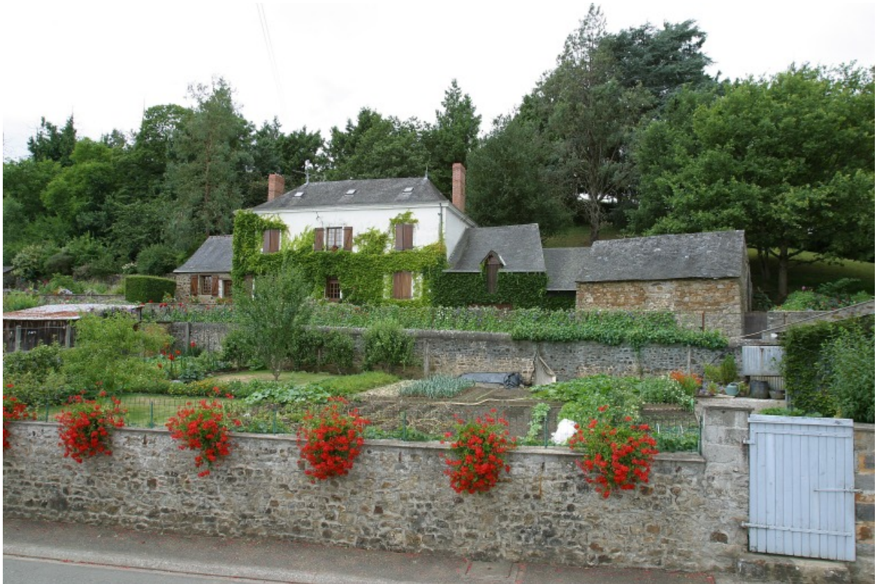
Vue d'ensemble du 3, rue creuse, depuis la route de Saint-Pierre à l'est : l'ancienne maison devenue resserre est à droite.
