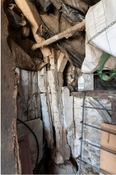
Grange-étable occidentale, ferme centrale, poteau ouest. Phot. Thierry Seldubuisson IVR52_20235300419NUCA
