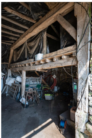
Grange-étable occidentale, ferme nord, vue depuis l'ouest. Phot. Thierry Seldubuisson IVR52_20235300418NUCA
