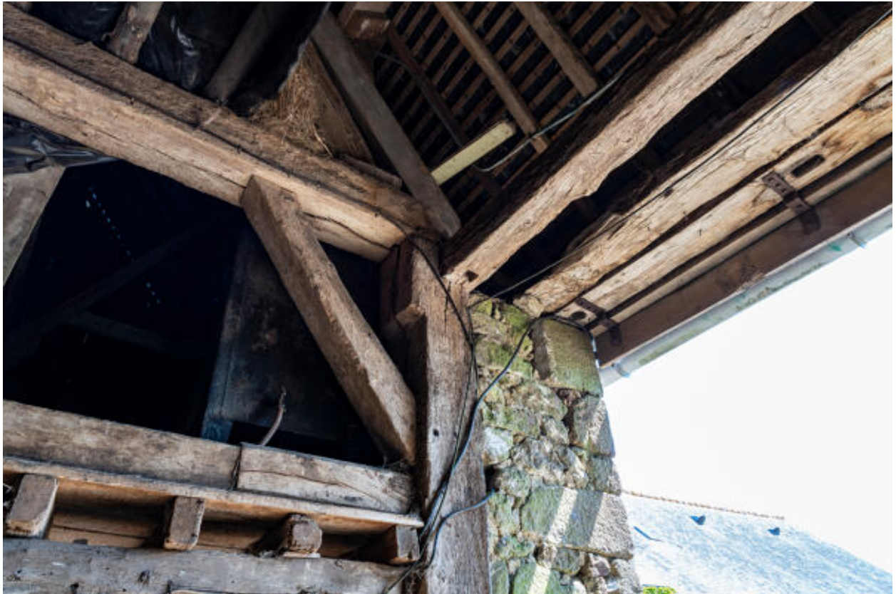
Grange-étable occidentale, ferme nord, poteau est.
