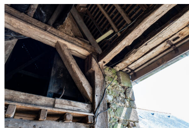
Grange-étable occidentale, ferme nord, poteau est. Phot. Thierry Seldubuisson IVR52_20235300420NUCA
