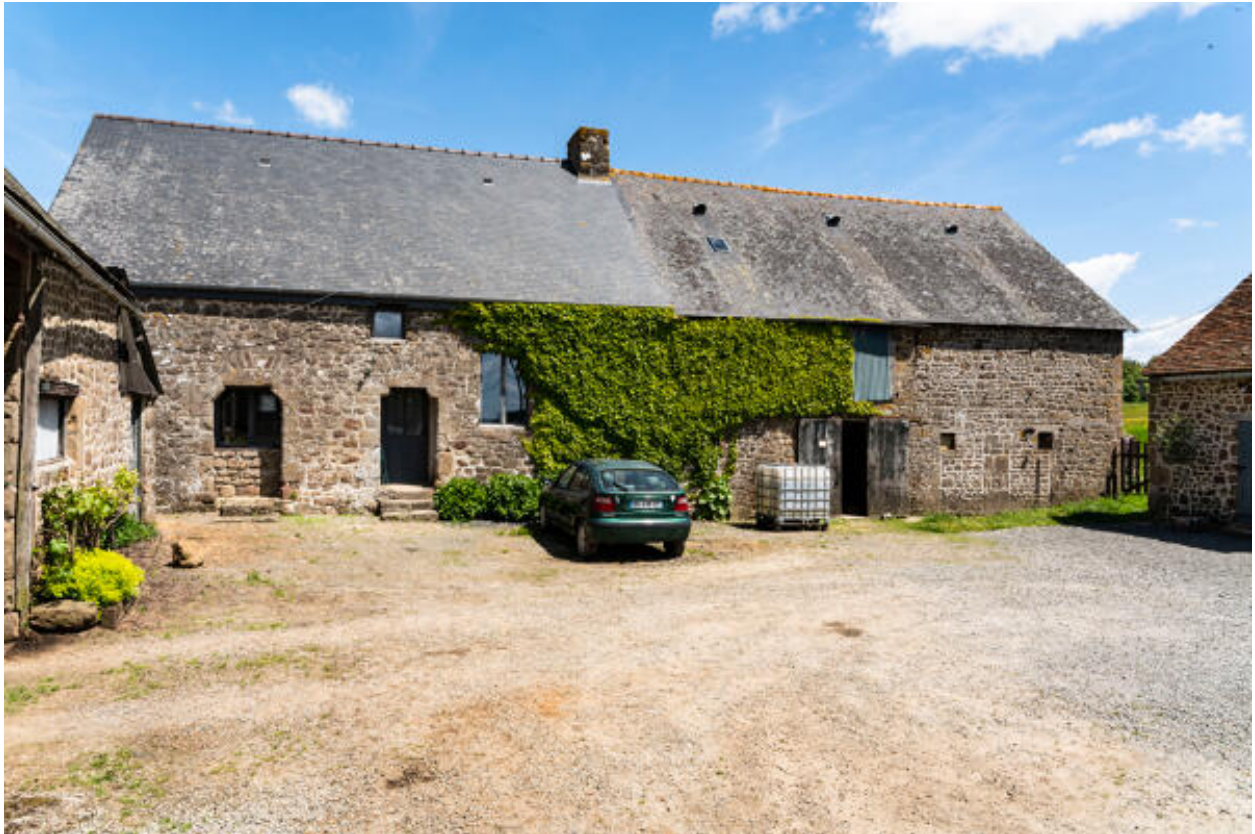
Logis nord, façade sud.
