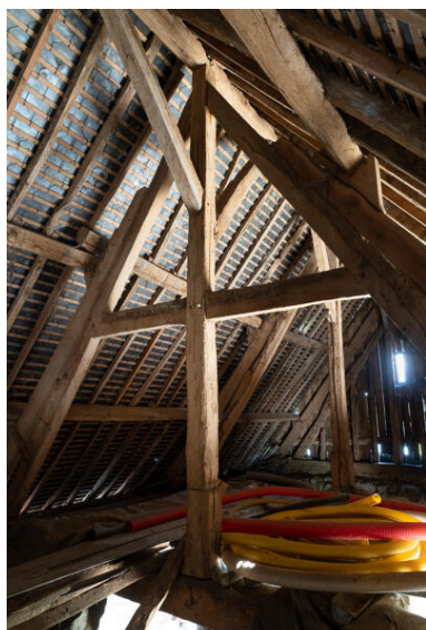
Grange-étable occidentale, ferme centrale, vue depuis le sud. Phot. Thierry Seldubuisson IVR52_20235300421NUCA
