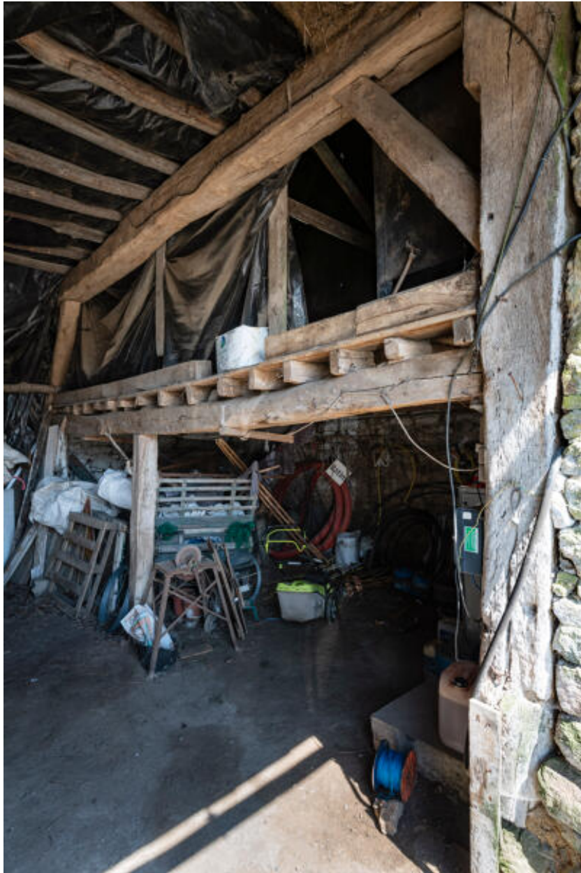
Grange-étable occidentale, ferme nord, vue depuis l'ouest.
