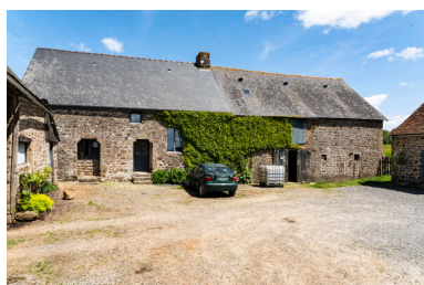
Logis nord, façade sud. Phot. Thierry Seldubuisson IVR52_20235300423NUCA
