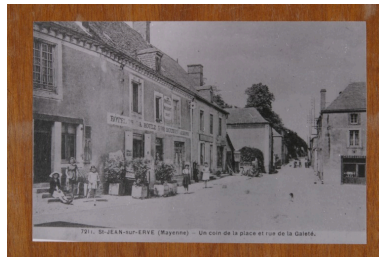
Carte postale, vers 1946. Vue de la place de l'église depuis le sud-ouest. A droite, une partie de la façade de la maison donnant sur la place. Phot. François Lasa IVR52_20035302563NUCA
