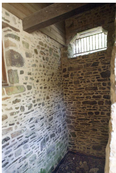
Le coursier où prenaient place les roues vu depuis l'aval à l'ouest. Phot. François Lasa IVR52_20055300399NUCA
