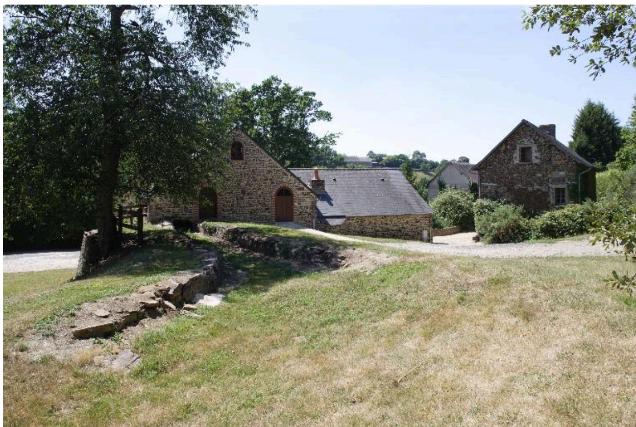
Le moulin et son logis, la remise et l'ancienne étable vus depuis l'emplacement du canal d'alimentation à l'est.
