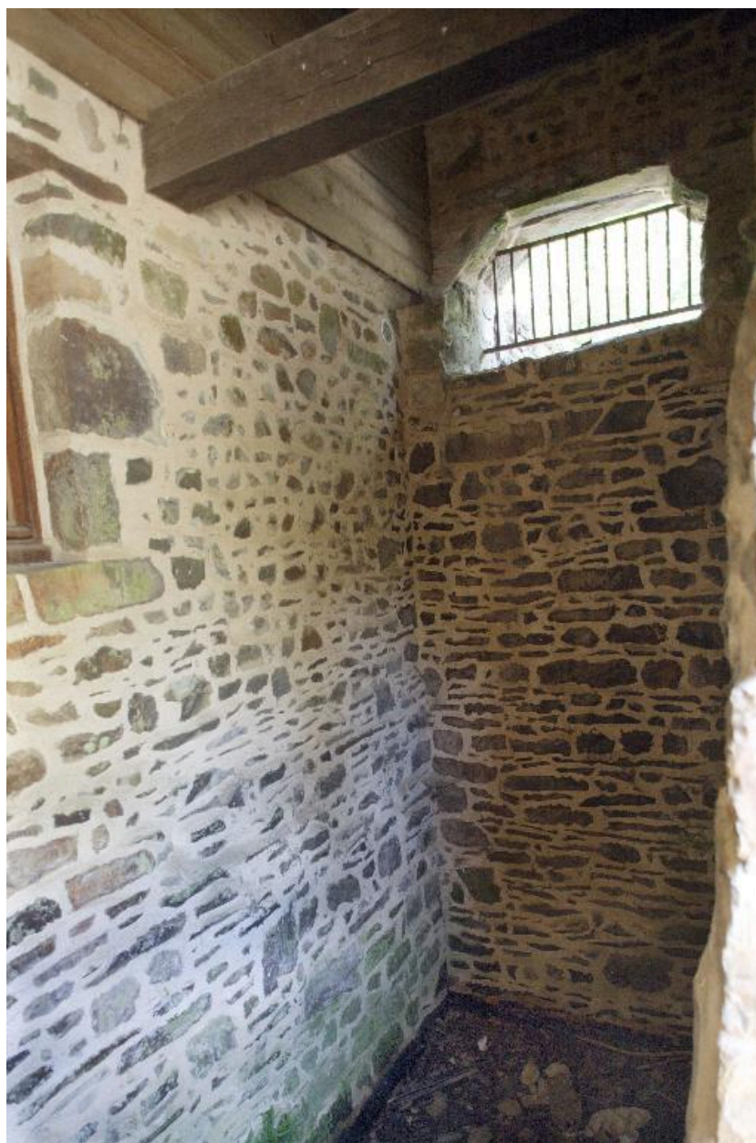
Le coursier où prenaient place les roues vu depuis l'aval à l'ouest.
