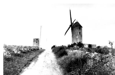
Vue d'ensemble des deux moulins-tours du Lion, dit Vieux-Moulin (à
