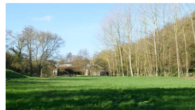
Site des moulins à eau de Châteaupanne, vue de l'est, Montjean-sur-Loire. Phot. Armelle Maugin IVR52_20244900276NUCA
