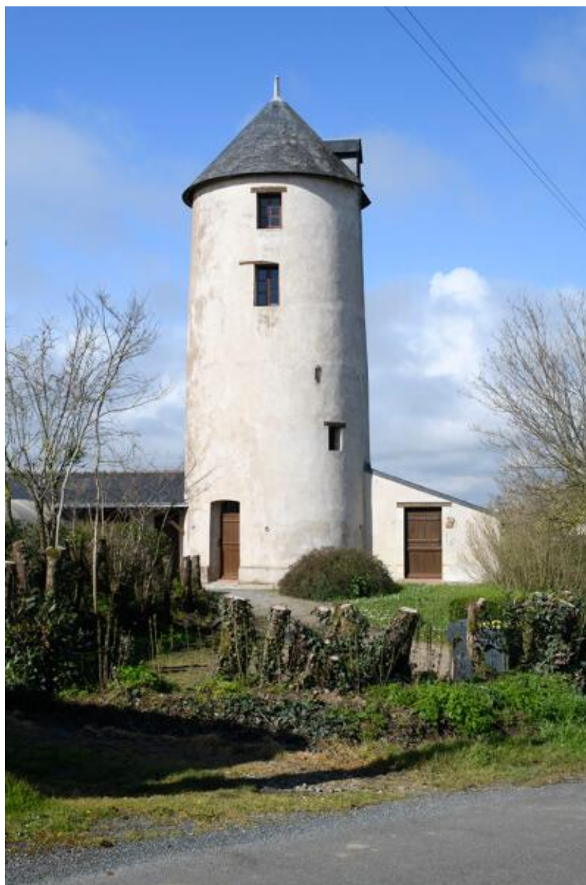
Façade principale, moulin-tour du Lion dit Moulin-Neuf, Montjean-sur-Loire.
