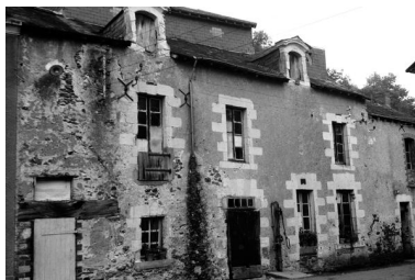
Façade principale du logis du moulin à eau de Châteaupanne, Montjean-sur-Loire. Phot. Marie-Anne Eon IVR52_19724900389Z
