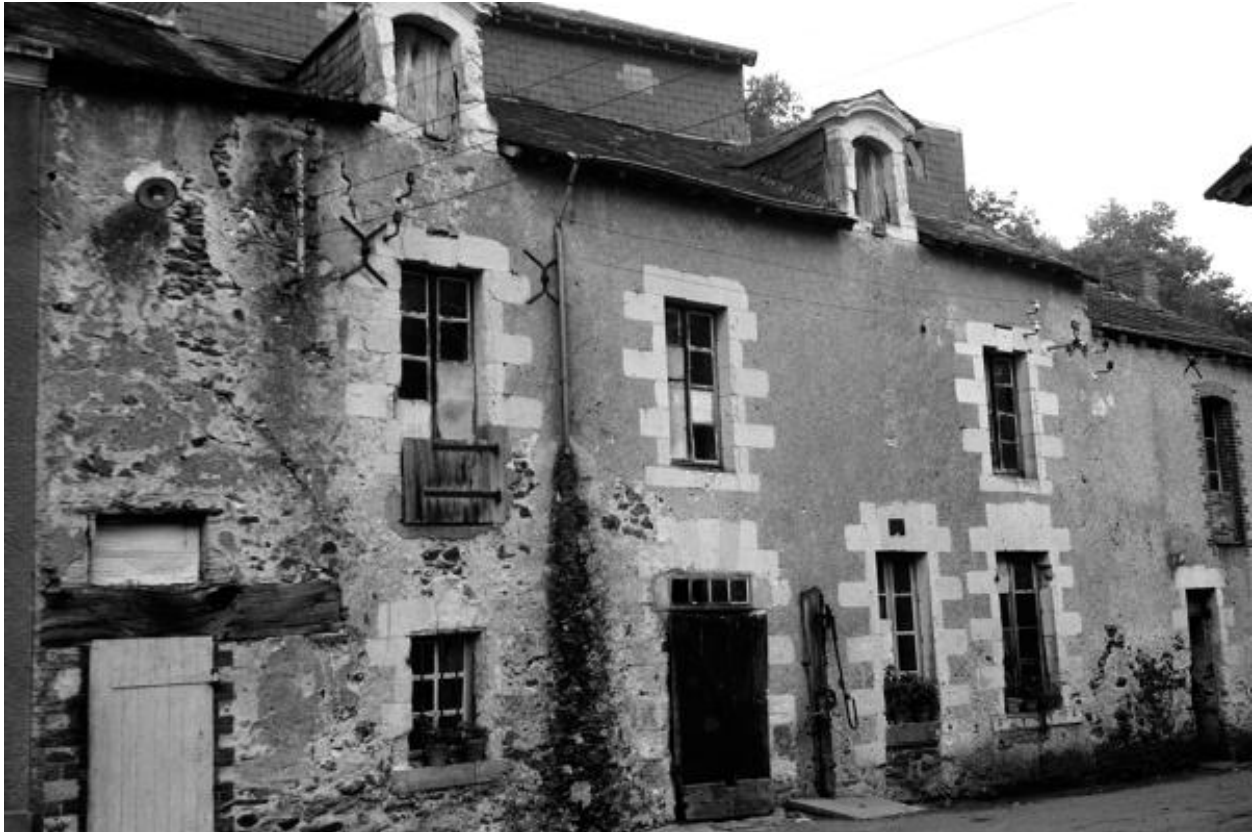
Façade principale du logis du moulin à eau de Châteaupanne, Montjean-sur-Loire.
