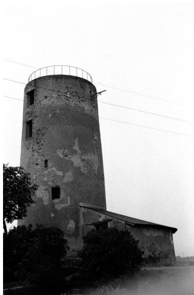
Moulin-tour du Lion dit Moulin- Neuf, avant restauration de sa toiture, Montjean-sur-Loire. Phot. Marie-Anne Eon IVR52_19724900387Z
