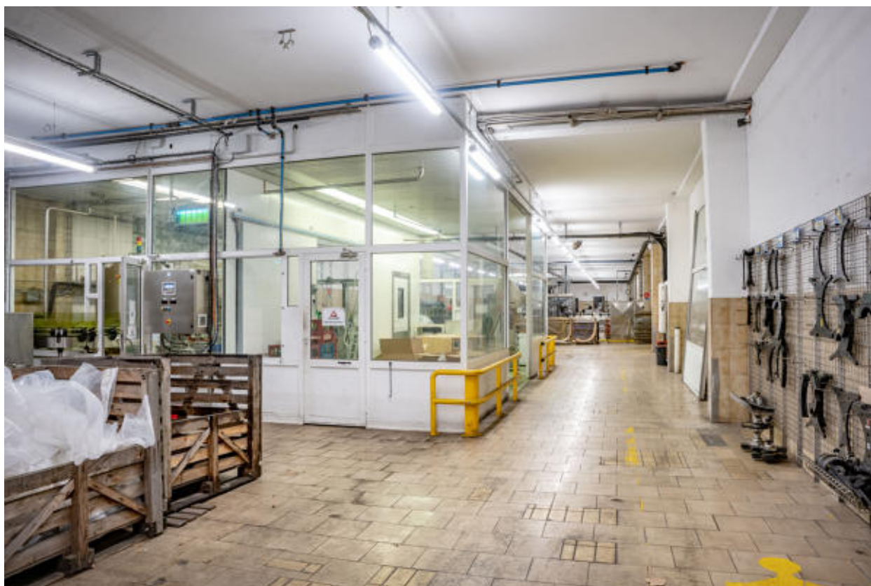
À gauche, salle de tirage, à droite, salle d'embouteillage, vue du sud.
