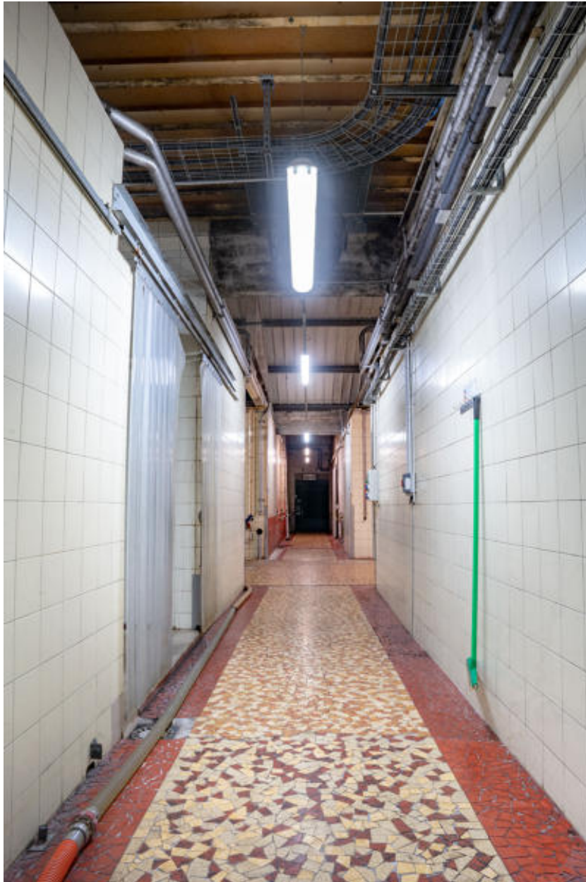
Couloir nord desservant les cuvages et les entrepôts.
