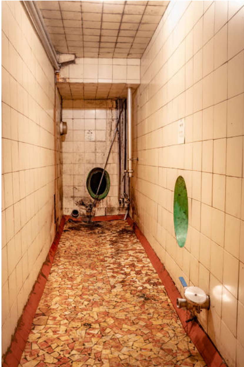
Couloir de service : accès aux cuves enterrées sud.
