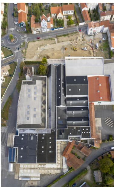
Vue des bâtiments de production depuis le sud. Phot. Pierre-Bernard Fourny IVR52_20224400315NUCA
