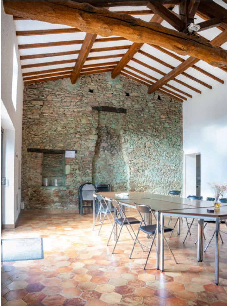
Salle de réunion, aménagée dans une ancienne maison d'habitation, vue de l'est.
