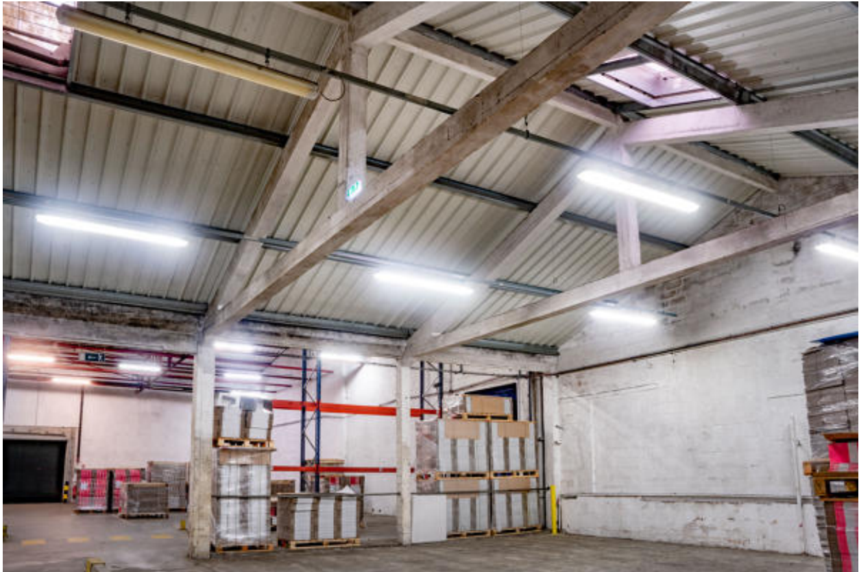
Espace de stockage et sa charpente en béton de mâchefer, vue de l'est.
