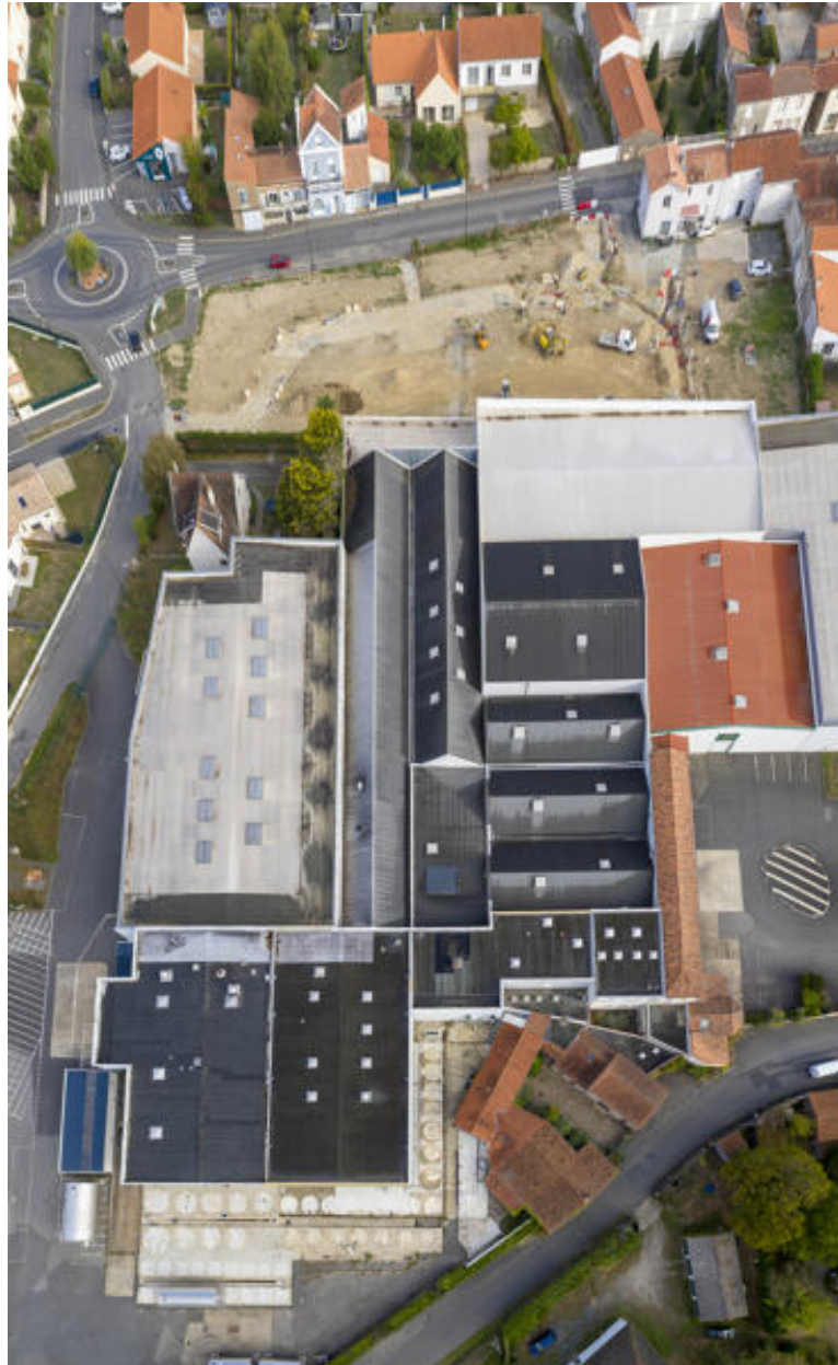
Vue des bâtiments de production depuis le sud.
