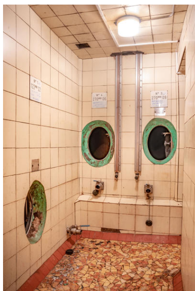
Couloir de service : accès aux cuves enterrées nord-est. Phot. Pierre-Bernard Fourny IVR52_20214401055NUCA
