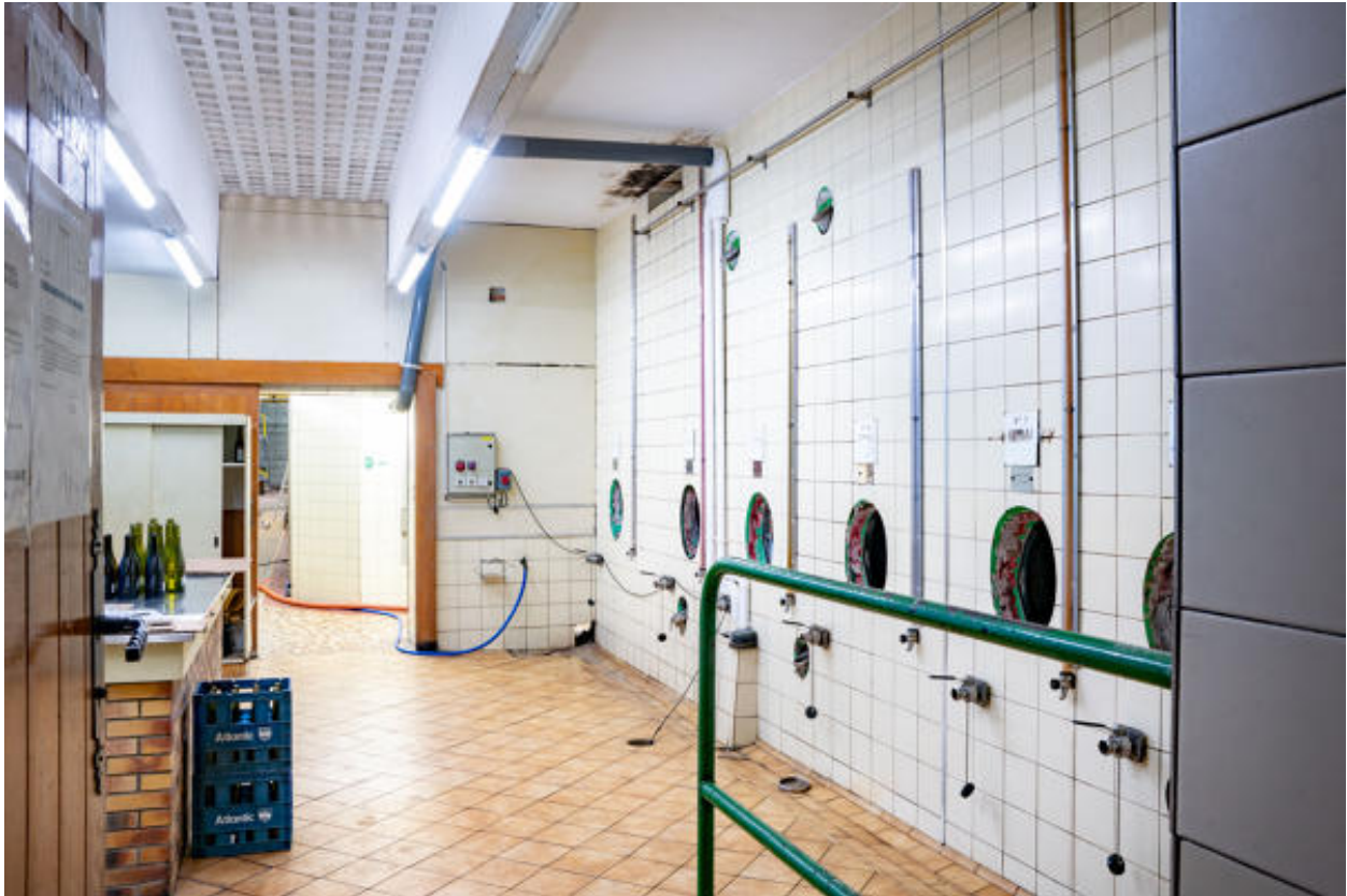
Cuves aériennes, nord-est.
