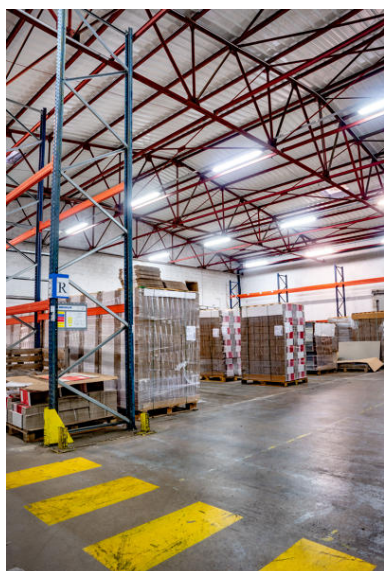
Entrepôt ouest et sa charpente métallique. Phot. Pierre-Bernard Fourny IVR52_20214401032NUCA
