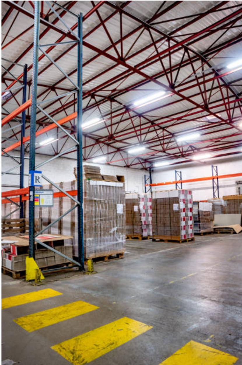
Entrepôt ouest et sa charpente métallique.
