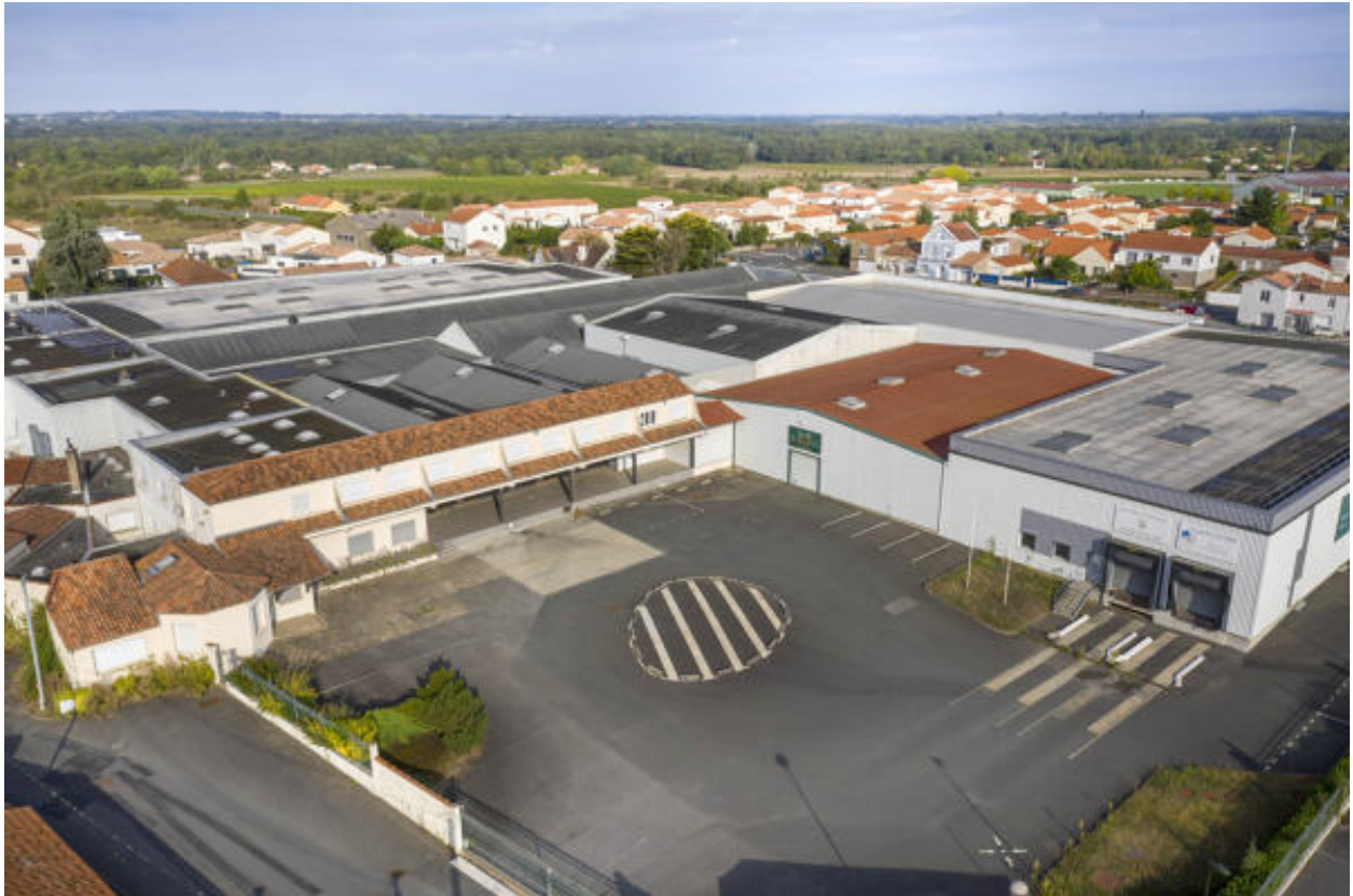
Vue de la cour principale et des quais depuis l'est.
