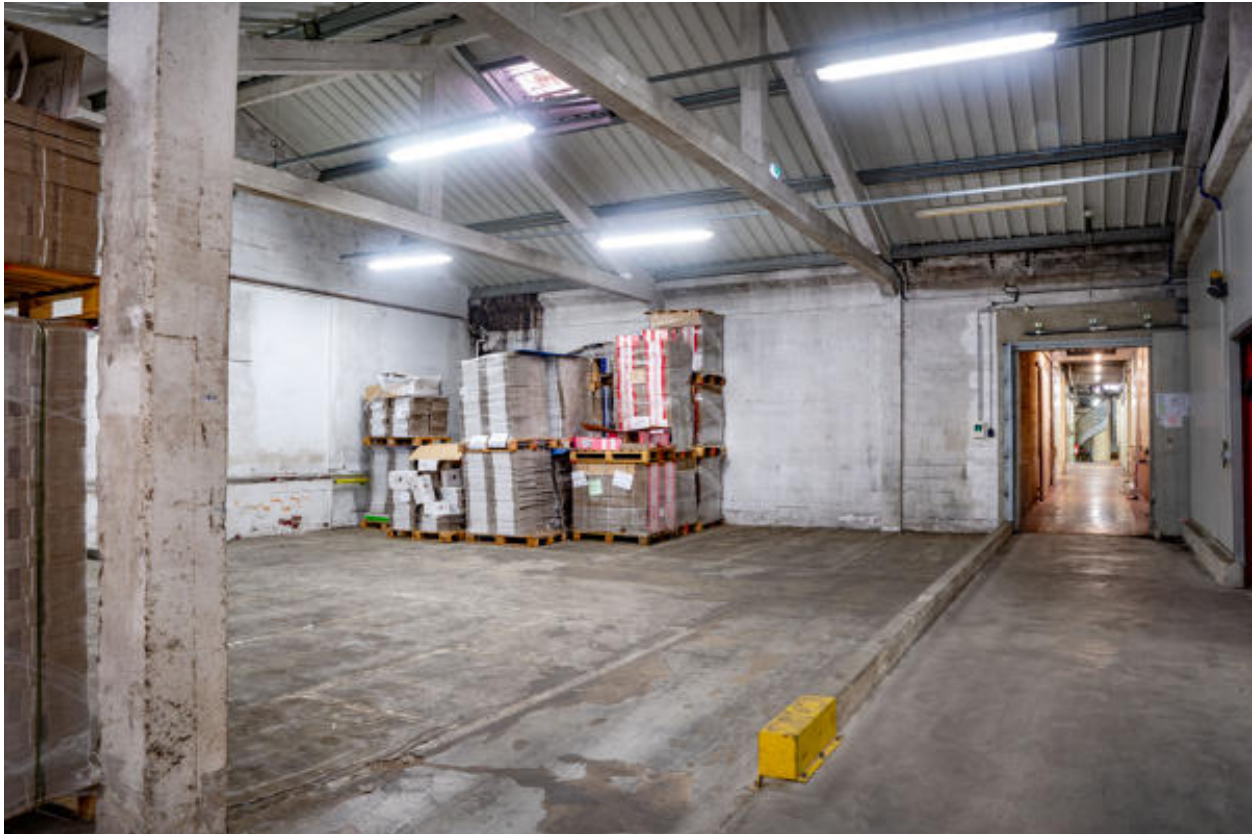
Espace de stockage et sa charpente en béton de mâchefer, vue de l'ouest.
