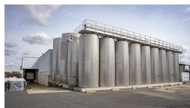
Cuverie, au sud du site. Phot. Pierre-Bernard Fourny IVR52_20214400316NUCA
