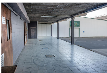
Quai de déchargement des vins ; trappes des cuves enterrées nord. Phot. Pierre-Bernard Fourny IVR52_20214401056NUCA
