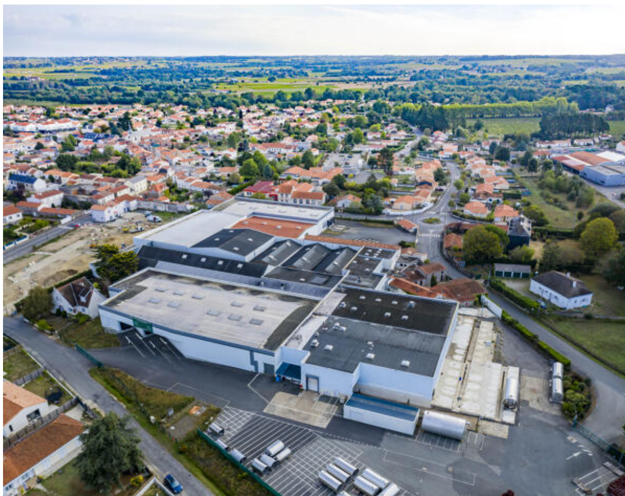
Vue des bâtiments de production depuis l'ouest.
