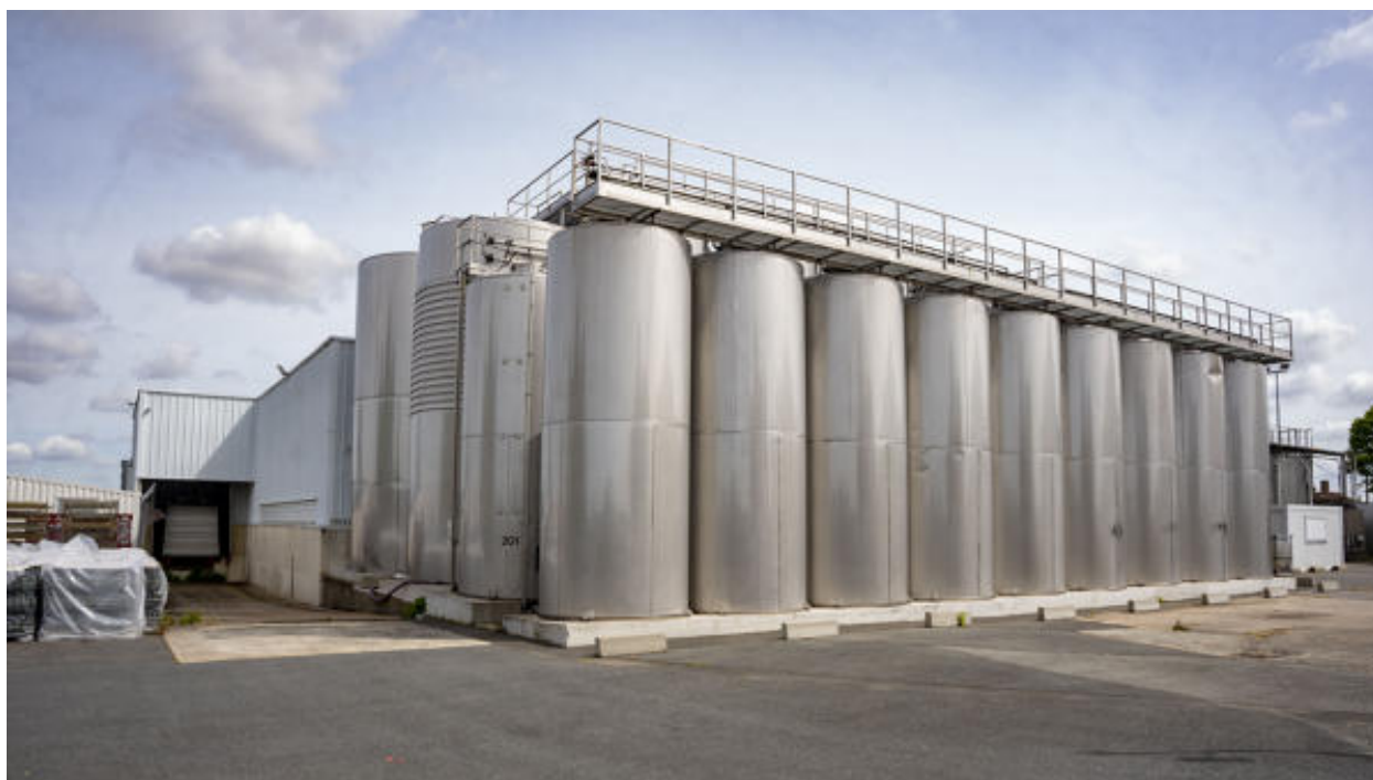
Cuverie, au sud du site.
