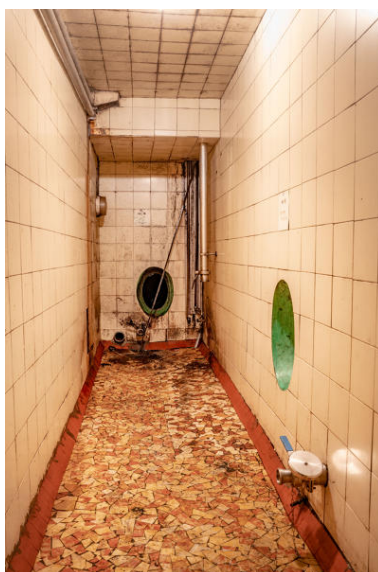
Couloir de service : accès aux cuves enterrées sud. Phot. Pierre-Bernard Fourny IVR52_20214401053NUCA
