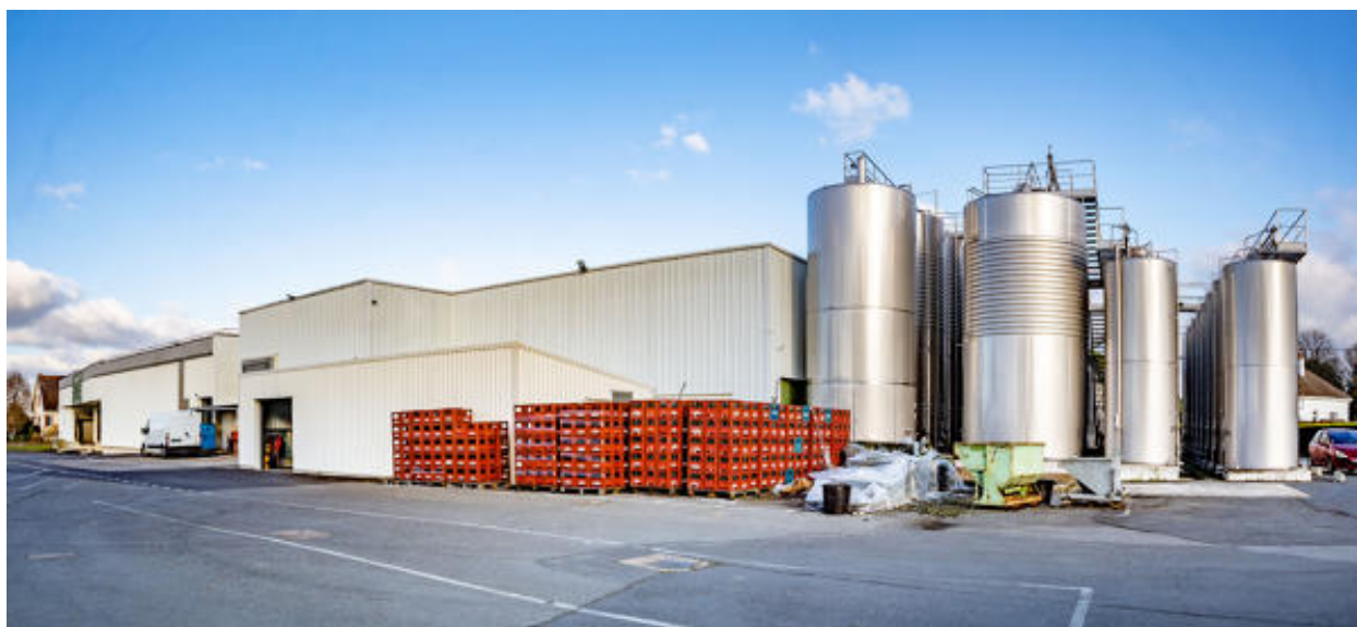
Angle sud-ouest du bâtiment. Cuvierie.
