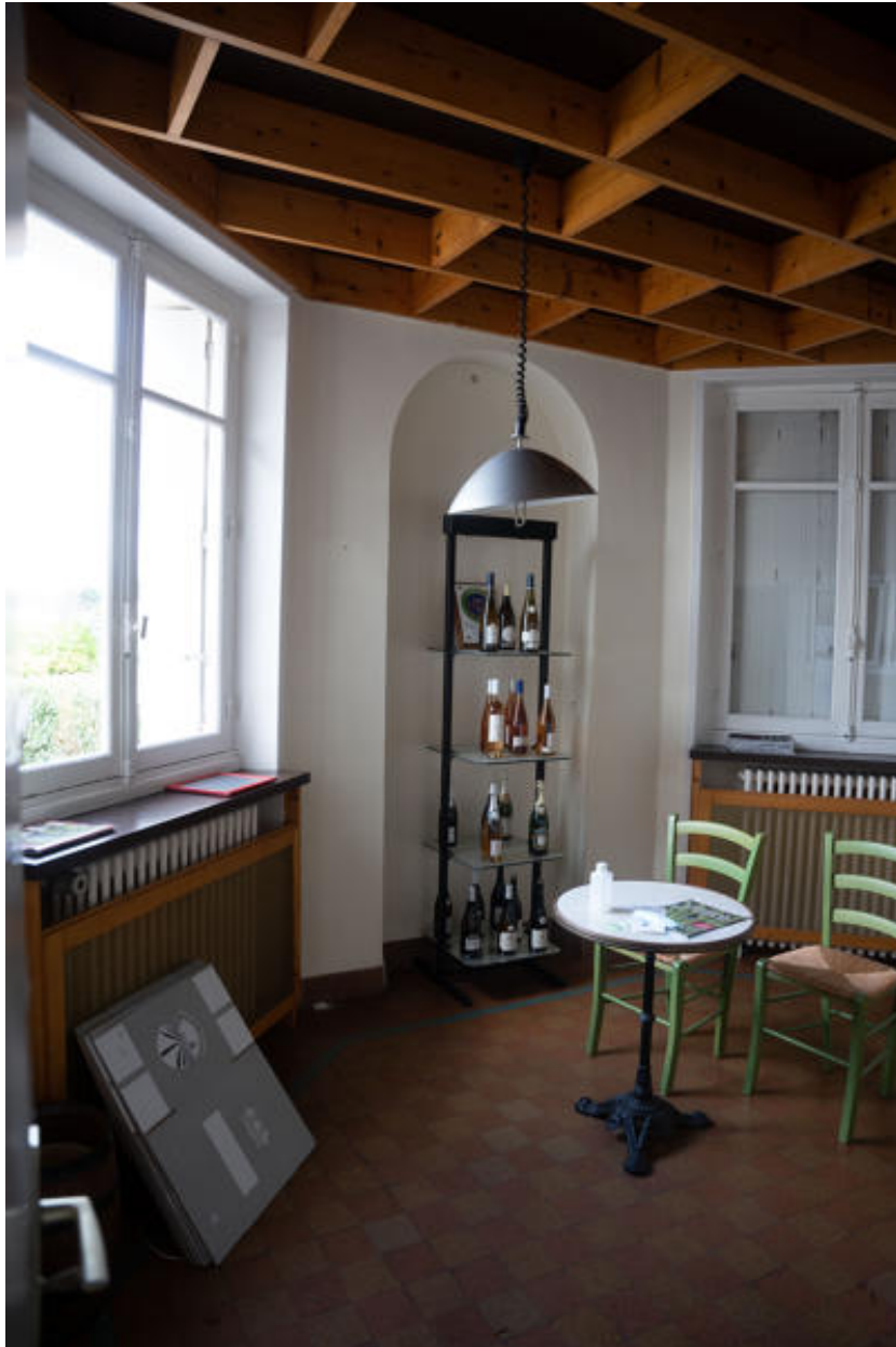
Vestibule d'accès aux bureaux.
