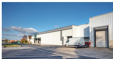
Quais de déchargement des matières premières. Phot. Pierre-Bernard Fourny IVR52_20214401045NUCA
