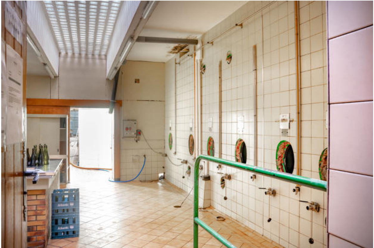
Cuves aériennes, nord-est.
