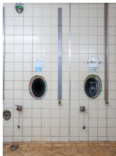
Cuves aériennes, nord-est. Phot. Pierre-Bernard Fourny IVR52_20214401019NUCA
