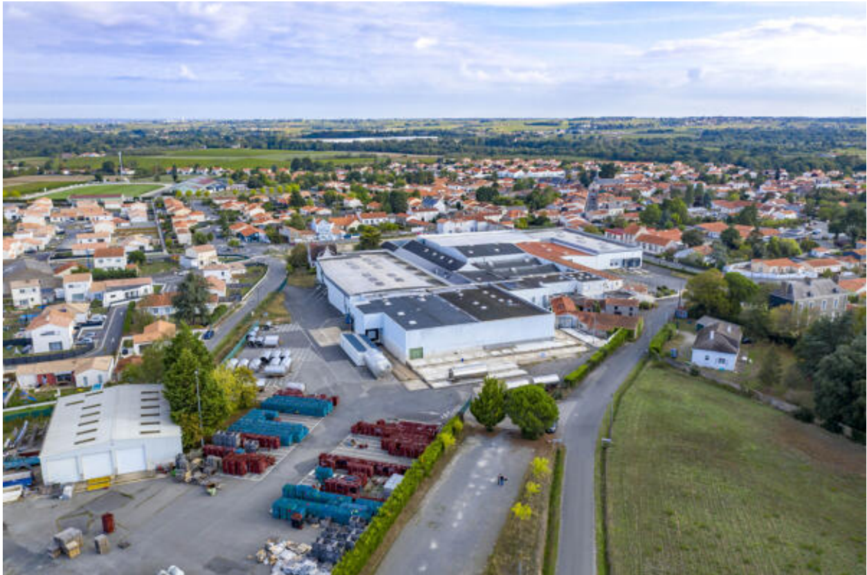
Vue générale du site depuis le sud-ouest.
