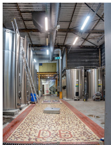
Cuverie et cuves inox. Phot. Pierre-Bernard Fourny IVR52_20214401041NUCA
