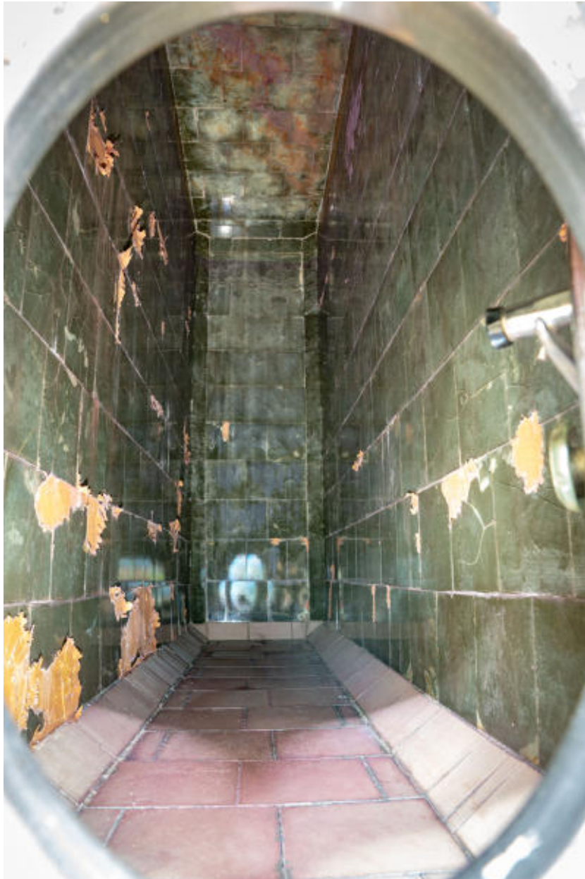
Intérieur d'une cuve aérienne verrée.
