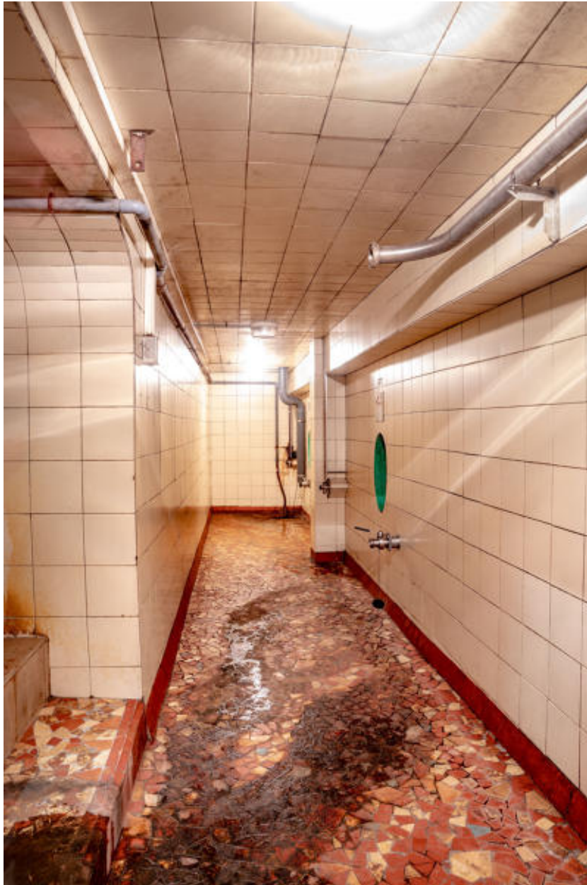
Couloir de service : accès aux cuves enterrées nord-ouest.
