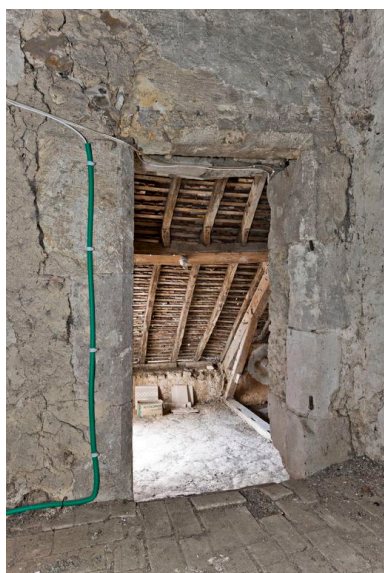
Porte d'accès à l'étage Phot. Yves Guillotin IVR52_20137200401NUCA
