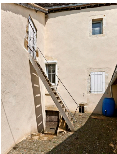
Elevation ouest Phot. Yves Guillotin IVR52_20137200426NUCA
