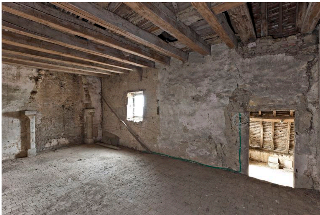
Vue intérieure de l'étage
