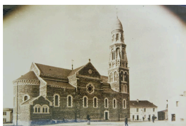
L'église actuelle : élévation nord, en 1896. La seconde sacristie n'est pas encore construite. Repro. Yves Guillotin IVR52_20104401531NUCA
