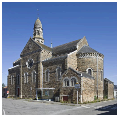
L'élévation sud, flanquée de la seconde sacristie édifiée en 1898.
