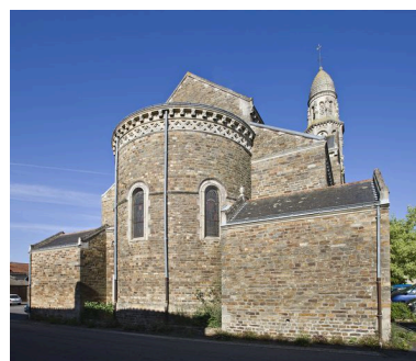
Le chevet : l'abside du chœur avec sa corniche ornée. Phot. Yves Guillotin IVR52_20114400575NUCA
