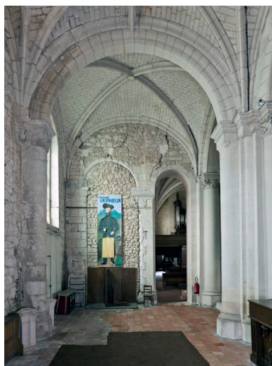
Chapelle axiale sud, mur ouest : vestiges d'arcature. Phot. Yves Guillotin IVR52_20117200880NUCA
