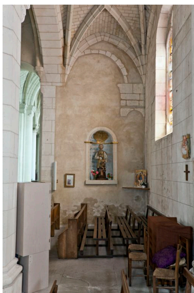
Bas-côté sud : revers de l'arcature de la chapelle axée sud. Phot. Yves Guillotin IVR52_20117200882NUCA
